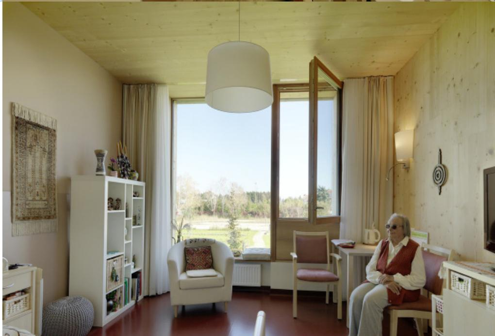
“Las dos plantas superiores del edificio son totalmente estructuradas en madera. Láminas de madera cruzadas en las paredes y el techo contribuyen con el soporte de carga, con las superficies de madera quedando visible en su mayor parte. Con el fin de lograr el ambiente acogedor y espacioso, se utilizaron vigas de madera en los techos de las salas comunes. Las paredes exteriores están formadas por un marco de madera con aislamiento de lana de roca, con paneles de madera exterior.”<sup>21</sup>
