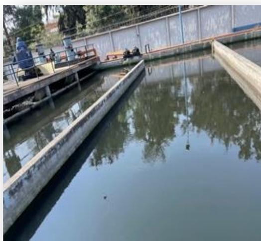
**Figura 16.** Tanque de contacto de cloro.
