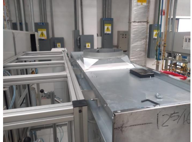
Figura 28. Vista superior del setup
