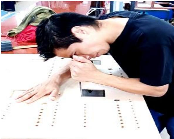
**Sujeción de la mesa inferior y la mesa superior a la estructura metálica con pijas punta de broca.**
