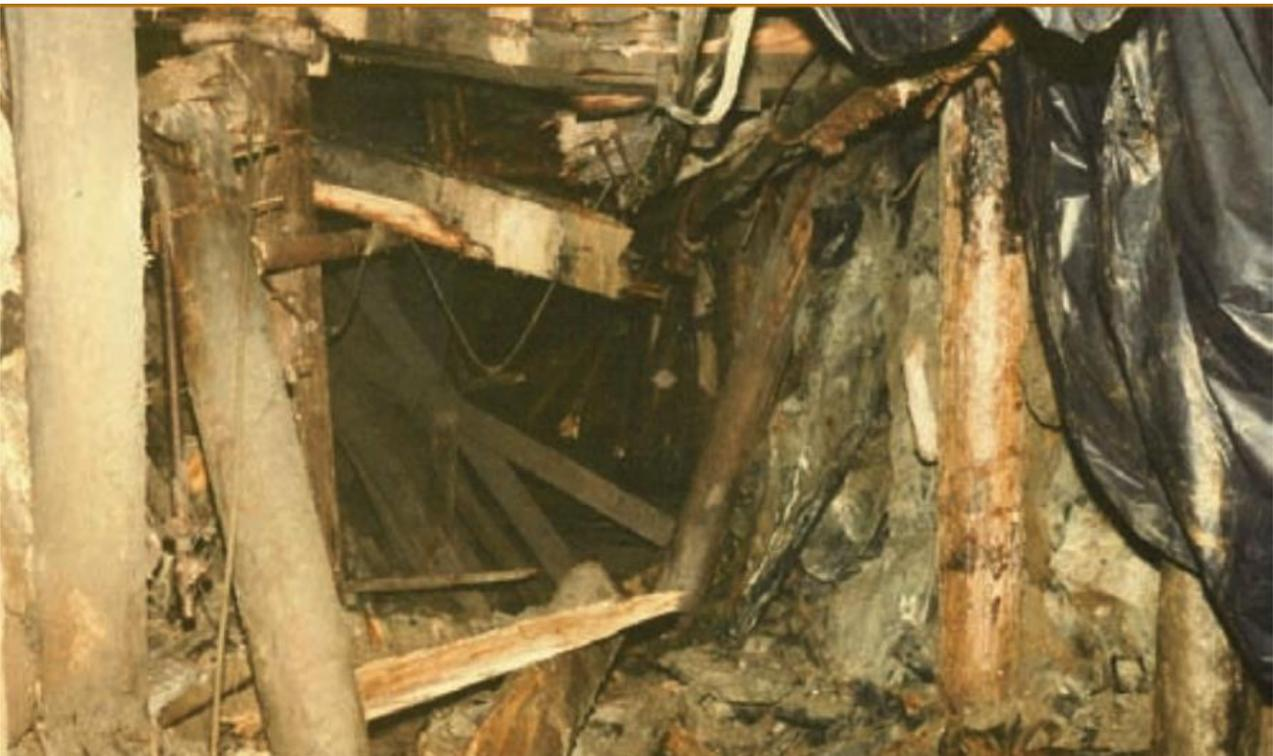
Imagen 10.- Daños por ondas de choque en secciones de madera. Fuente: (Blake & Hedley, 2003)
