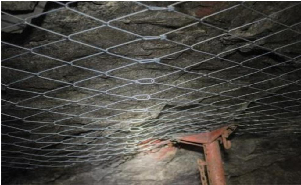
Imagen 50.- Malla romboidal de alambre en excavación de túnel. Fuente: Berrocal Mallqui, M. A. (2015).
