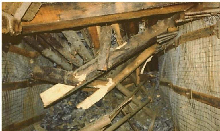
Imagen 7.-Sill drift (Daño en muros y techos de frente de excavación.) Fuente: (Blake & Hedley, 2003)
