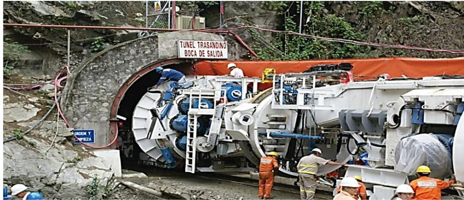
Imagen 58.- TBM en portal de salida con sistema Mcnally integrado. Fuente: Métodos de excavación mecanizada, Universidad Nacional Autónoma de México, Ciudad de México 16 de Abril de 2023.
