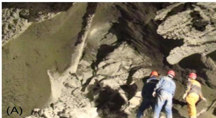
Imagen 4.- Formas de daño por explosión de rocas A) Daño en Forma de “V” Fuente: Feng (2018)
