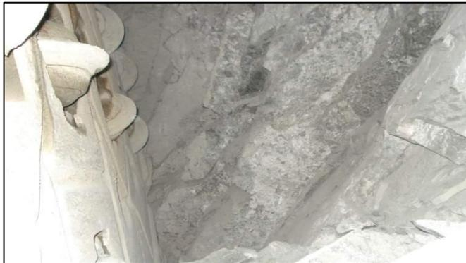
Imagen 56.-Frente de excavación inestable Fuente Gonzalez, Roberto, Métodos de excavación mecanizada, Universidad Nacional Autónoma de México, Ciudad de México 16 de abril de 2021
