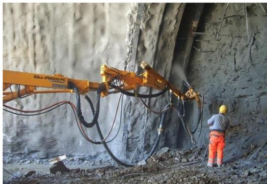
Imagen 49A: Concreto lanzado vía húmeda con brazo robótico Fuente: Berrocal Mallqui, M. A. (2015).
