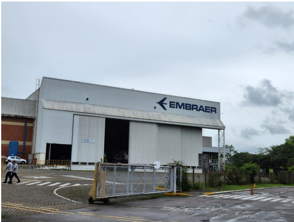
Imagen de las distintas instalaciones con las que cuenta Embraer, capturada el 15 de enero de 2023.
