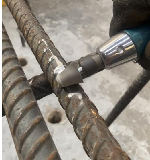
Fig. 2.5.2 Desbaste de la corrugación de una barra (Palma, 2022 - 2023)
