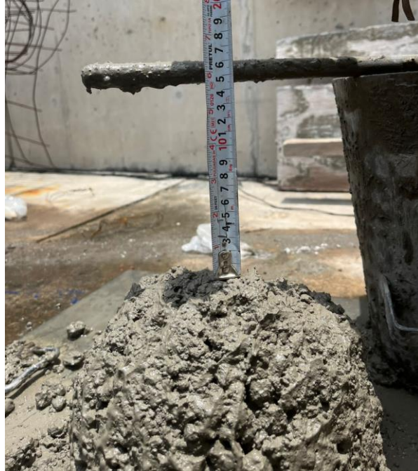
Fig. 2.6.1 Prueba de revenimiento (Instituto de Ingeniería, 2021 - 2023)
