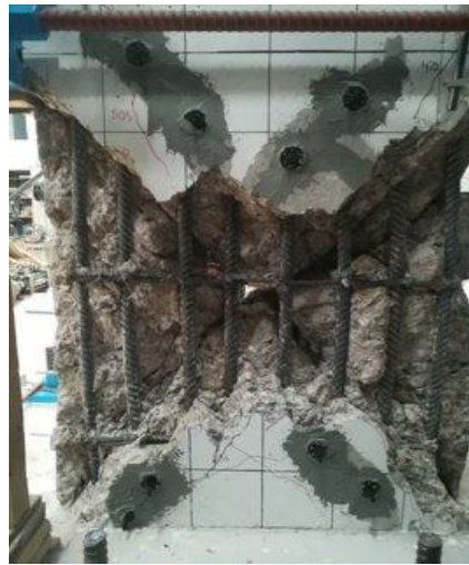
Fig. 3.3.26 Primeros pasos de la rehabilitación - Columna OR (Instituto de Ingeniería, 2021 - 2023)
