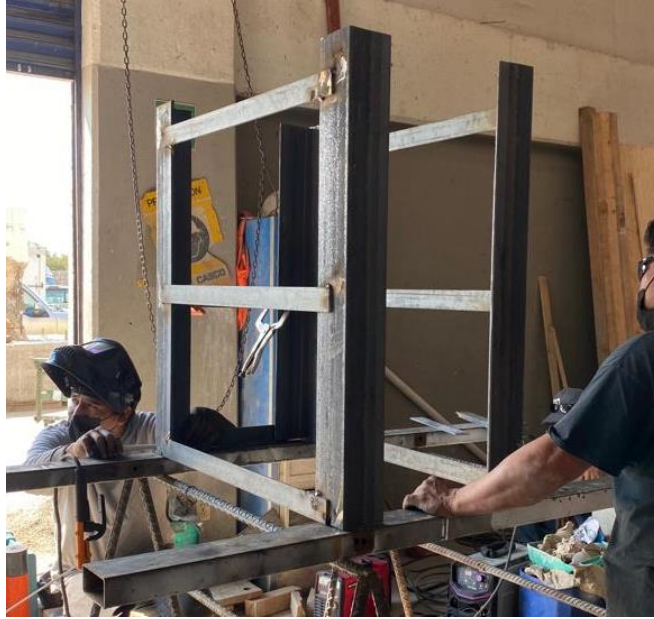
Fig. 2.5.22 Proceso constructivo del encamisado metálico (Palma, 2022 - 2023)
