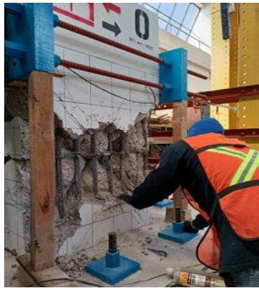
Fig. 3.3.24 Columna OR previo a la rehabilitación (Instituto de Ingeniería, 2021 - 2023)
