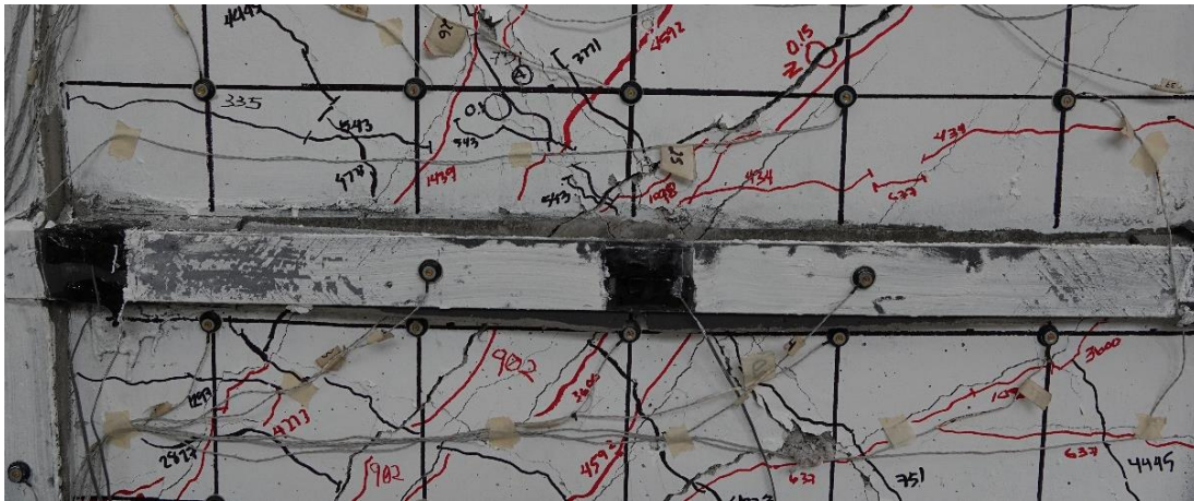
Fig. 3.3.132 Grout cara norte - Columna C-2 (Instituto de Ingeniería, 2021 - 2023)
