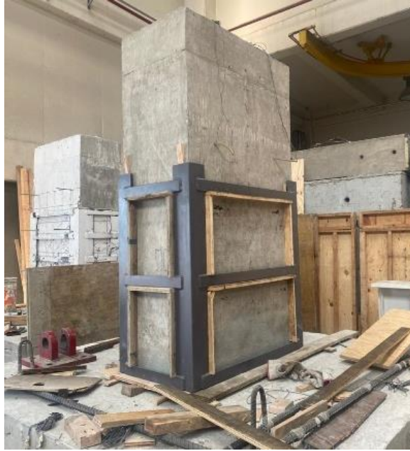
Fig. 2.5.26 Proceso constructivo de la colocación del grout (Palma, 2022 - 2023)
