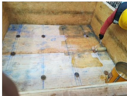
Fig. 2.5.13 Aplicación de aceite desmoldante en la cimbra (Instituto de Ingeniería, 2021 - 2023)
