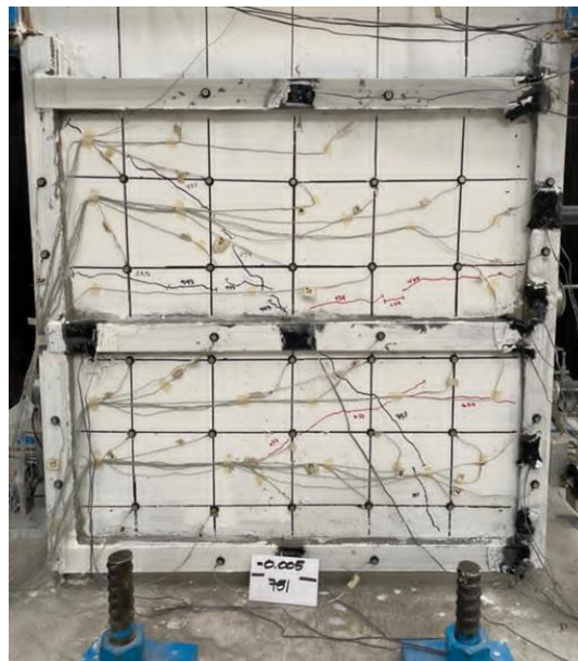
Fig. 3.3.112 Primera aparición de grietas ( R=-0.5\% ) - Columna C-2 (Instituto de Ingeniería, 2021 - 2023)
