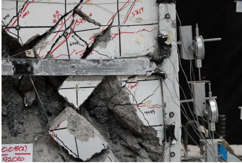
Fig. 3.3.167 Detalle en solera intermedia sección noroeste - Columna C-2 (Instituto de Ingeniería, 2021 - 2023)
