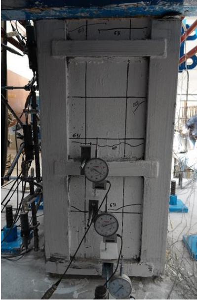
Fig. 3.3.189 Cara este ( R=0.5\% ) - Columna C-4 (Instituto de Ingeniería, 2021 - 2023)
