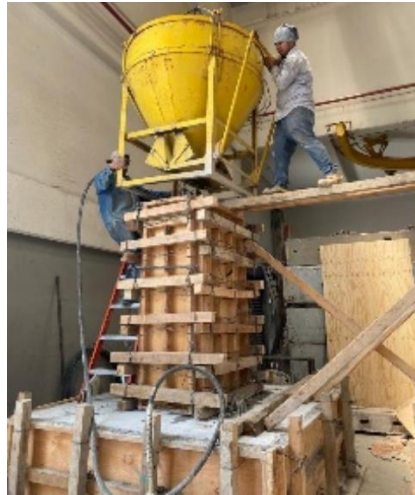
Fig. 2.5.18 Colado de las columnas (Palma, 2022 - 2023)
