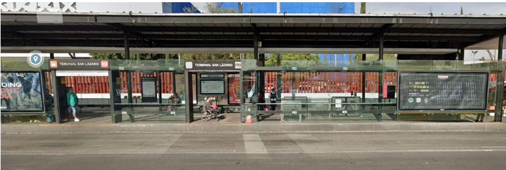
FIG. 6. Observamos el diseño de la terminal de la Línea 4 con muros de vidrio, estructura metálica poco visible y espacios publicitarios. Además de estar casi a la misma altura que la calle, lo que beneficia al ingreso de personas en sillas de ruedas.
