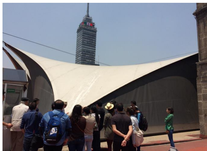
Fig. 13: Velaria del Palacio de Minería, vista exterior.
