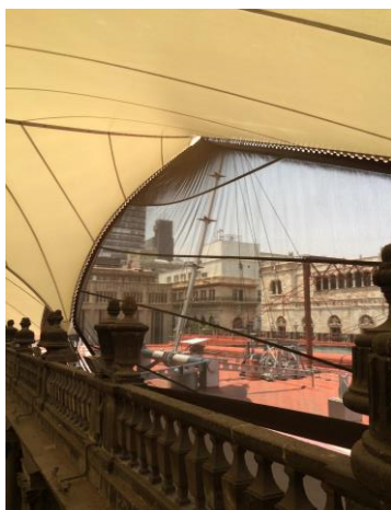
Fig. 12: Vista de uno de los postes principales. Velaria Palacio de Minería
