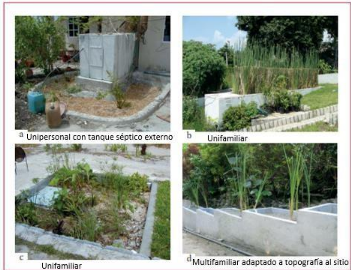
Figura 11. Diferentes humedales artificiales de tipo familiar Tomado de (CONAGUA, Libro 31. Manual de Agua Potable, Alcantarillado y Saneamiento: Diseño de Plantas de Tratamiento de Aguas Residuales Municipales: Zonas rurales, periurbanas y desarrollos ecoturísticos, 2019)
