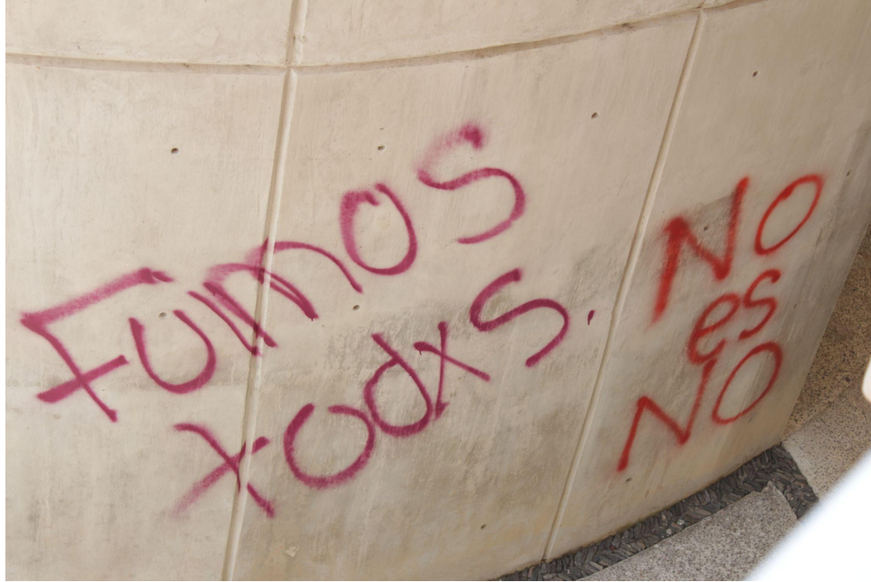
Figura 3. Pinta en escaleras edificio A, ENES Morelia. Fotografía acreditada como anónimo (2019).
