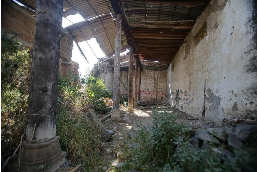
Figura 1.11 Troje oct 2020, se observan columnas que corresponden a troncos de árboles de hasta 6 m de largo, se desplantan sobre una basa de cantera y este a su vez de una cimentación de piedra, en su corona cuentan con una zapata de madera, sobre las zapatas recorre una gualdra del mismo material que atraviesa el local en su sentido más largo, en la parte posterior se observan vigerías que se desplazan hacia los costados de la nave, en los muros laterales se apoyan sobre una viga de arrastre. La cubierta final está conformada por una bóveda de ladrillo.
