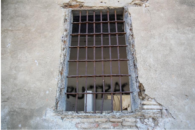
Figura 1.6 Herrería de forja en vano de la fachada norte del conjunto Hacienda de Guadalupe, posiblemente el local pertenecía a la vigilancia al ubicarse entre el acceso principal y a tienda de raya. La foto fue tomada en octubre del año 2020, cuando aún podíamos apreciarla en su lugar, al igual que otras más en el resto del conjunto. Para enero del año 2022 esta herrería ha sido retirada del vano y muy posiblemente vendida por kilo. Según el Dr. Prado, la Herrería de forja que se instaló para el siglo XVI y XVII en México, era exportada de Europa ya que en esa época no se fundía mineral de hierro en la nueva España. Por la autora, año: 2021.
