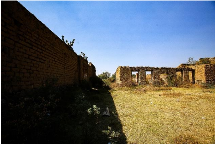
Figura 2.14 Patio de Maniobra al sur del conjunto, se observa el muro sur, y la puerta peatonal, que pudo estar dirigida a la entrada de empleados, y al fondo uno de los dos corrales que se localizan en este patio. Foto por Alex Herrera, año 2020.
