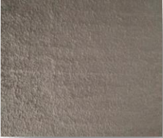
PLAFÓN CON BASTIDOR CON ACABADO EN TIROL Y PINTURA BEIGE.
