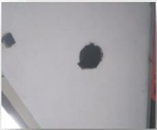
PLAFÓN CON BASTIDOR CON ACABADO EN TIROL CON PINTURA BLANCA.
