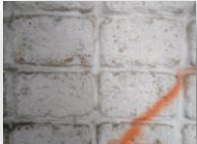
MURO DE LADRILLO DE 22 X 12 CMS.
