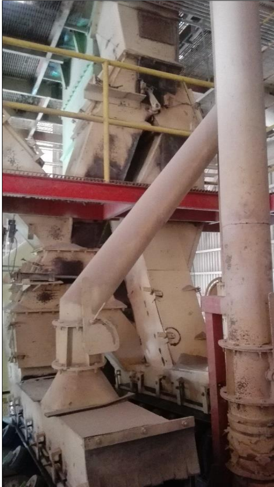
Figura 42 Descarga de elevadores nos. 2 y 3, existente
