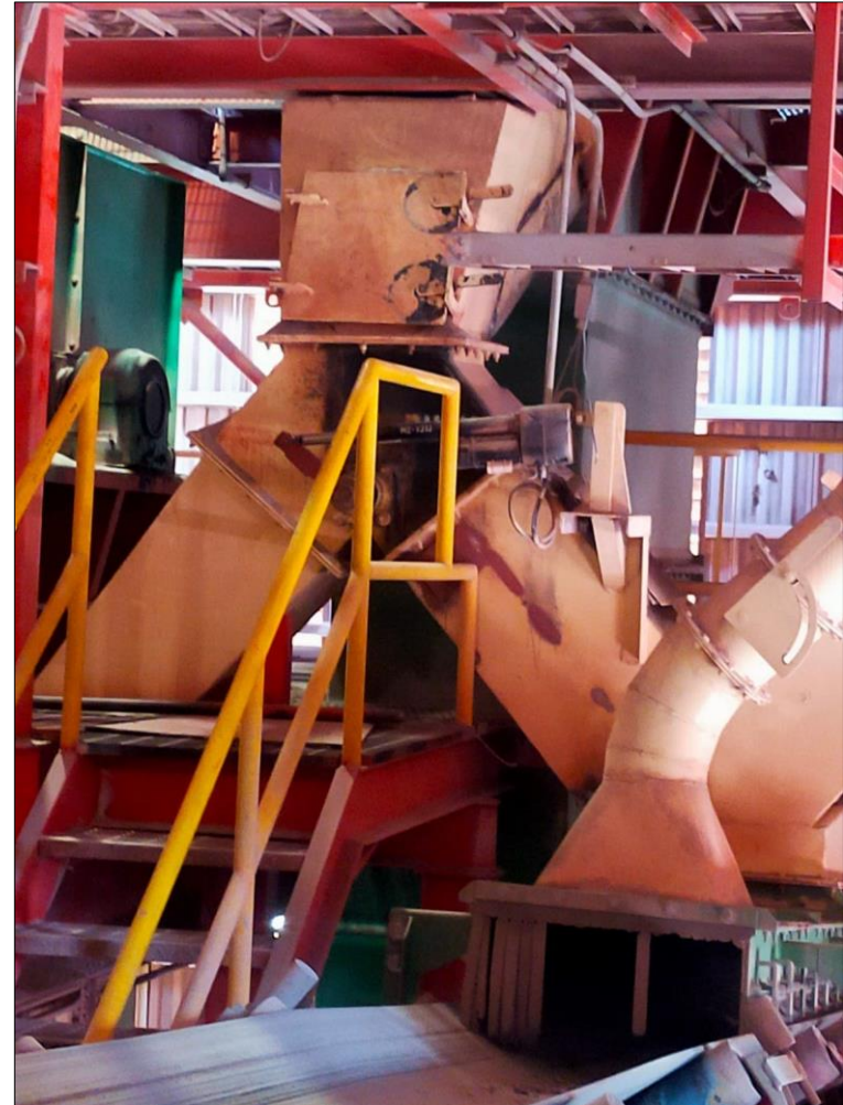
Descarga de elevadores nos. 2 y 3, proyecto nuevo.
