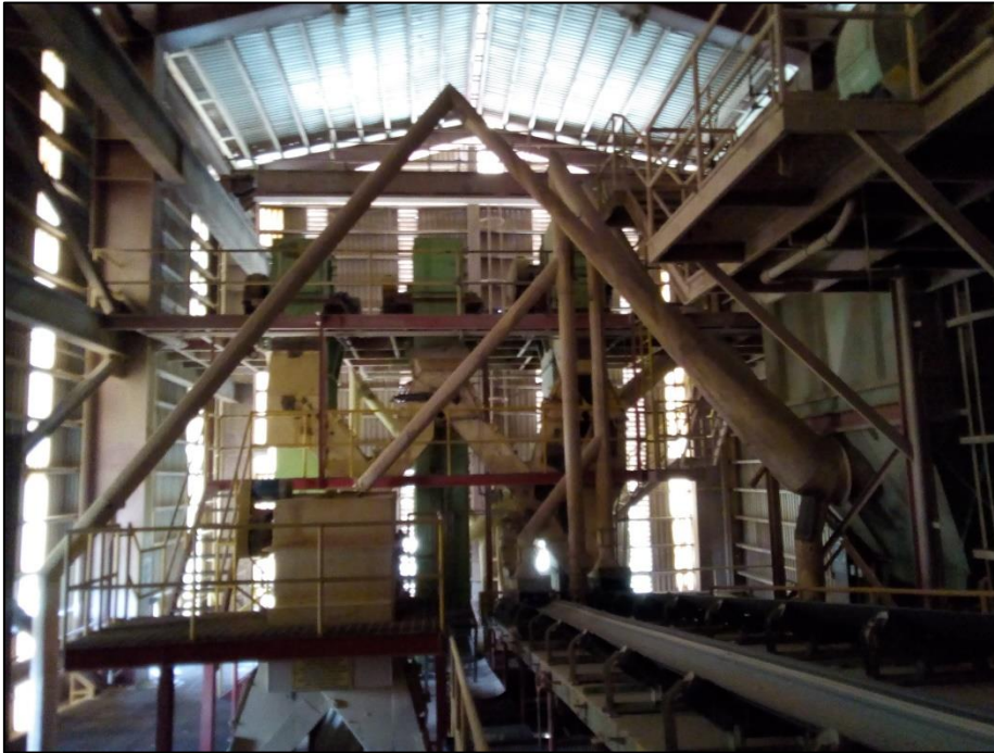
Figura 45 Pasillo de banda 12-A, existente
