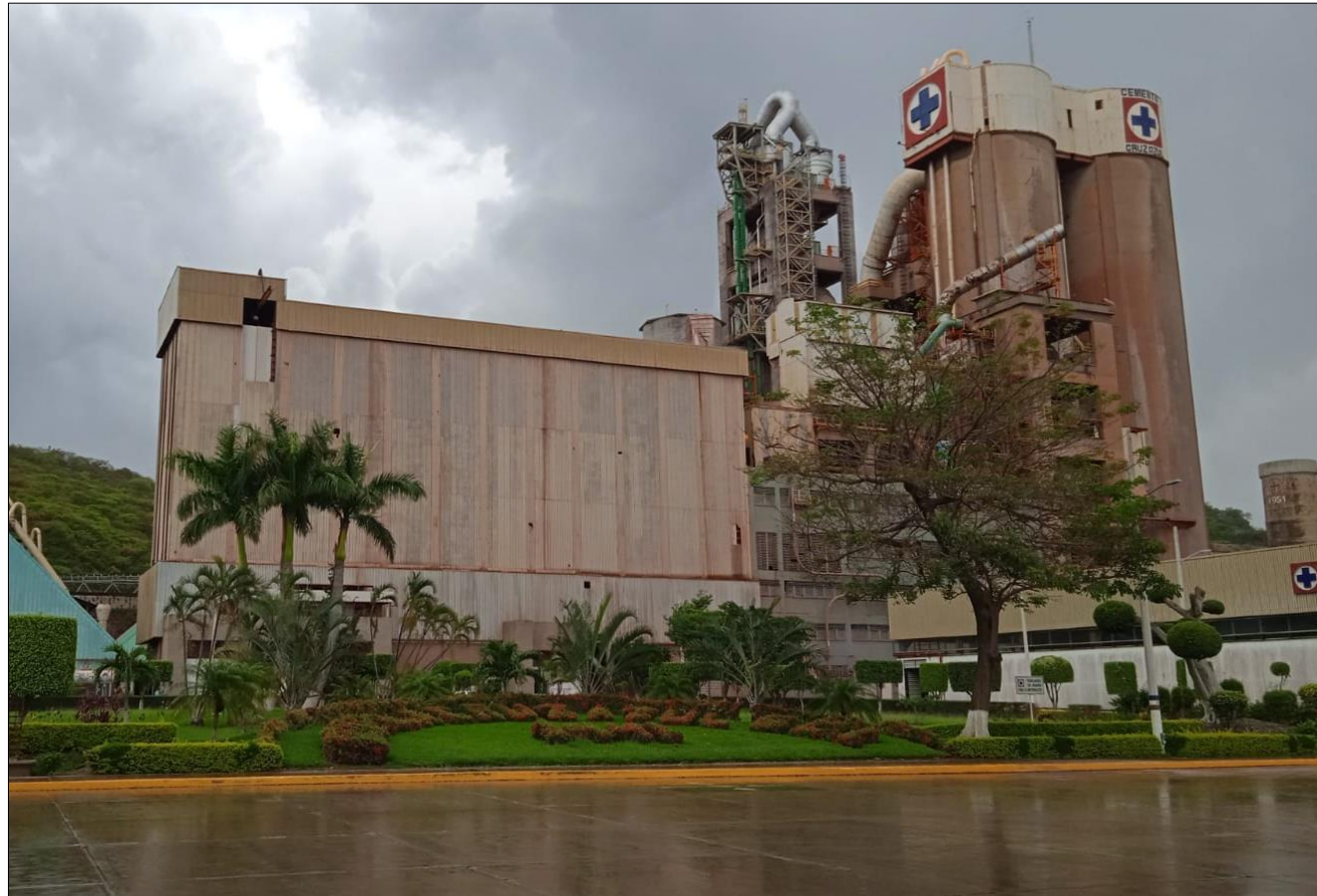
Edificio de Materias Primas
