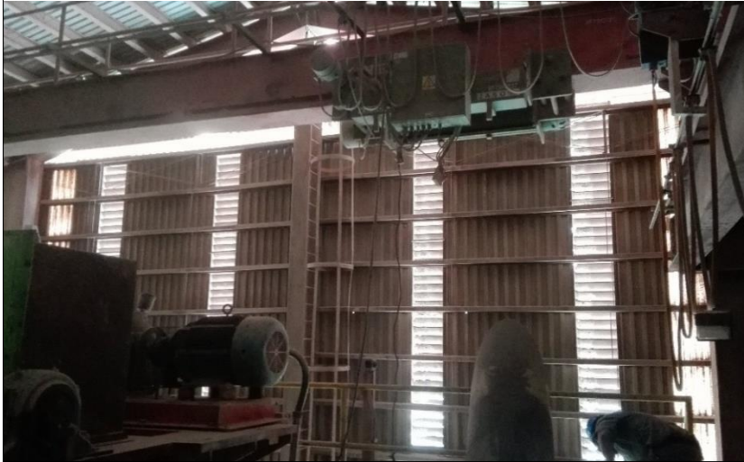
Figura 38 Transmisión del elevador no. 3, existente
