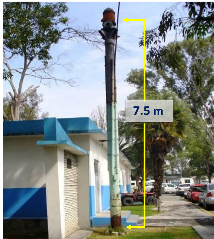
Pozo que demuestra el hundimiento en San Juan de Aragón(Ciudad de México) en el período 1936-2011
