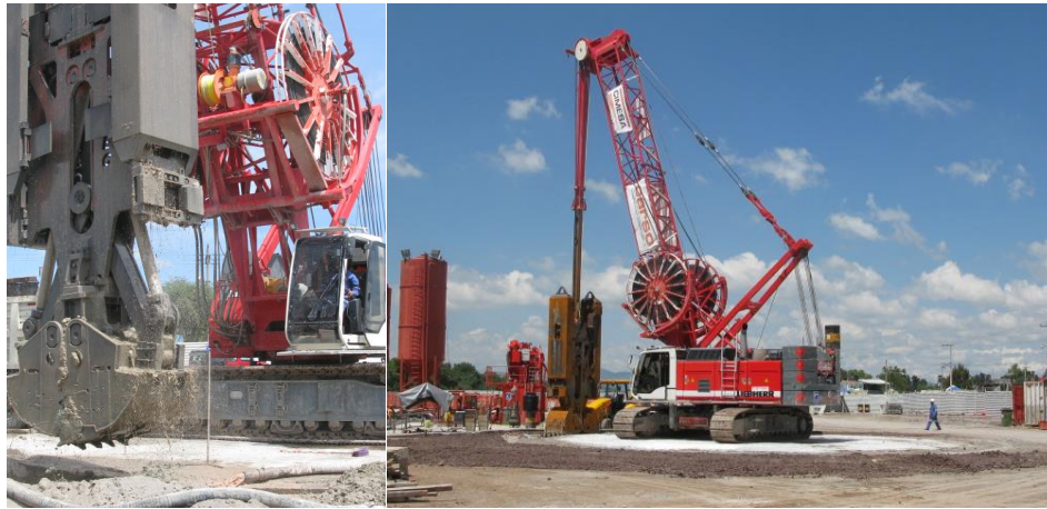
Figura 66.- Tipo de equipo y maquinaria utilizados en la construcción de muro Milán (Fuente: CONAGUA).
