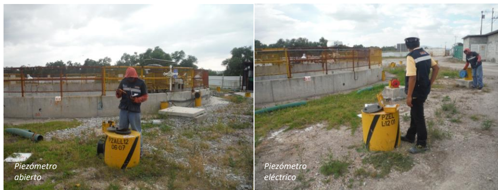
Figura 83.- Monitoreo de piezómetros instalados en el entorno de la lumbrera.
