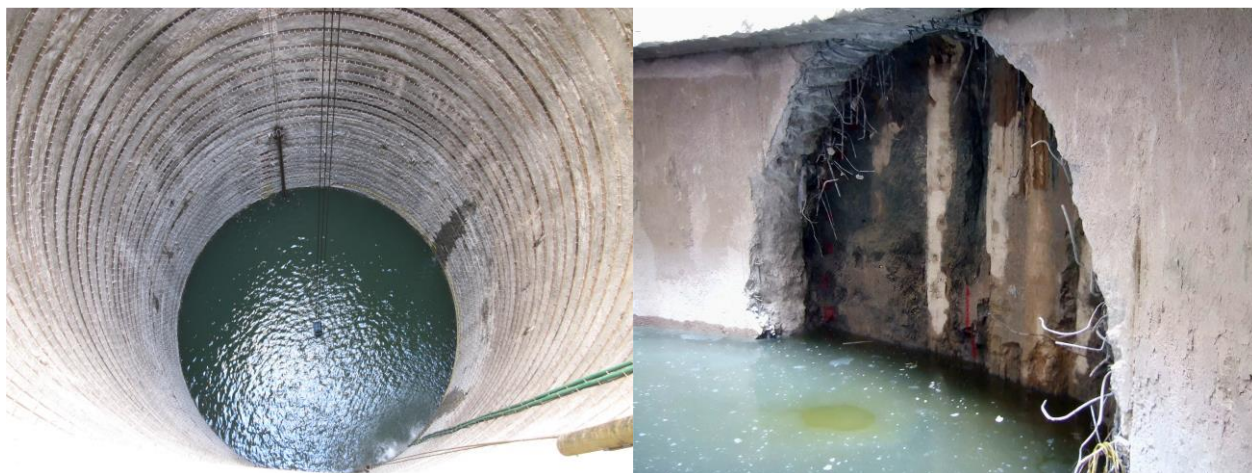
Figura 73.- Recuperación de los niveles dinámicos por falla de equipo de bombeo.
