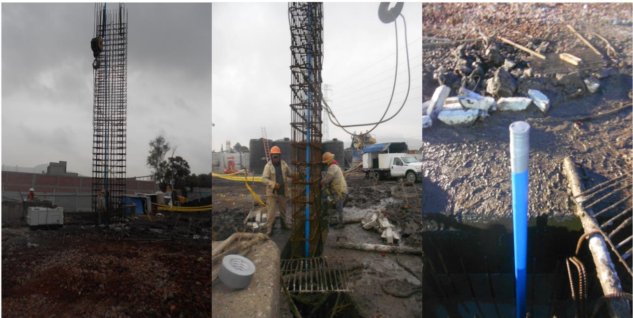
Figura 100. --Preparación de inclinómetro dentro de armado para muro Milán.
