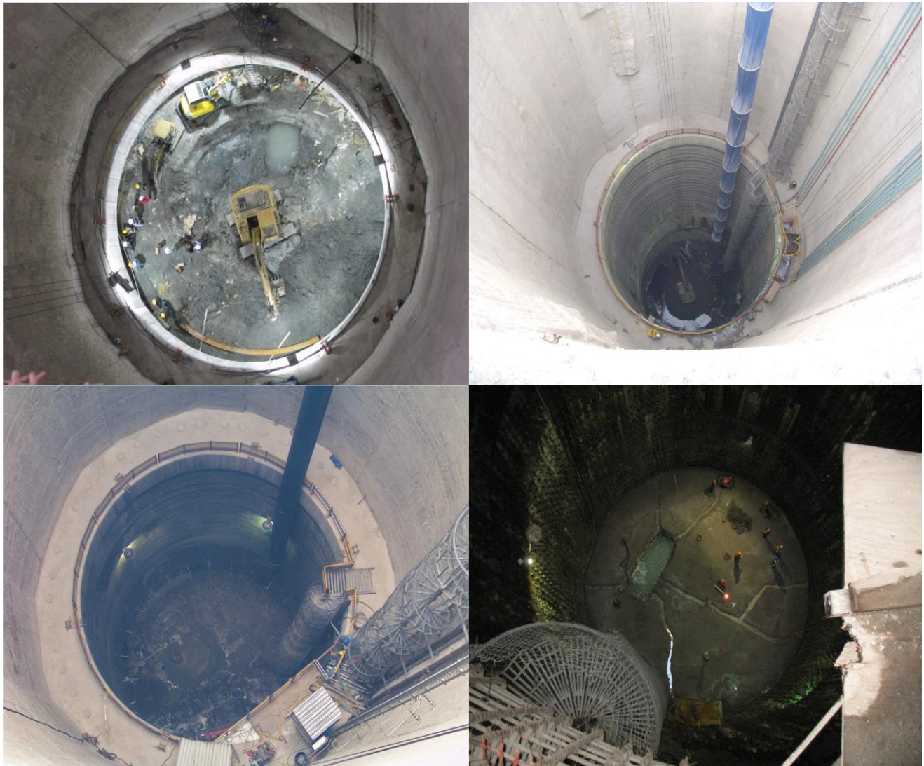
Figura 71.- Bombeo para la lumbrera L-12.
