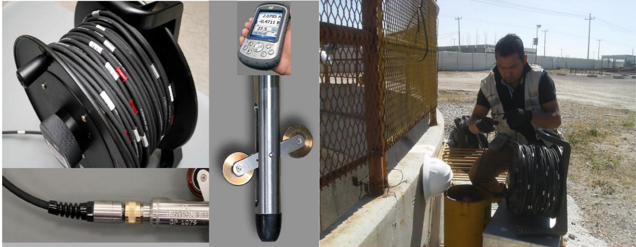
Figura 89.- Equipo de monitoreo (cortesía RST Instruments) y toma de lecturas en inclinómetro.
