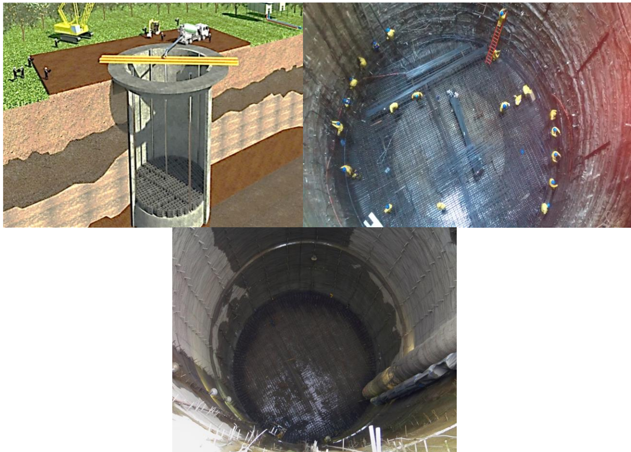
Figura 70.- Habilitado de acero para losa de fondo (Fuente: CONAGUA).
