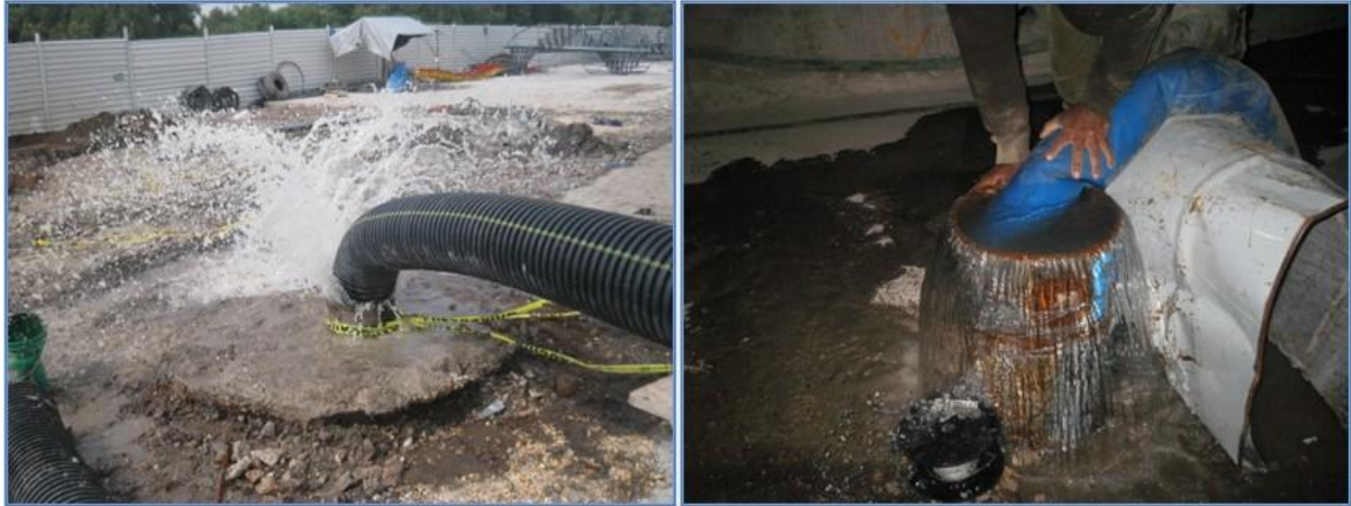
Figura 95.- Prueba de recarga en el pozo de bombeo PB-2.
