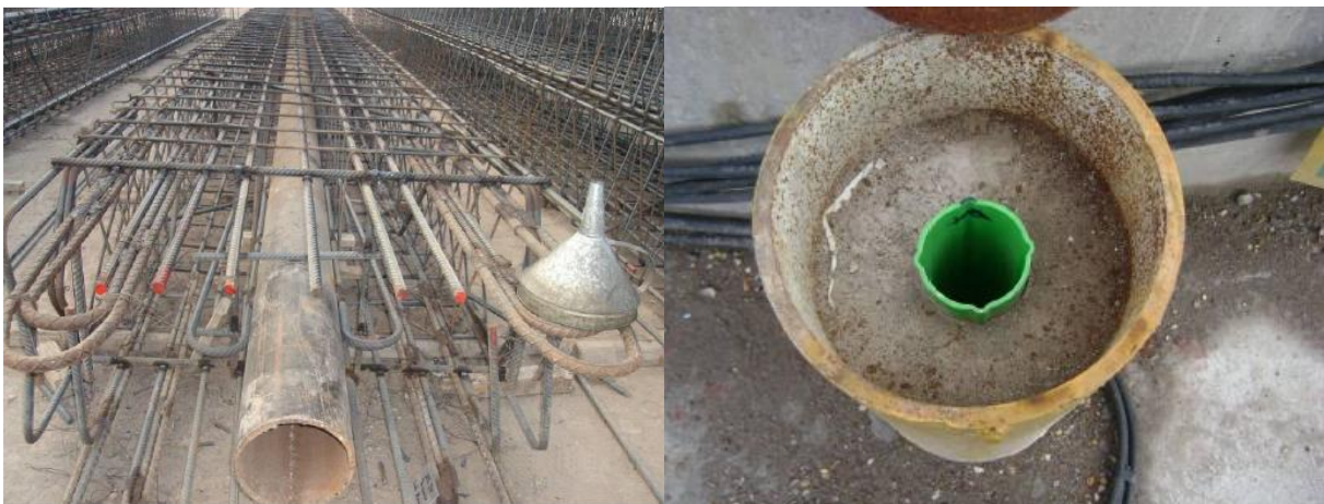
Figura 24.- Colocación de tubería para inclinómetro en muro Milán y brocal.
