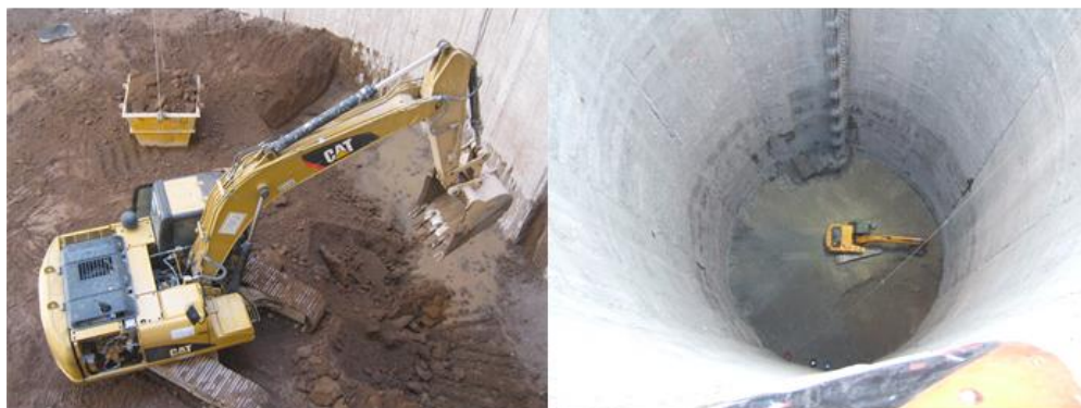
Figura 67.- Excavación del núcleo de la lumbrera (Fuente: CONAGUA).
