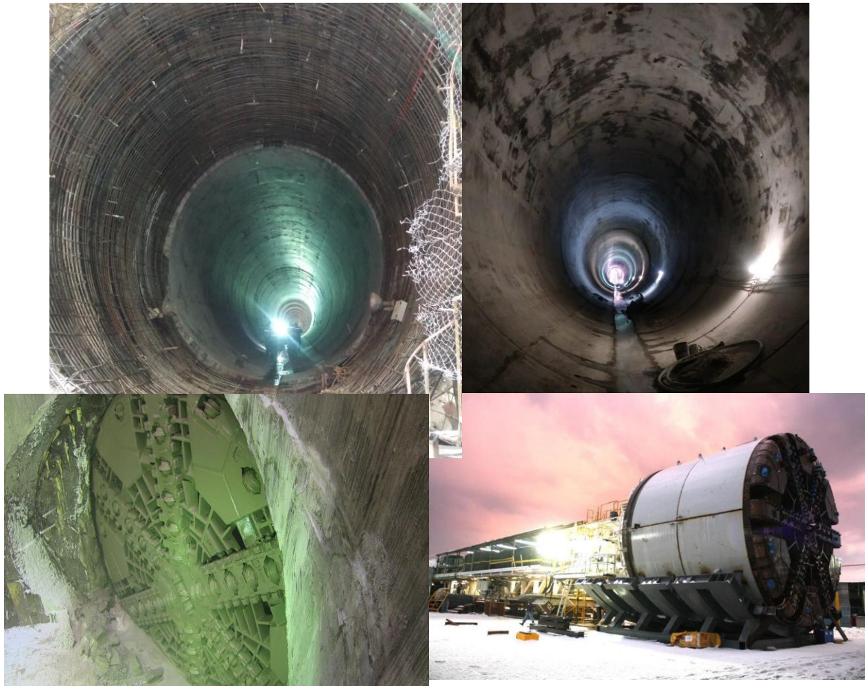
Figura 6.- Ejemplo de equipo mecanizado empleado y revestimiento para TEO.
