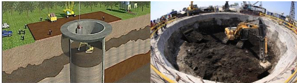
Excavación de núcleo de la lumbrera.
