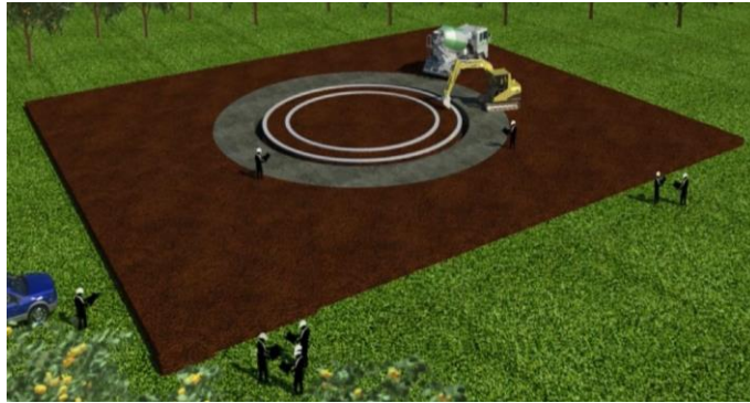
Construcción de brocales temporales para la construcción pantalla perimetral
