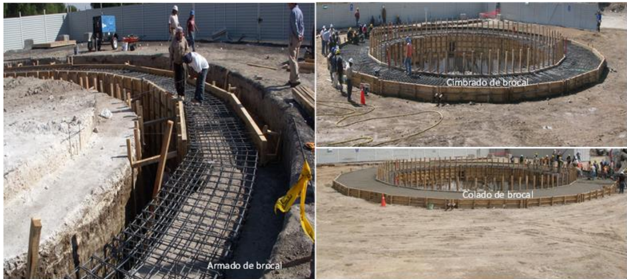
Figura 63.- Diferentes etapas de construcción de brocal para la lumbrera.
