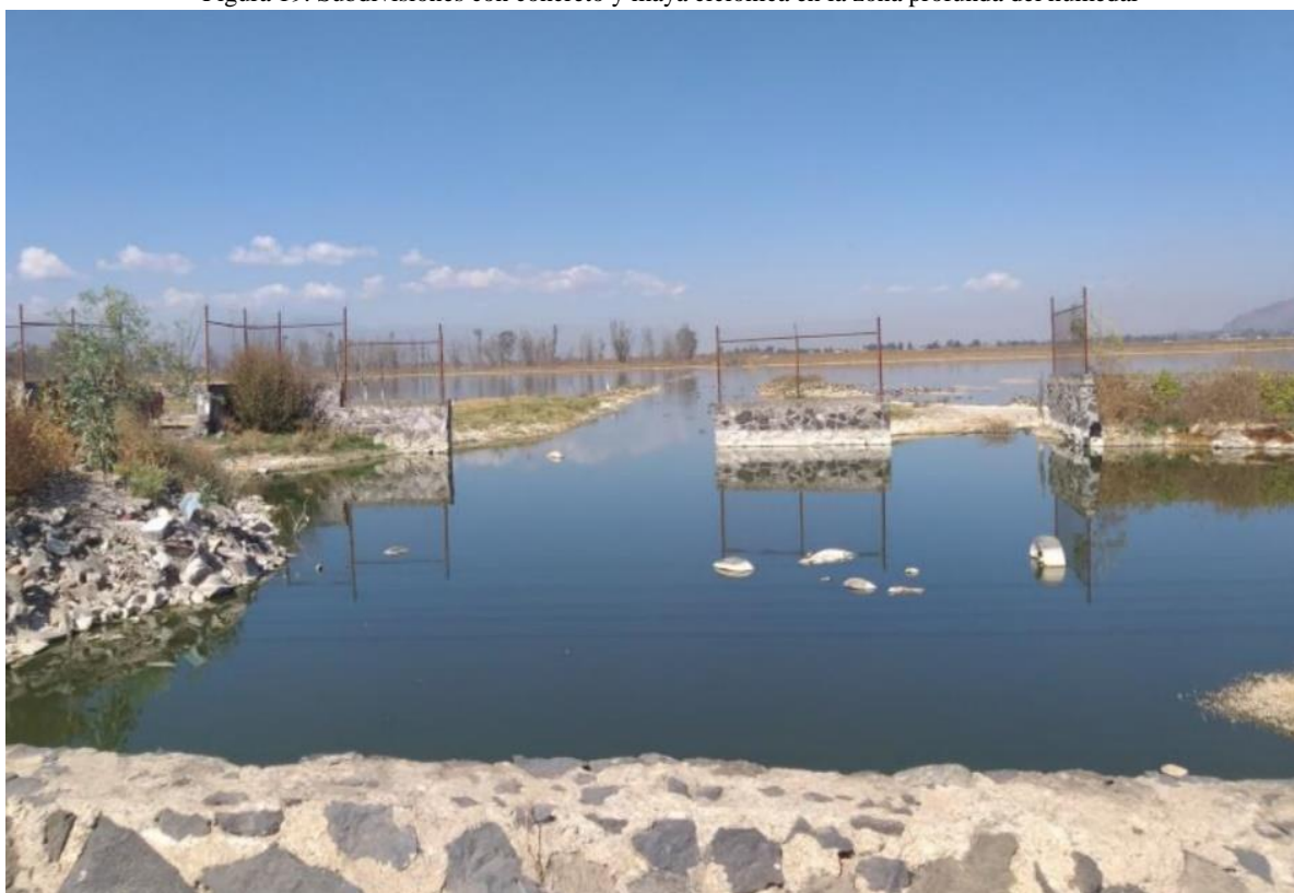
Figura 19. Subdivisiones con concreto y maya ciclónica en la zona profunda del humedal
