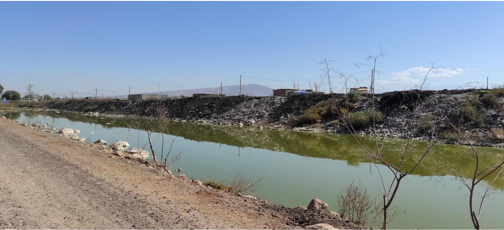
Figura 14. Canal carretero entre el asentamiento informal y la vialidad fronteriza
