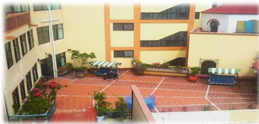
El patio que se encuentra en el primer piso
