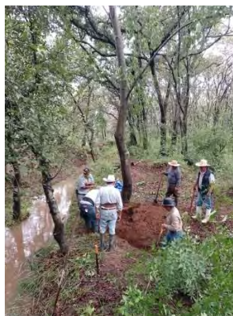
Fig. 19_ limpieza del canal
