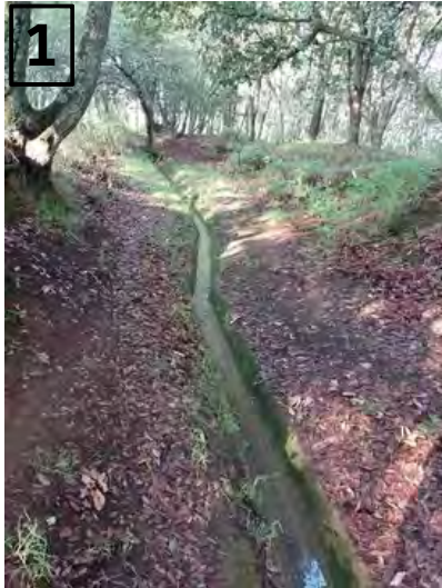
Fig.72_ Pequeñas canaletas que salen de los canales
