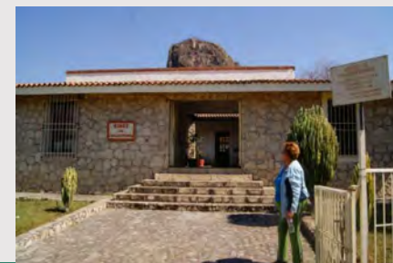
Imagen 54, Fachada del Museo de Sitio Actual. Imagen tomada en sitio.
