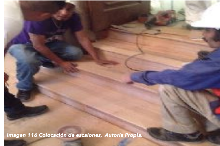
Colocación de escalones
