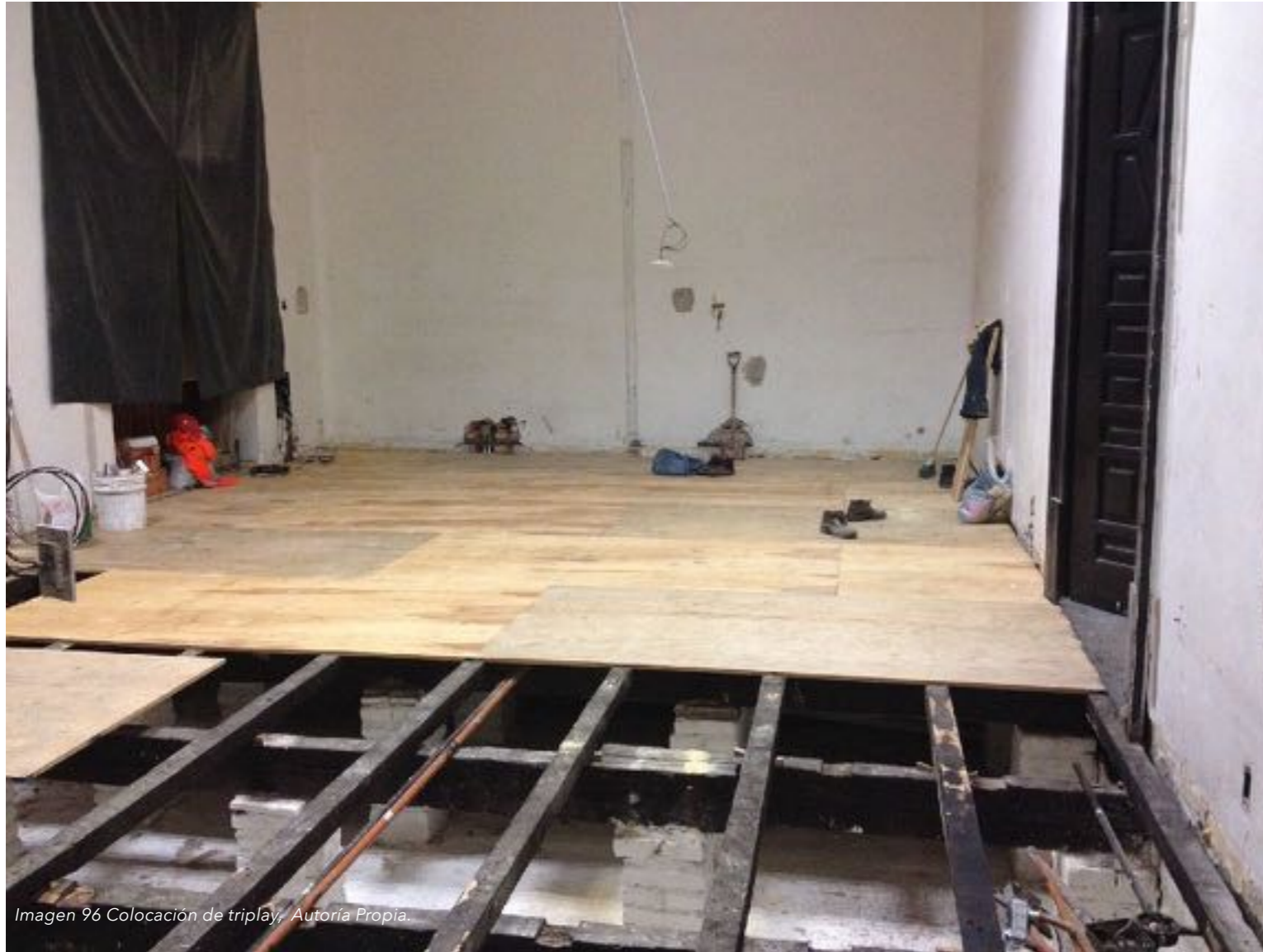
Colocación de triplay
