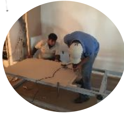
Imagen 335 Muro curvo, Autoría propia
