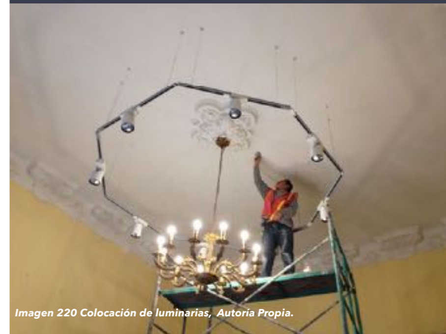
Colocación de luminarias
