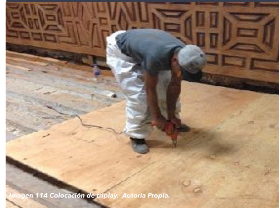
Colocación de triplay
