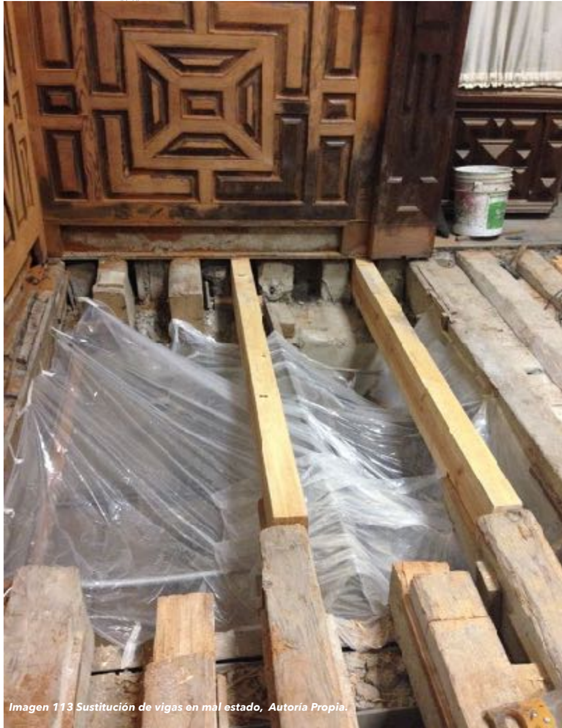
Sustitución de vigas en mal estado
