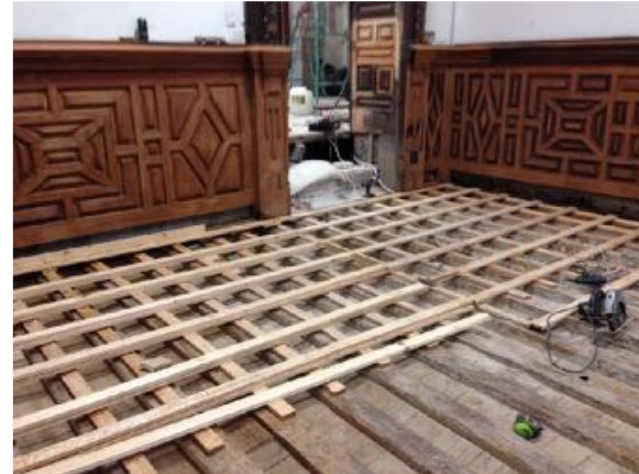
Colocación de piso de madera
