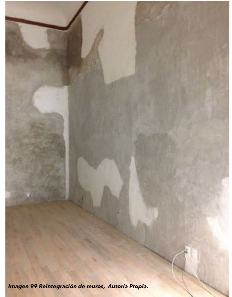
Reintegración de muros
