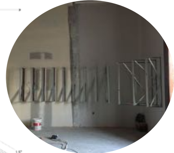
Imagen 336 Muro curvo, Autoría propia
