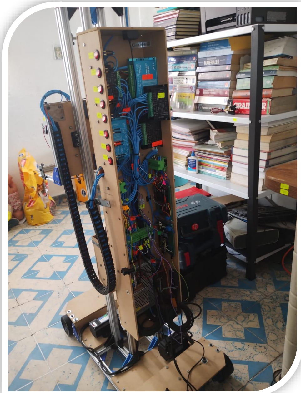
Figura 29: Vista del gabinete finalizado
