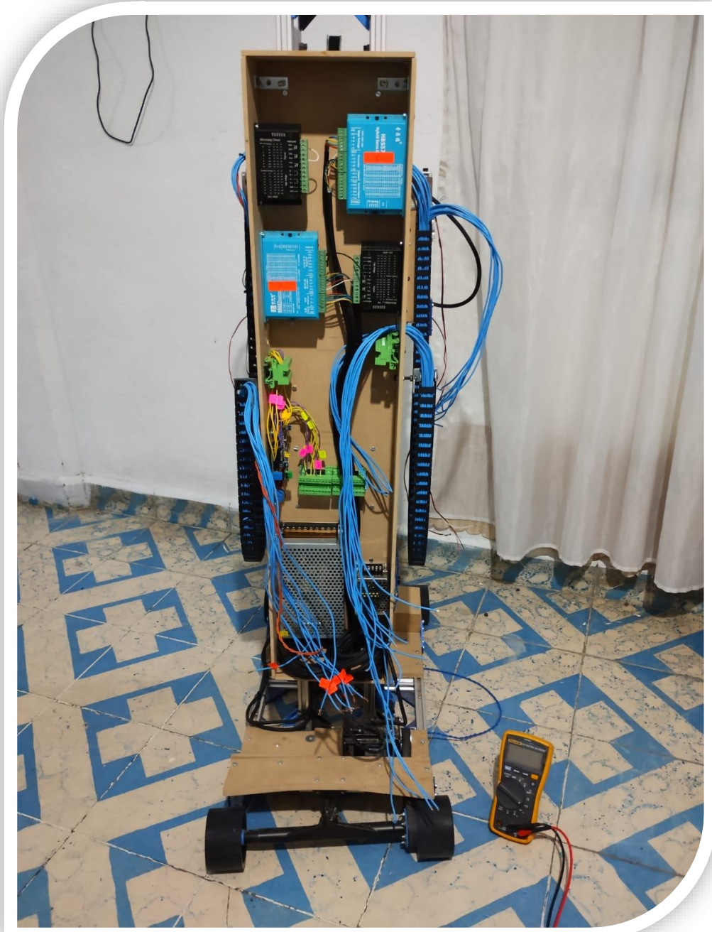
Figura 28: Vista del gabinete siendo cableado
