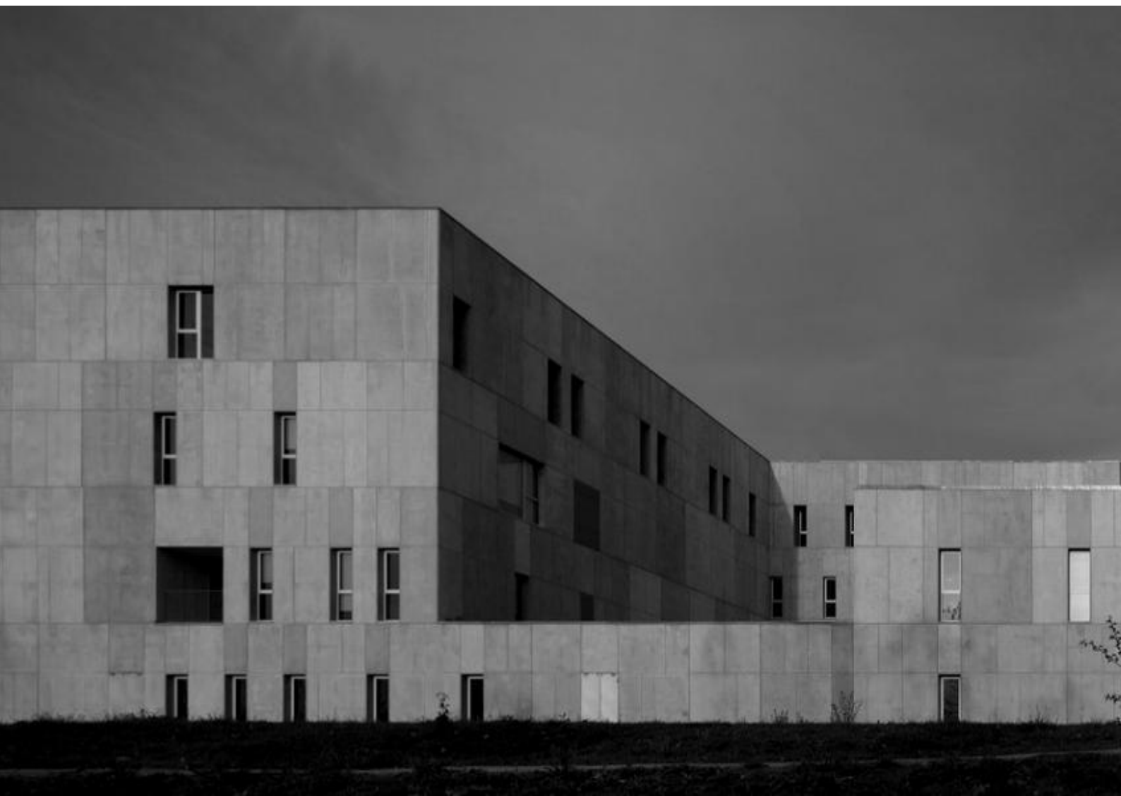
IMAGEN 2.9 FACHADA PRINCIPAL DEL HOSPITAL AMARANTE
