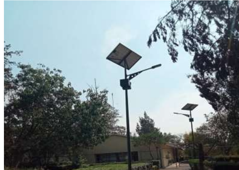
Imagen 7. Luminarias solares utilizadas en el CECA
