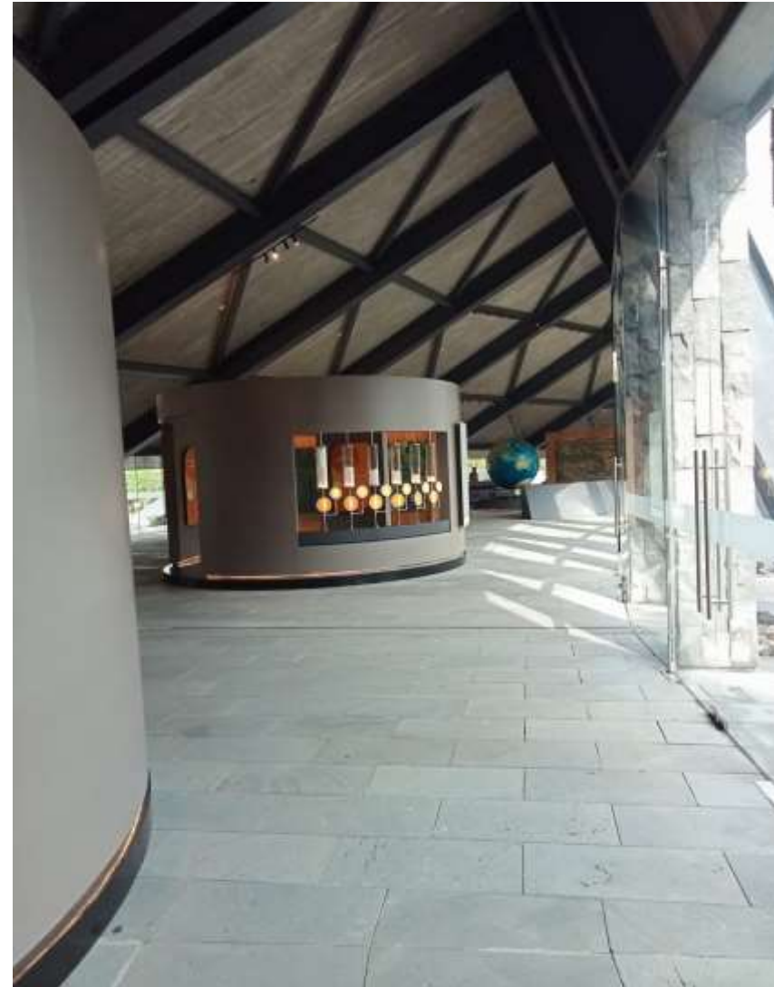
Imagen 19. Apreciación de la estructura interior del Centro de Cultura Ambiental: Chapultepec
