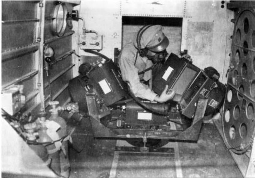
**Figura 4:** Cámara fotográfica empleada en el método Trimetrogón. Dirección General de Cartografía.
