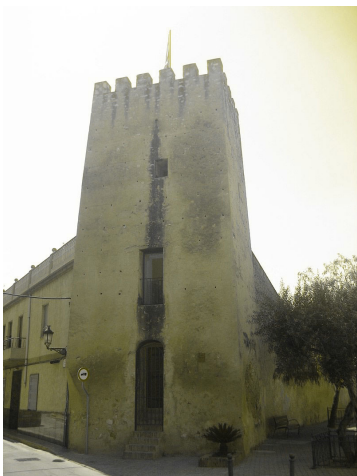
FIG. 48. La Torre árabe de Albal, es el edificio más antiguo de Albal y único vestigio de la fortificación defensiva de la primitiva alquería islámica. Valencia, España.
