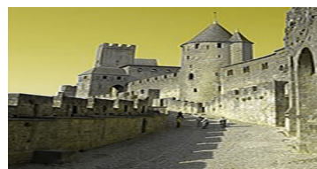
FIG. 16. Paredes del fuerte de la Ciudad Histórica Fortificada de Carcasona en Carcassonne, Francia (2006). Rampas para un movimiento rápido de las tropas.
