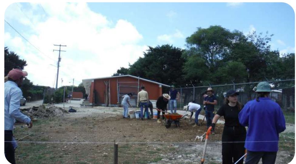
IMAGEN 169: Se aprecia línea de cal de desplante constructivo para el emplazamiento del aula.
