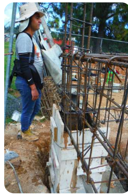
IMAGEN 196: Cimbrado de dado de colindancia. Se aprecia abajo zapata ya colada
