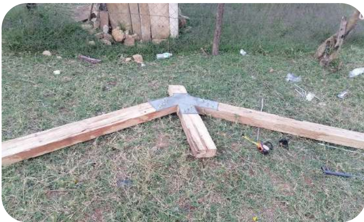
IMAGEN 231: Sección de una armadura completa, se encuentra en el suelo colocada hacia arriba, las triangulaciones son las que reposan sobre las columnas. La pendiente va hacia el jardín desde donde fue tomada la foto.
