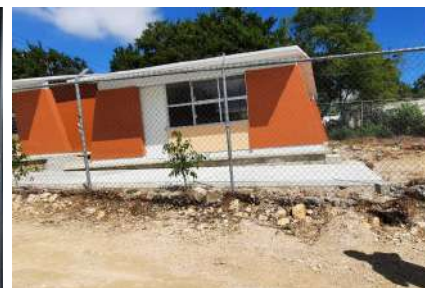
IMAGEN 77: Aspecto de calle de la escuela sin tratamiento de pisos ni banquetas.
