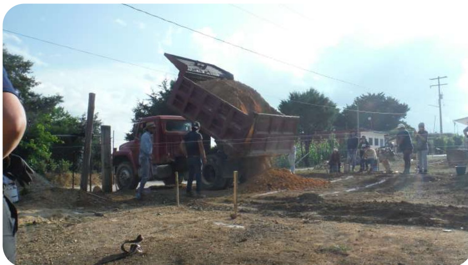
IMAGEN 168: Llegada de material para compactación y nivelación de terreno.
