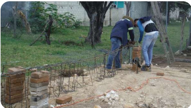
IMAGEN 180: Compañeros realizando amarres, para estructura
