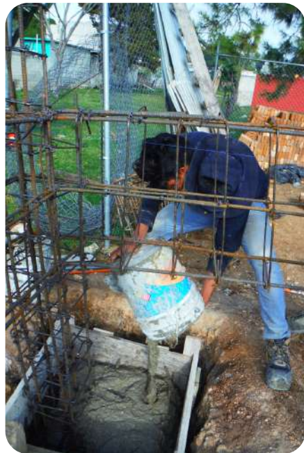
IMAGEN 193: Cimbrado de zapata de colindancia con primer bote de mezcla.
