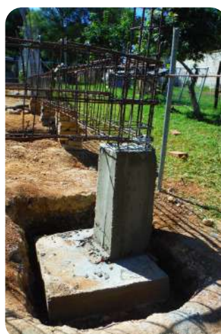
IMAGEN 207: Zapata y dado de cimentación descimbrados.
