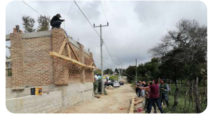
IMAGEN 235: Equipo jalando lazos para levantar armadura, el montaje se interrumpió por la delicadeza de la fachada que podría dañarse.
