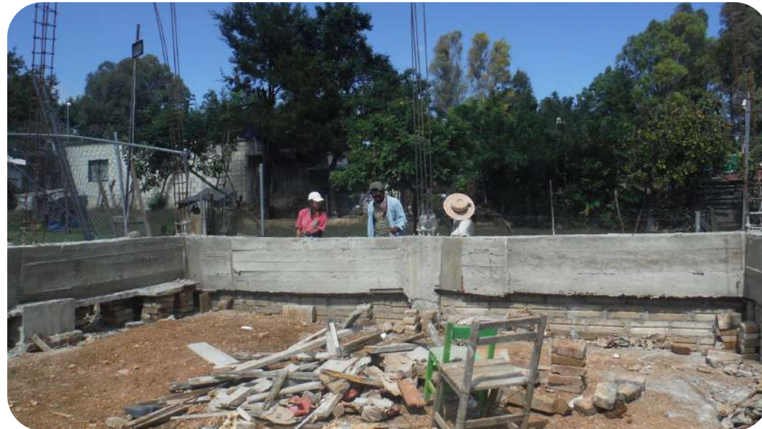
IMAGEN 204: Compañeros boteando concreto, compañeras vibrando concreto, se aprecia cimbra y armadura de columnas.
