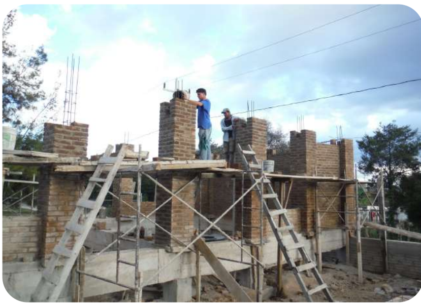
IMAGEN 222: Compañero Henry de intercambio sobre andamios boteando mezcla para las columnas.
