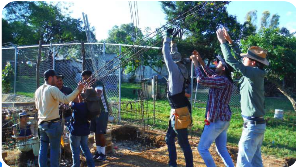
IMAGEN 190: Equipo levantando columna sobre contratrabe.
