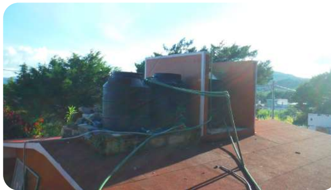
IMAGEN 155 Tinacos sobre losa de sanitarios. Noviembre 2022
