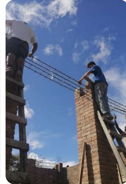
IMAGEN 227: Compañeros trabajando en conjunto para colocar sobre las columnas la dala de cerramiento de 15 ml.
