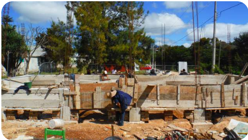
IMAGEN 200: Equipo de trabajo colocando cimbra de contratrabe.
