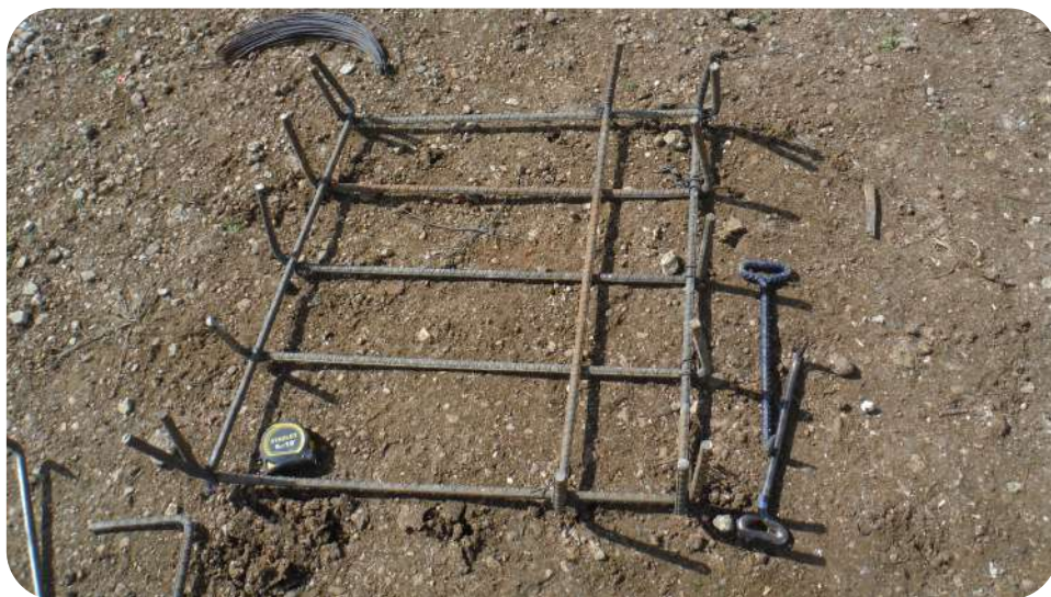
IMAGEN 185: Proceso Constructivo de parrilla
