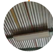
Cubierta de Lamina/ concreto
