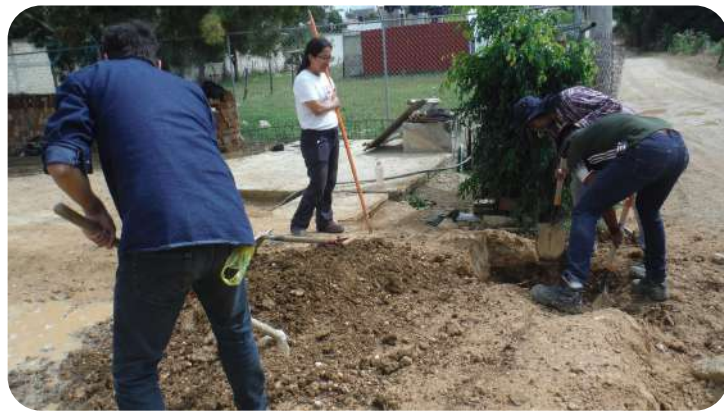
IMAGEN 173: Excavación manual -50 cm de profundidad aprox.
