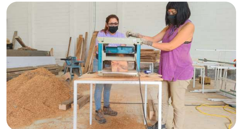
IMAGEN 216: Usando herramienta menor, cepillando manualmente una pieza de traslape de la armadura para cubierta.
