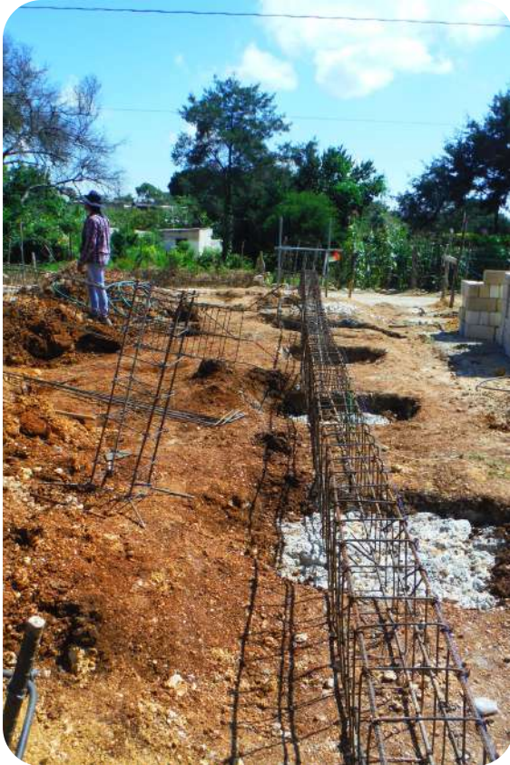
IMAGEN 188: Perspectiva, ilustra excavaciones con plantilla de concreto pobre para recibir acero de estructura de cimentación.
