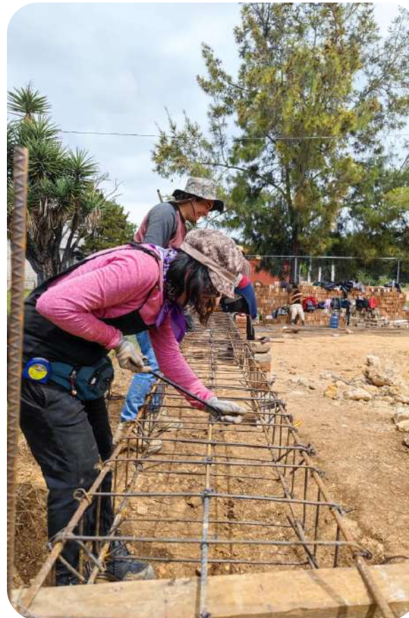
IMAGEN 181: Realizando amarrado de contratrabes.-.
