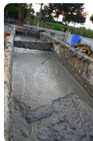
IMAGEN 208: Proceso de colado de contratabe con aplanado en nivel
