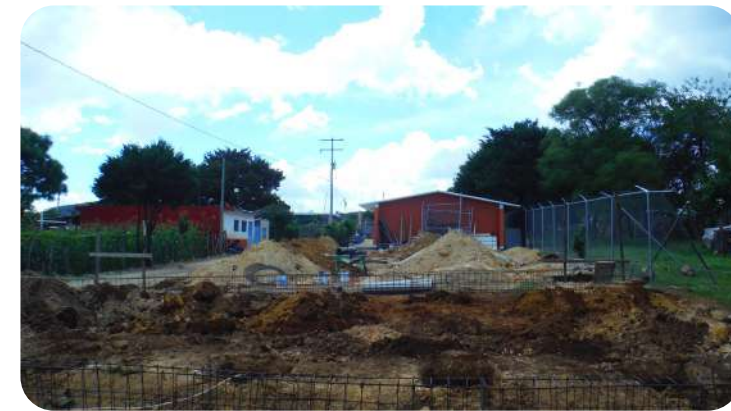
IMAGEN 175: 14 hoyos de cimentación realizados por la máquina.
