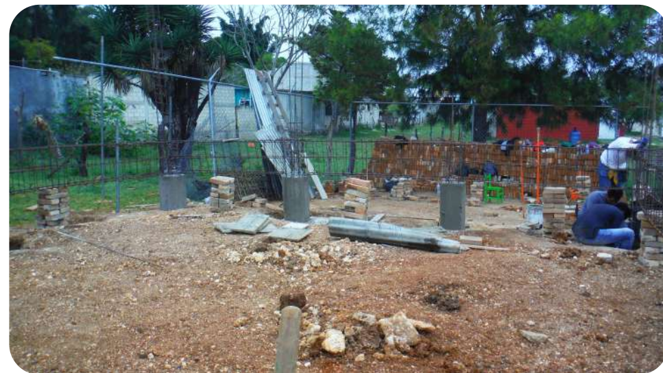
IMAGEN 198: Se aprecia contratrabe reposando sobre dados y encofrado de dados.
