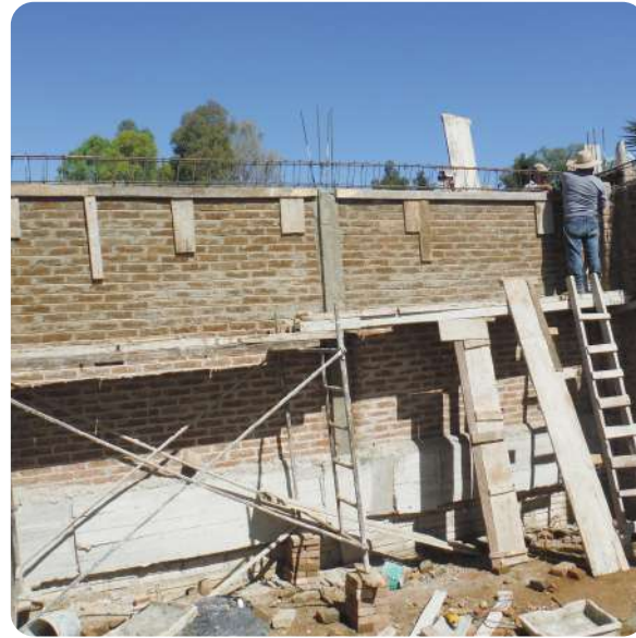
IMAGEN 225: Dala colocada con regleta como cimbra para colado.
