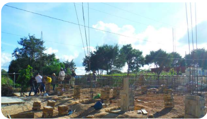
IMAGEN 199: Contratrabe reposando sobre dados descimbrados.
