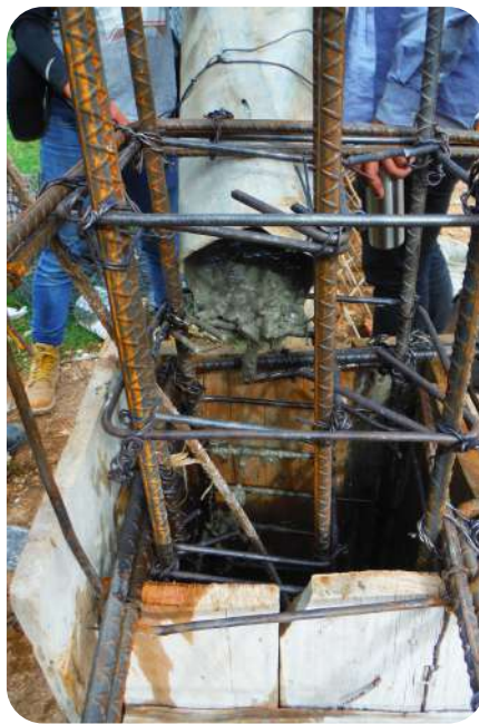
IMAGEN 194: Mezcla cayendo dentro de la cimbra de dado de cimentación.
