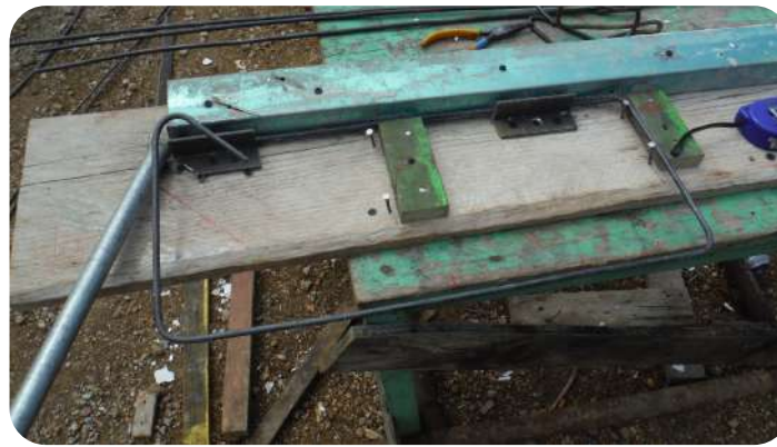
IMAGEN 177: Mesa con regleta fabricada por los compañeros de Colectivo Barrial que permite el doblado del alambro para los estribos
