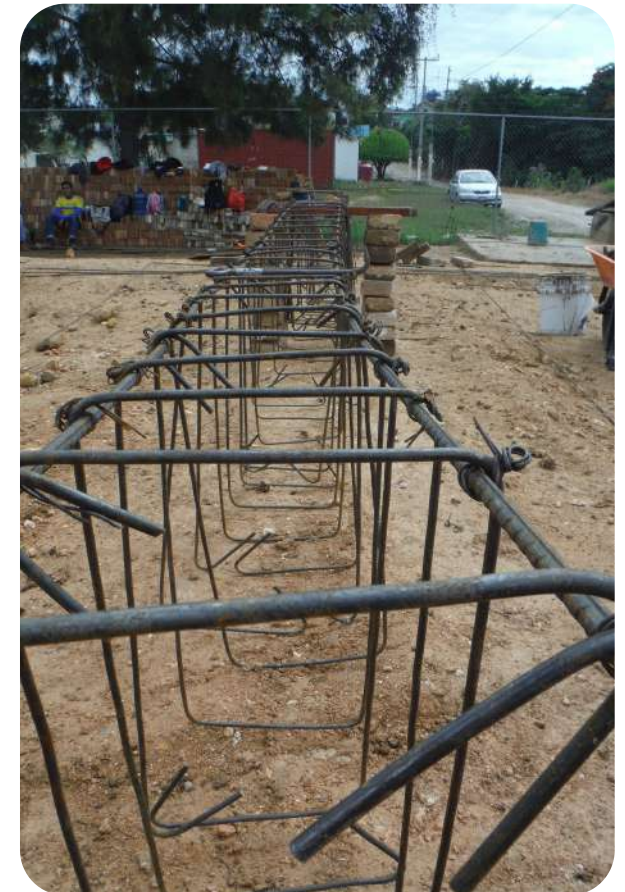
IMAGEN 182: Perspectiva de contratraba amarrada por una cara del prisma.
