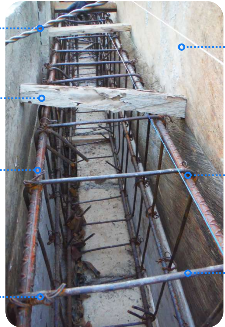
IMAGEN 202: Interior de la contratrabe lista para recibir mezcla de colado, se aprecian estacas de separación, torzones de alambre que sirven de tensores para mantener la cimbra inmóvil.
