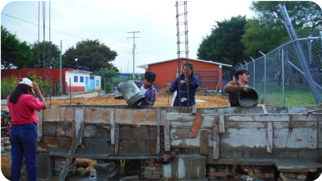
IMAGEN 203: Compañeros boteando concreto, compañeras vibrando concreto, se aprecia cimbra y armadura de columnas.
