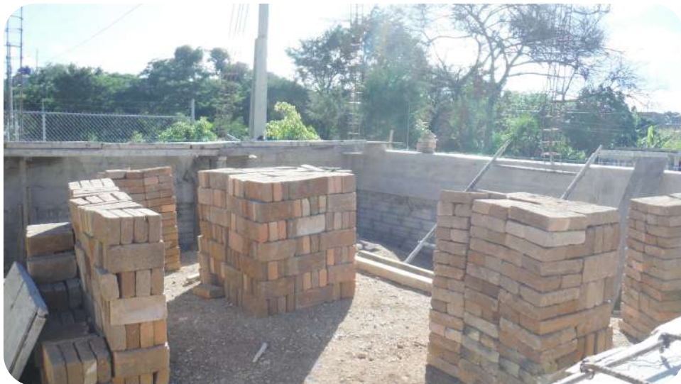
IMAGEN 220: Ladrillos listos para su colocación.
