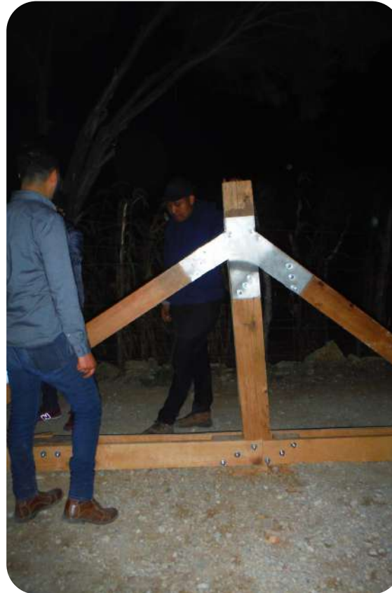
IMAGEN 237: Ensamblaje de Armadura
