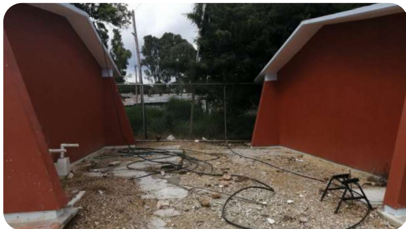
IMAGEN 246: Espacio entre Aulas. Octubre 2020
