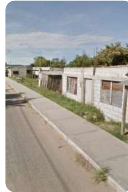
IMAGEN 84: Paisaje Arquitectónico Urbano, vialidades en malas condiciones de pavimentación, viviendas sin acabados o en obra negra, cuentan con servicios básicos.
