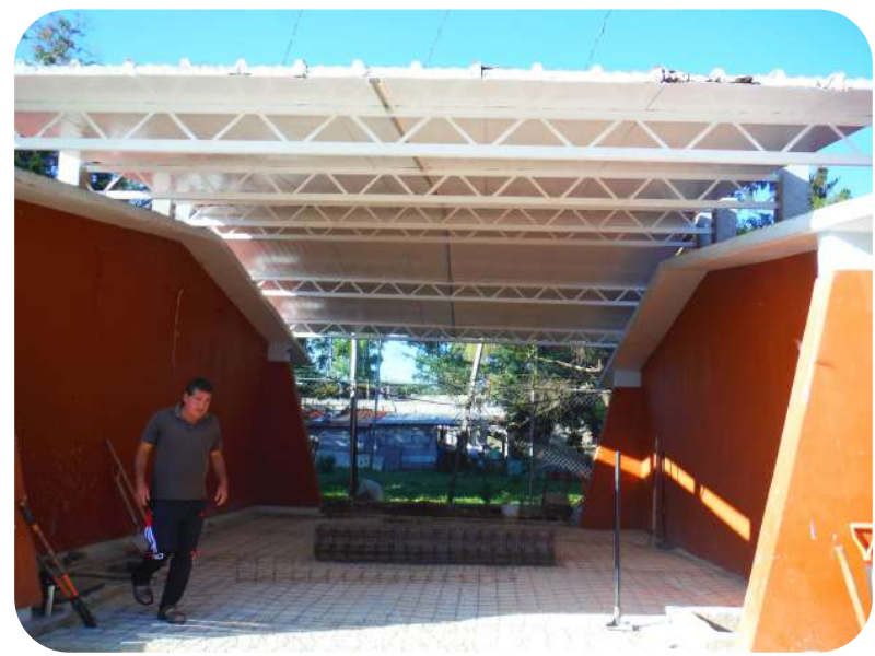
IMAGEN 223: Dir. Uber caminando sobre losa por colar bajo cubierta del nuevo comedor
