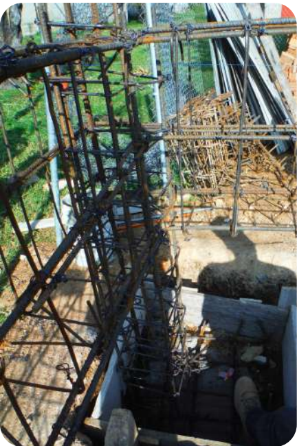
IMAGEN 192: Cimbrado de zapata de colindancia se aprecia armado de zapata, dado, columna y contratrabe que queda volando pues falta relleno para nivelar piso terminado.
