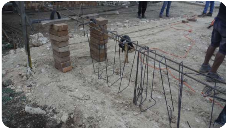
IMAGEN 179: Soportes para facilitar el armado de contratrabe. Dos varillas y estribos.
