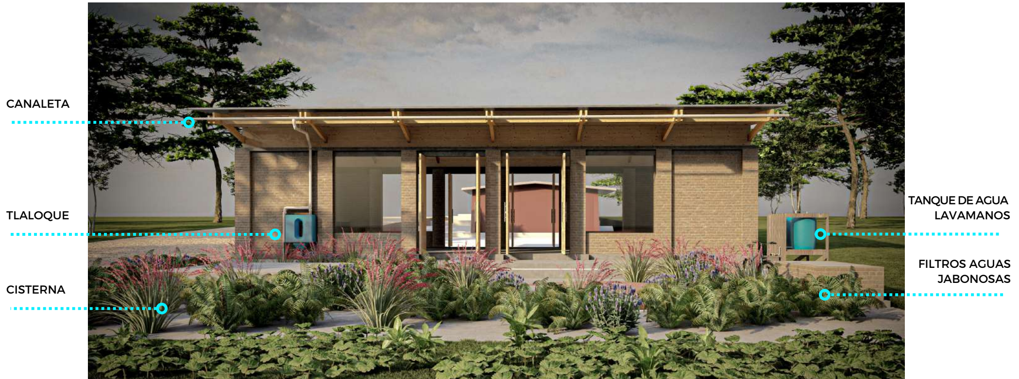
IMAGEN 157: Fachada este, se aprecia Tlaloque y Modulo de Lavamanos.
