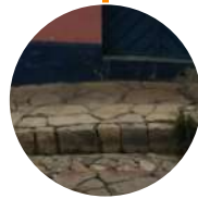
Piso de Piedra
