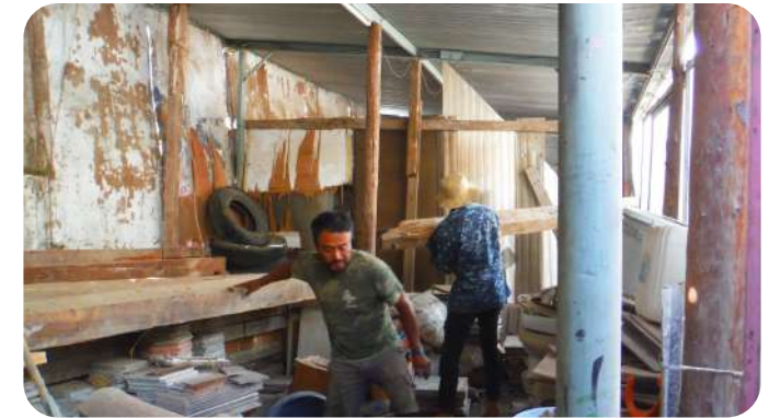
IMAGEN 212: Arq. Lara saltando de la plataforma donde se guardaban las vigas.
