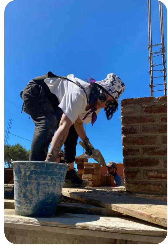
IMAGEN 219: Cillando junta para dar acabado aparente a los muros y columnas de ladrillos.
