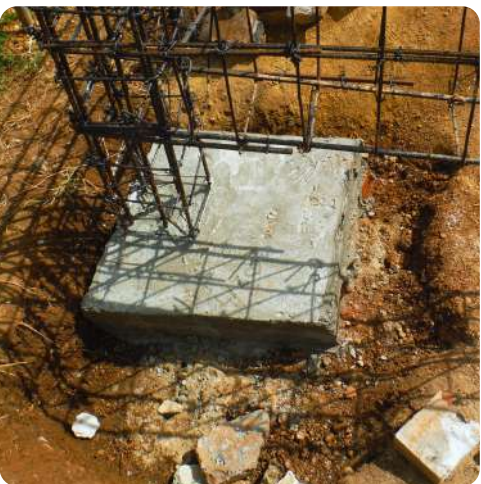
IMAGEN 205: Zapata descimbrada.
