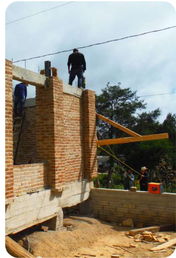
IMAGEN 238: Prueba de Colocación de Armadura
