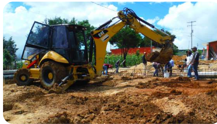
IMAGEN 174: Retroexcavadora haciendo hoyos para cimentación de zapatas,
