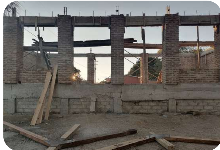
IMAGEN 232: Perspectiva, Puesta de sol. Se aprecian armaduras, columnas placas de acero y dala de cerramiento.
