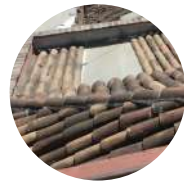
Cubierta de Teja de Barro
