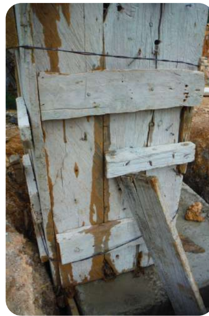
IMAGEN 195: Perspectiva de encofrado de dado de cimentación mientras recibe mezcla a través de un cono improvisado hecho con lámina de aluminio.
