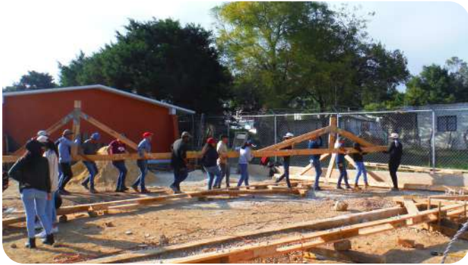
IMAGEN 233: Equipo moviendo armadura. Se aprecia largo
