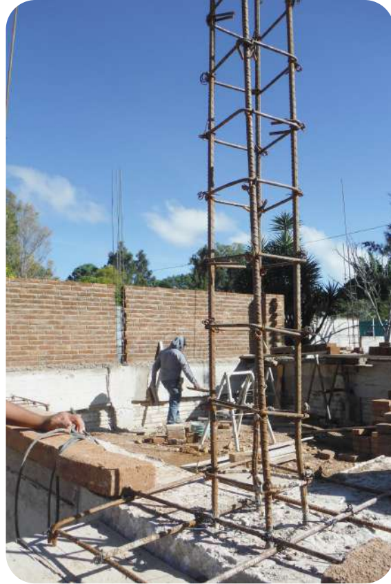
IMAGEN 218: Maestros trabajando en pegado de ladrillo.
