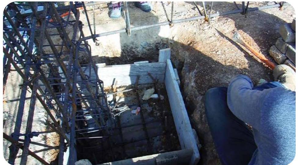
IMAGEN 191: Cimbrado de zapata de colindancia.
