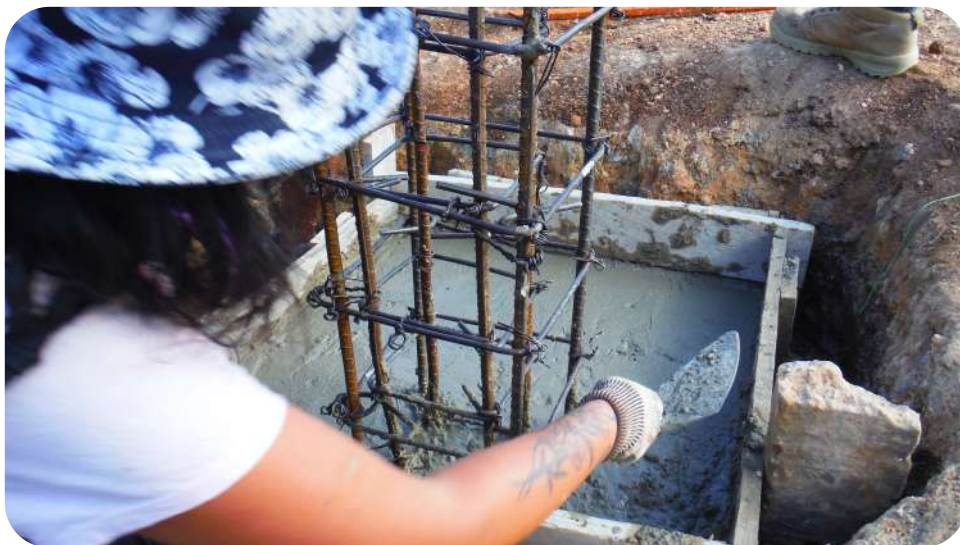
IMAGEN 197: Retrato elaborando el aplanado de la zapata con la cuchara.
