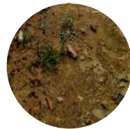
Piso de Tierra
