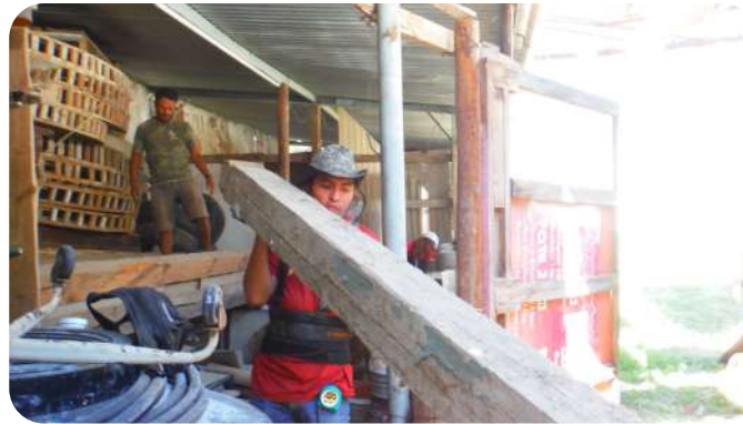
IMAGEN 211: Arq. Lara y compañero Braulio sacando vigas de bodega.
