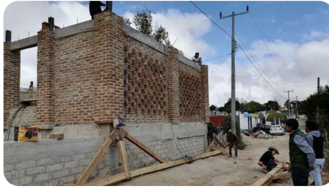
IMAGEN 234: Preparación del equipo para subir armaduras con lazos
