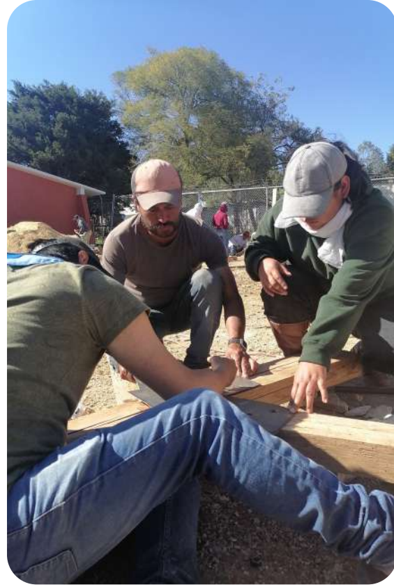
IMAGEN 230: Arq. Lara explicando y ayudando al equipo a construir armadura.
