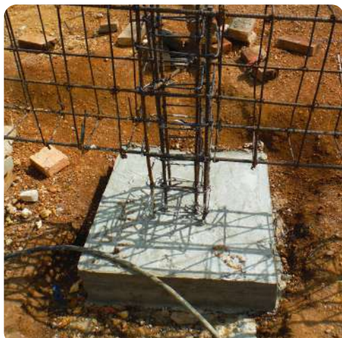
IMAGEN 206: Zapata de colindancia descimbrada.
