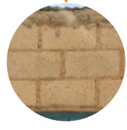
Muros de Bloque/ tabique
