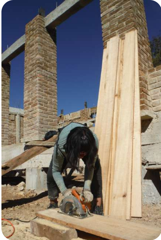
IMAGEN 228: Cortando tiras de madera para fabricación de armaduras para cubierta
