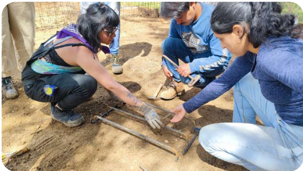
IMAGEN 183: Midiendo varillas y cuadrando parrilla con equipo de trabajo, Carlita y Carlos
