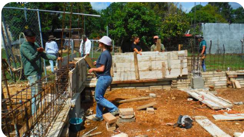
IMAGEN 201: Equipo de trabajo colocando cimbra, se aprecian algunas partes de la trabe ya fraguadas y sin cimbra.
