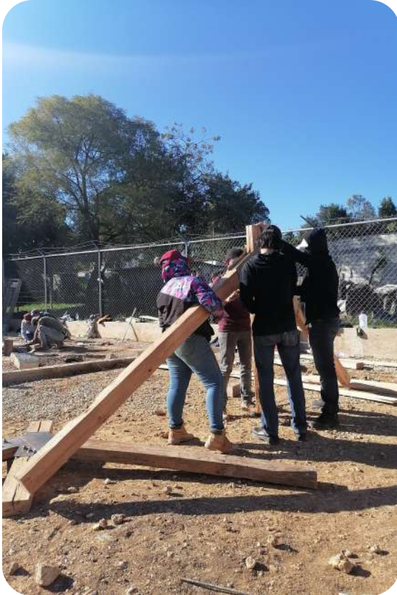
IMAGEN 229: Equipo construyendo armadura
