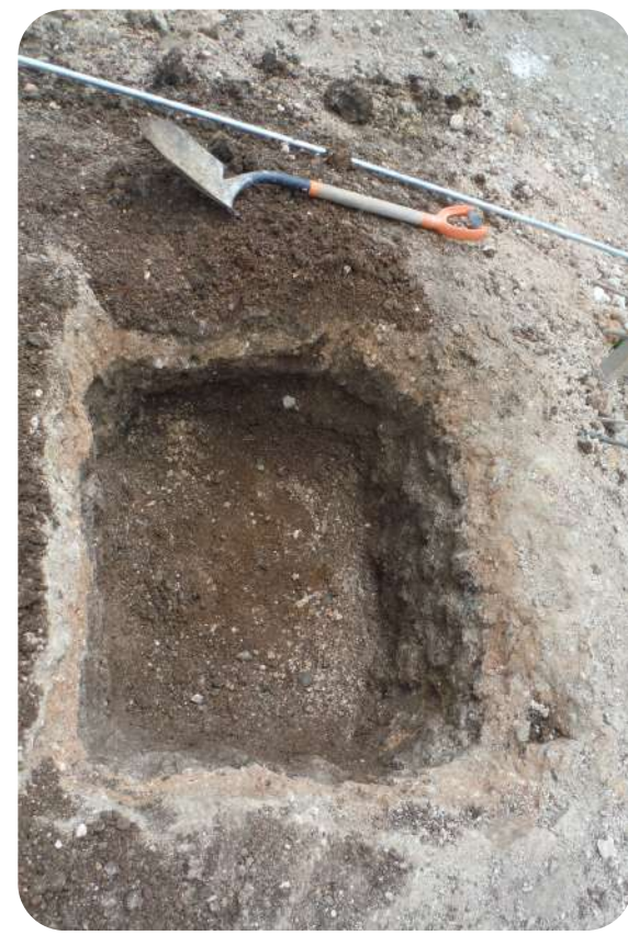
IMAGEN 172: Primeras excavaciones, para cimientos
