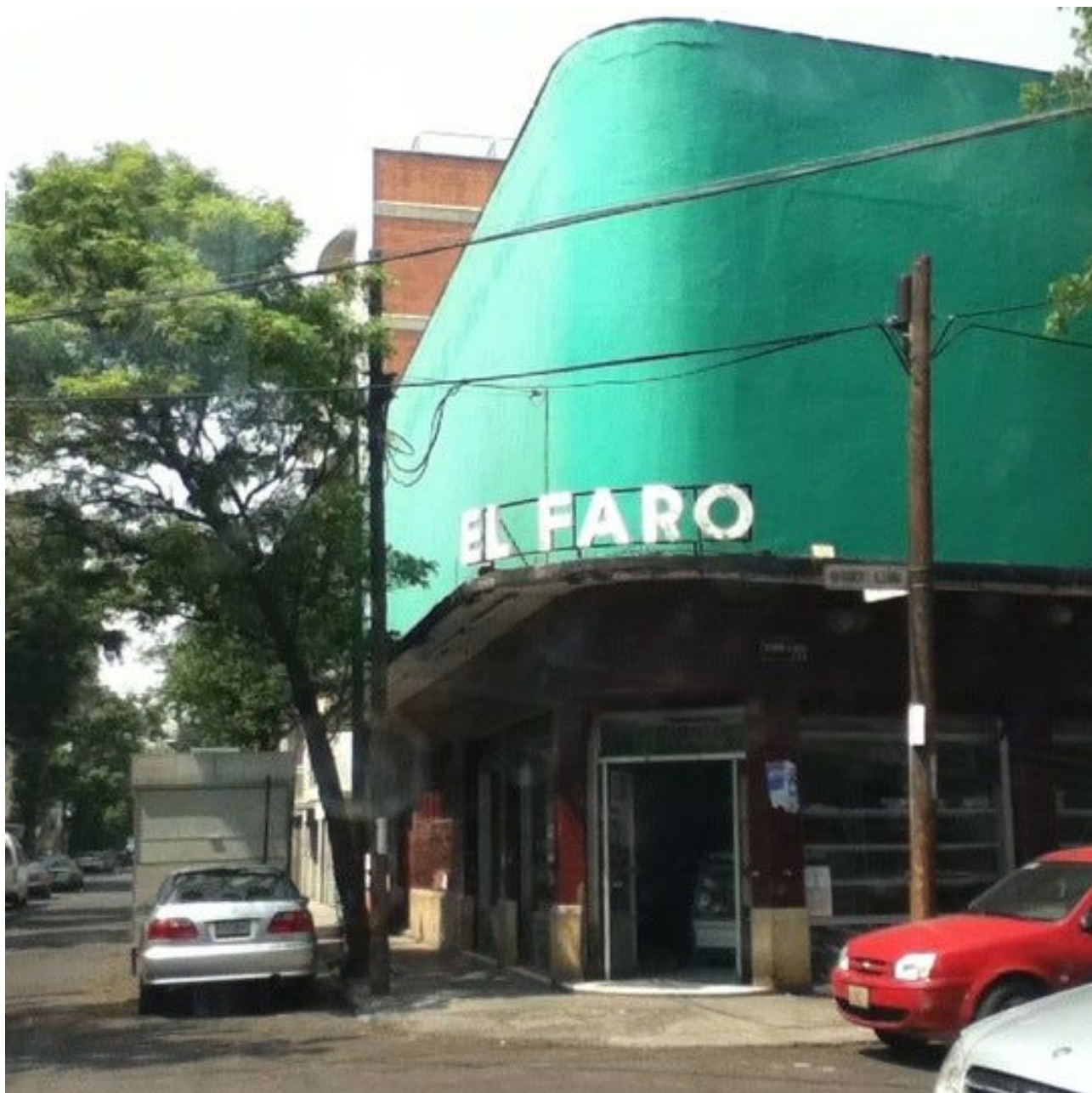
Fachada Panificadora "EL FARO" Fuente: foursquare
