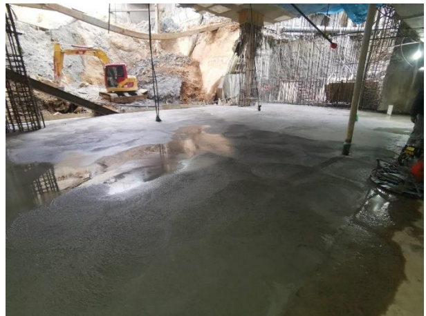
Figura 36. Construcción de la losa de fondo
