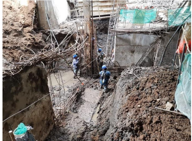
Figura 35. Construcción de la trabe de liga
