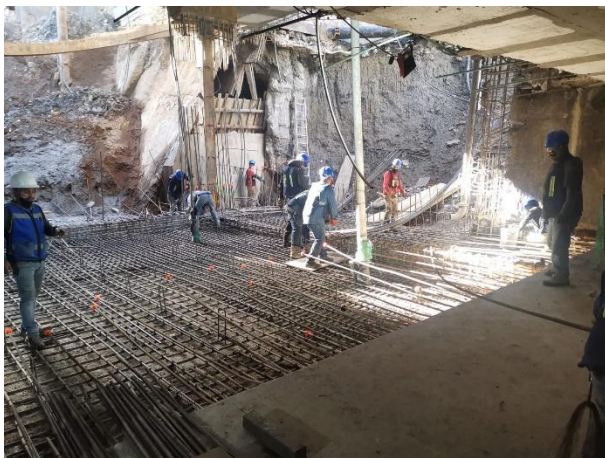
Figura 36. Construcción de la losa de fondo
