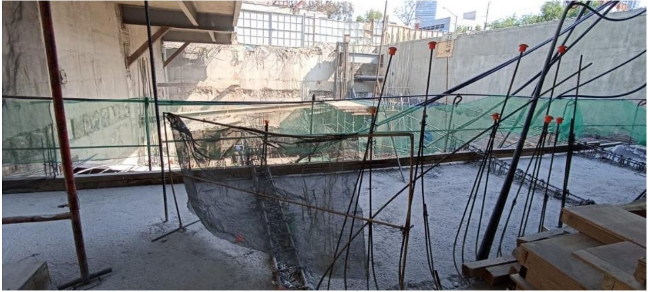
Figura 15. Apuntalamiento con losa de entrepiso
