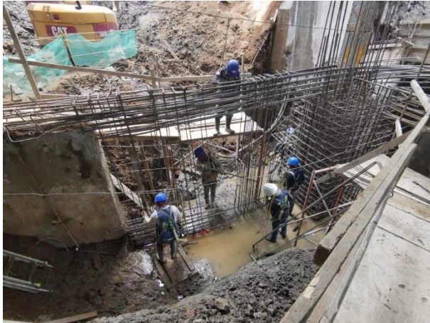
Figura 35. Construcción de la trabe de liga
