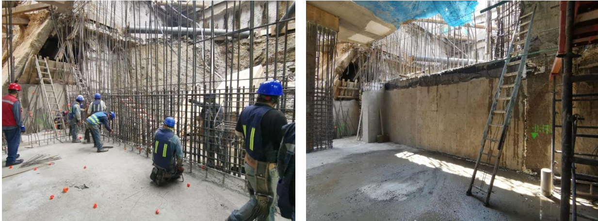
Figura 37. Construcción del muro de contención desplantado en la losa de fondo
