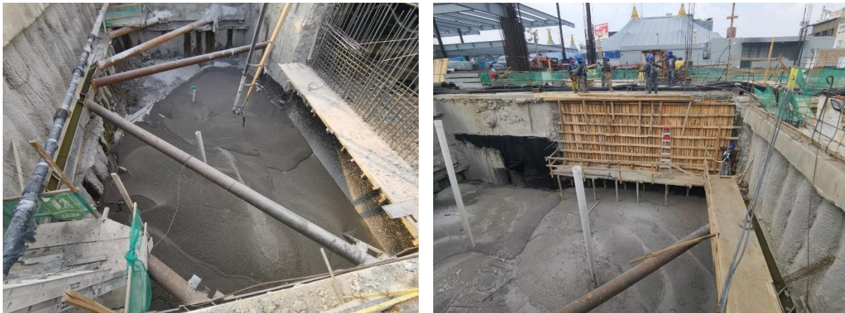
Figura 38. Relleno de la excavación temporal
