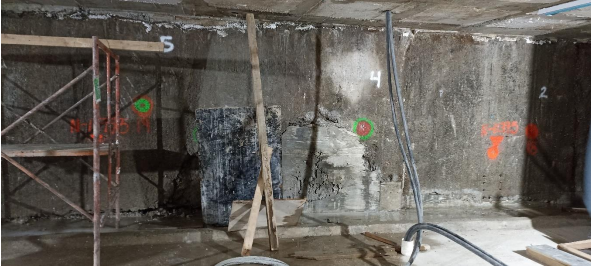
Figura 39. Referencias vistas en obra
