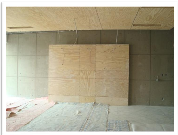
Imagen 187. Muro de concreto aparente, se hicieron las divisiones en bloques de casi un metro por un metro y que se viera simétrico conforme al muro. Autoría propia (2011)
