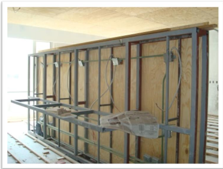
Imagen 93. Habilitado e instalación de estructura a base de ptr 2" x 2" (ligero), para murete cabecera de la recamara principal revestido con triplay de 13mm y base para lavabo de 4.50 m de base y 2.0 m de altura y saliente para lavabo de 0.60 x 3.0 m fijado a piso con taquete de 1/2" Ø. Autoría propia (2011)
