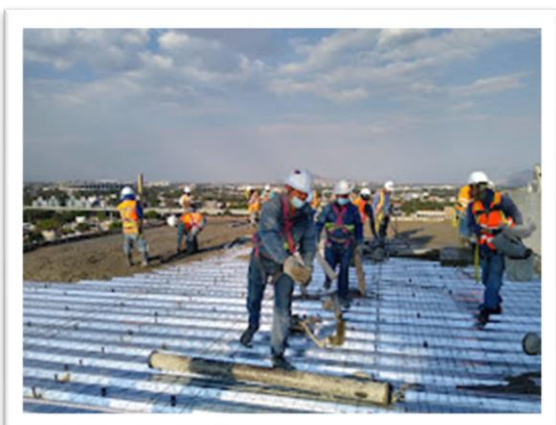
Imagen 64. Colado de losacero en azotea de la torre nivel 10. Autoría propia (2022)
