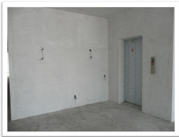
Imagen 69. Acabados en yeso en todos los muros del departamento. Autoría propia (2011)
