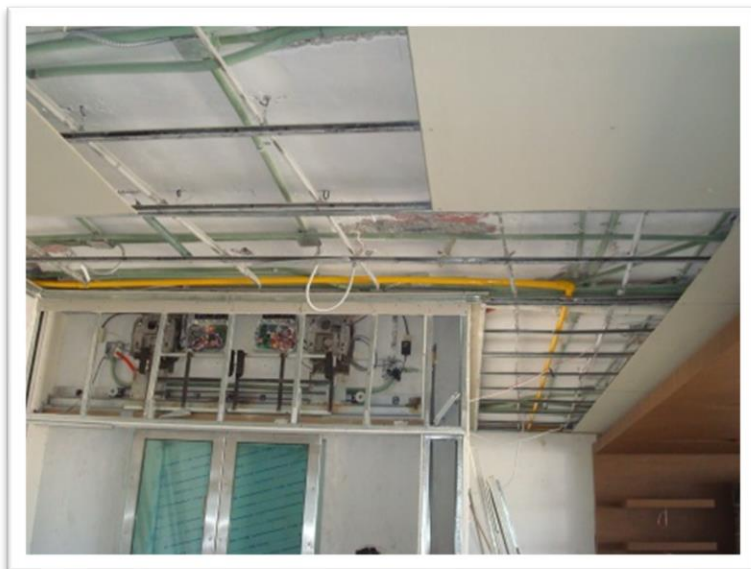
Imagen 130. El tubo amarillo es el recubrimiento (encamisado) de la tubería de gas que se suministró a la chimenea de la sala, todas las instalaciones de gas deben de ir siempre visibles y con ventilación natural, este es un caso especial. Autoría propia (2011)
