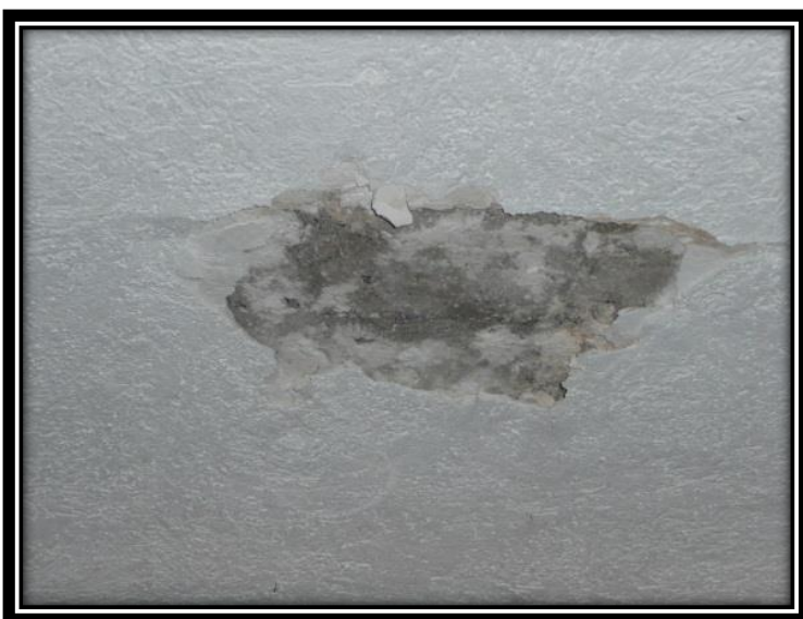
Imagen 267. Retiro de acabados dañados por la humedad en muros y plafones en toda la casa. Autoría propia (2012)
