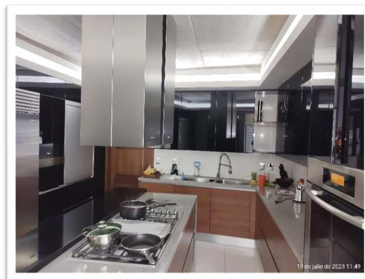
Imagen 231. Vista de la cocina donde se observa el cajillo perimetral para luz indirecta, este cajillo fue realizado en tablaroca, como se puede apreciar se sigue aquí el tono de acabado nogal en las puertas bajo las encimeras. Autoría propia (2011)
