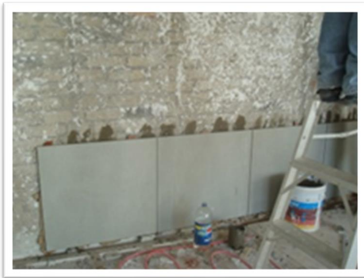
Imagen 168. En todo momento hay que revisar niveles y escuadras de las placas que se van a colocar ya que una vez pegadas es difícil su retiro y se pueden romper, todas las placas deben ser colocadas una por una, este trabajo de colocación de pizarra fue en pasillo de la recámara principal. Autoría propia (2011)
