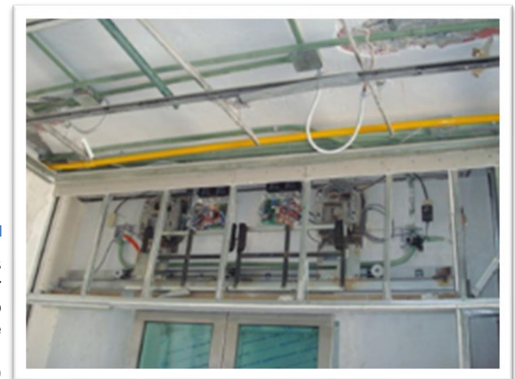
Imagen 111. Cajillo de tablaroca a tres caras para formar faldón y ocultar mecanismo y riel de puerta de acceso principal, este módulo se dejó registrable para dar mantenimiento a los motores. Autoría propia (2011)
