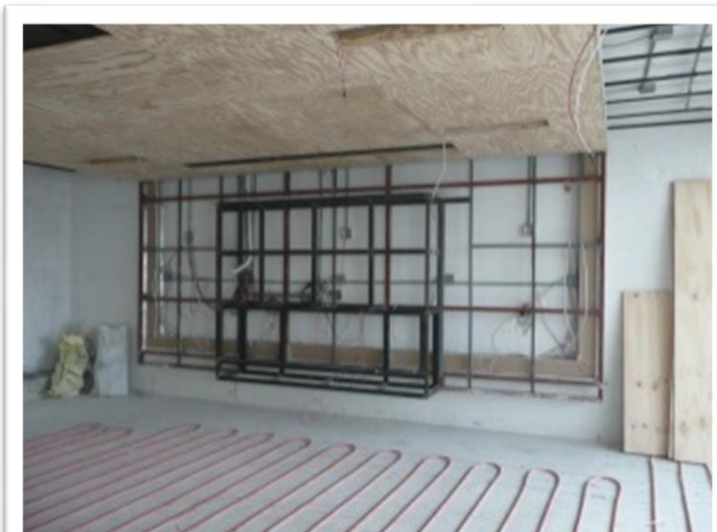
Imagen 134. Ubicación de cajas y cableado en muros donde se vaya a tener equipos como audio y video y dejar todas las preparaciones necesarias, siempre tomen fotos para un futuro saber con qué contamos para instalarnos. Autoría propia (2011)
