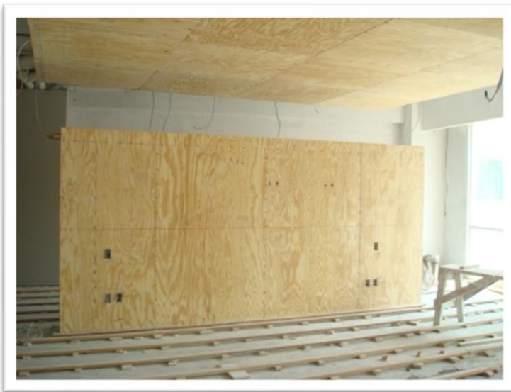
Imagen 178. Instalación de tiras de mdf sobre piso para nivelación y su posterior colocación de hojas de triplay de 19mm. Autoría propia (2011)
