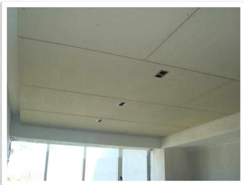
Imagen 117. Colocación de cempapel en plafones de recamara-estudio en hojas de 1.22 x 2.44 mts, fijadas con tornillos aparentes. Además de las perforaciones para las lámparas. Autoría propia (2011)
