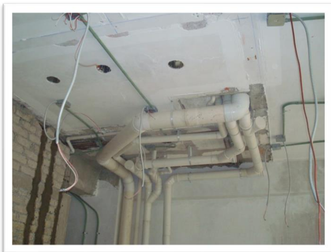
Imagen 75 y 76. Se muestran los trabajos realizados de plomería en el piso superior para llevar a cabo la ampliación del área de la recamara principal. Autoría propia (2011)
