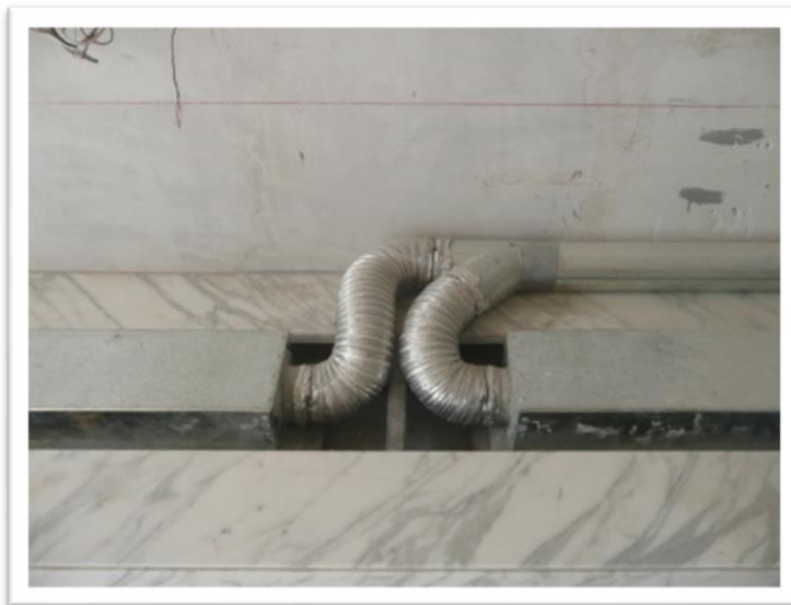
Imagen 147. Colocación de ductos y campanas de extracción de gas quemado en chimeneas, tuberías de 3" de lámina galvanizada. Autoría propia (2011)
