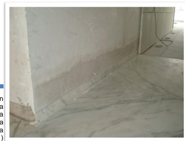
Imagen 85. Aplicación de yeso a plomo en muro de elevador principal del lado del vestíbulo, para recibir tapiz, por tal motivo se le pide al yesero que el acabado sea fino. Autoría propia (2011)
