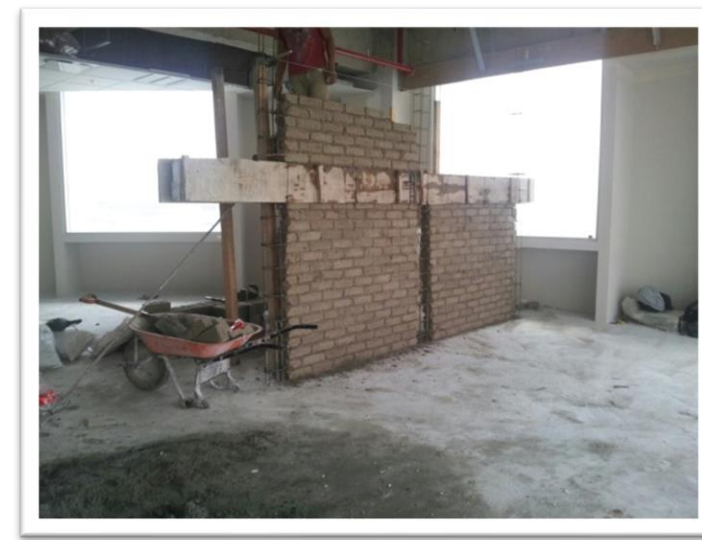
Imagen 81 y 82. Muro de tabicón ligero 6-12-28, reforzado con castillos laterales y cadenas intermedia y cerramiento. Autoría propia (2011)
