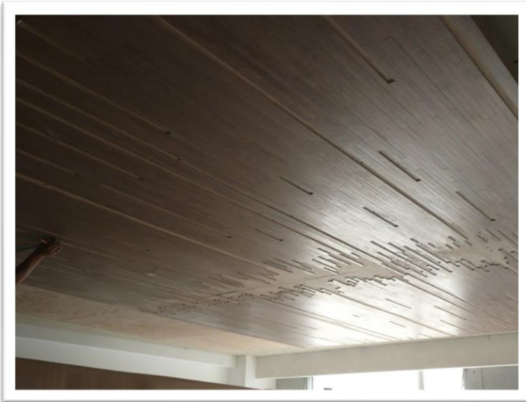
Imagen 114. Detalle de colocación de hojas de mdf con el acabado de nogal en tiras de 2 cm, se dejan espacios entre hojas completas para después terminar in sitio la colocación de las tiras faltantes y así perder la unión entre placa y placa. Autoría propia (2011)
