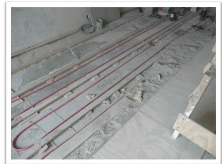
Imagen 179. Instalación de manguera PEX formando serpentines en el piso, y colocación de arena para servir como difusor. Autoría propia (2011)
