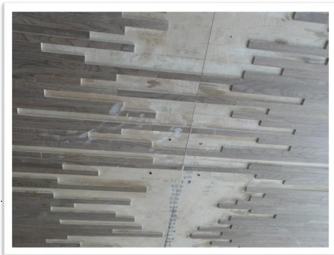
Imagen 209. Colocación de triplay forrado con tiras de madera de 2 centímetros de ancho enchapadas de nogal, detalle de la unión entre módulos. Autoría propia (2011)
