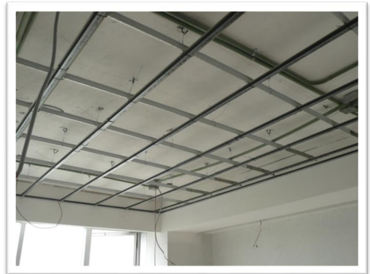
Imagen 116. Armado de canaletas de carga y canal listón sujetadas a techo por medio de anclas de alambro, estos armados deben de rectificarse constantemente sus niveles. Autoría propia (2011)
