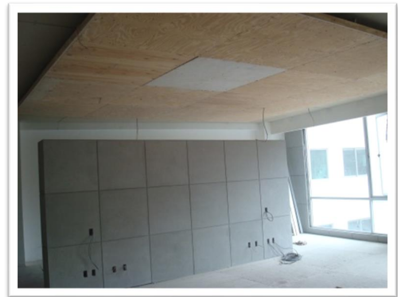
Imagen 113. Se colocó hojas de triplay en el plafón de la recamara principal, este material debe estar bien fijo y a nivel. Autoría propia (2011)
