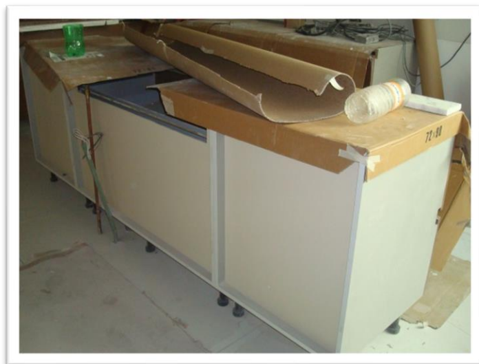
Imagen 197. Una vez instalados los muebles se debe forrar con cartón corrugado para evitar que se maltrate. Autoría propia (2011)
