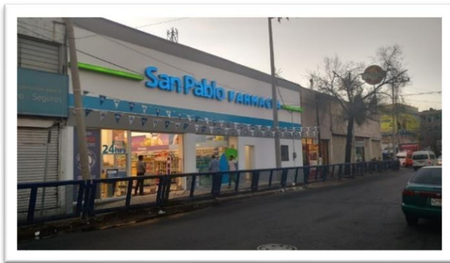
Imagen 41. Fachada de la farmacia San Pablo en Naucalpan Edo. de Mex Autoría propia (2016)
