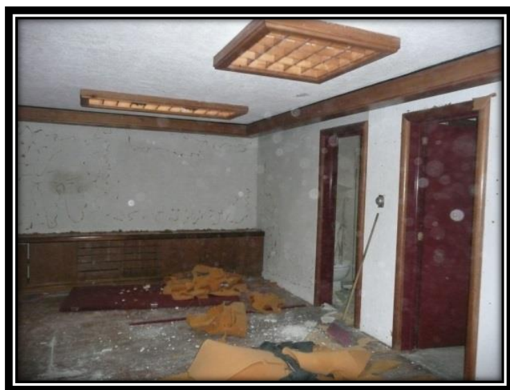
Imagen 248. Retiro de materiales colocados en muros con hule espuma para darle una apariencia acojinada a la tela, así como la alfombra que se ubicaba en todo el piso de madera. Autoría propia (2012)
