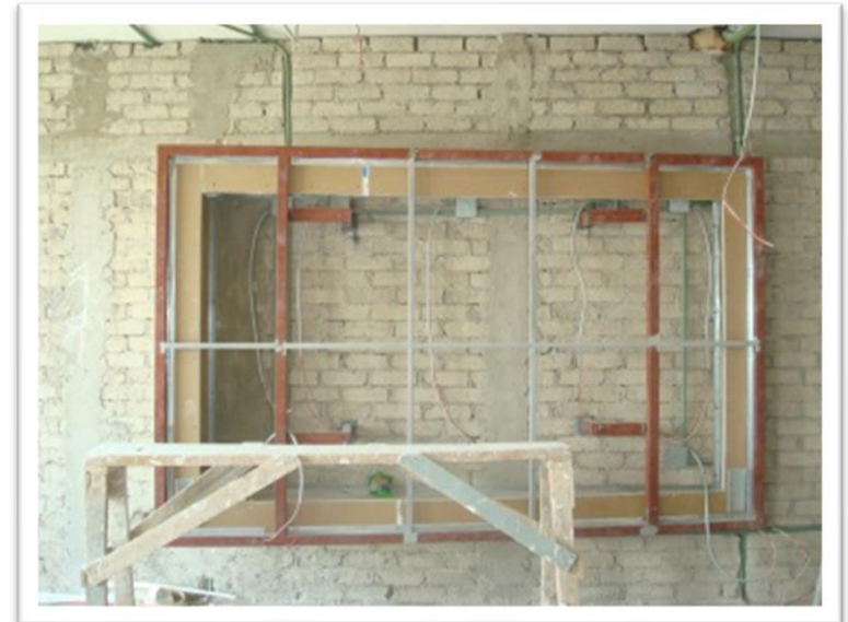
Imagen 95. Habilitado e instalación de bastidor a base de ptr 2" x 2" (ligero) para murete volado del comedor de 3.50 x 1.80 m con armado reticular de .90 x 1.15 m y fijado a muro con taquete de 3/8". Autoría propia (2011)
