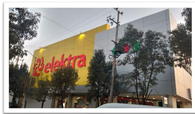
Imagen 43. Vista de tienda Mega Elektra San Buenaventura Ixtapaluca Edo. de Mex Autoría propia (2017)
