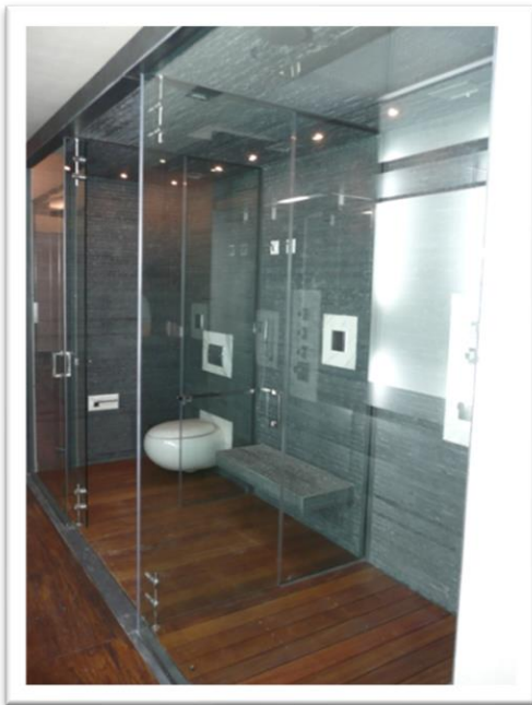
Imagen 199. Colocación de Deck en el piso del baño principal con un bastidor de aluminio de \frac{1}{2} " x 1" en todo el perímetro y a la mitad de las distancias, fijado con tornillos de acero inoxidable. Autoría propia (2011)
