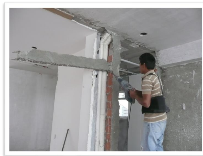
Imagen 78. Demoliciones de elementos de concreto armado por medios mecánicos. Autoría propia (2011)
