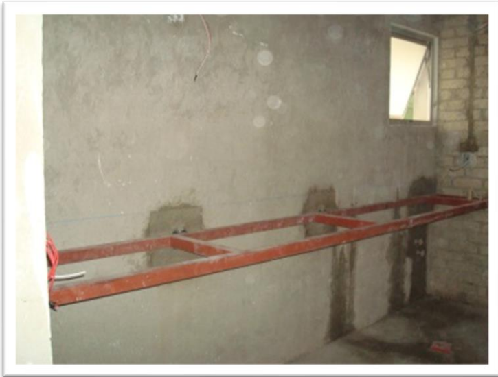
Imagen 94. Habilitado e instalación de estructura a base de ptr 2" x 2" (ligero) para lavabo del baño/vestidor de 3250 x 600 mm fijada a los muros perimetrales con taquete de 3/8" y habilitado e instalación de estructura a base de ptr 2" x 2" (ligero) para lavabo de toilet de 1800 x 600 mm fijada a un muro de fondo y un costado con taquete de 3/8". Autoría propia (2011)
