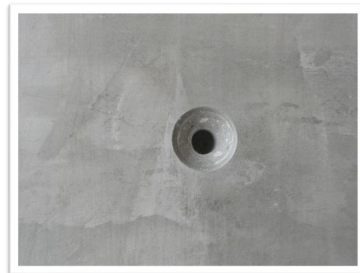
Imagen 188. Detalle de moño hecho con brocas de concreto y fresa cónica, antes de hacerlas se colaron bloques de 5 centímetros para obtener el mismo acabado en el moño. Autoría propia (2011)
