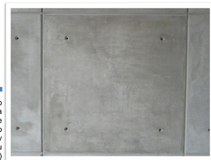
Imagen 185. Detalle de buñas, debido al material, se tuvieron que hacer después de haber enyesado el muro completo, se realizaron en forma de “V” de un centímetro por lado y profundidad. Autoría propia (2011)
