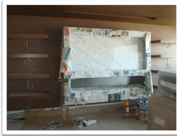
Imagen 210. Grapa de madera en estancia y repisas del mismo material se enmascara el mármol de la chimenea para que se aplique la capa de barniz transparente. Autoría propia (2011)
