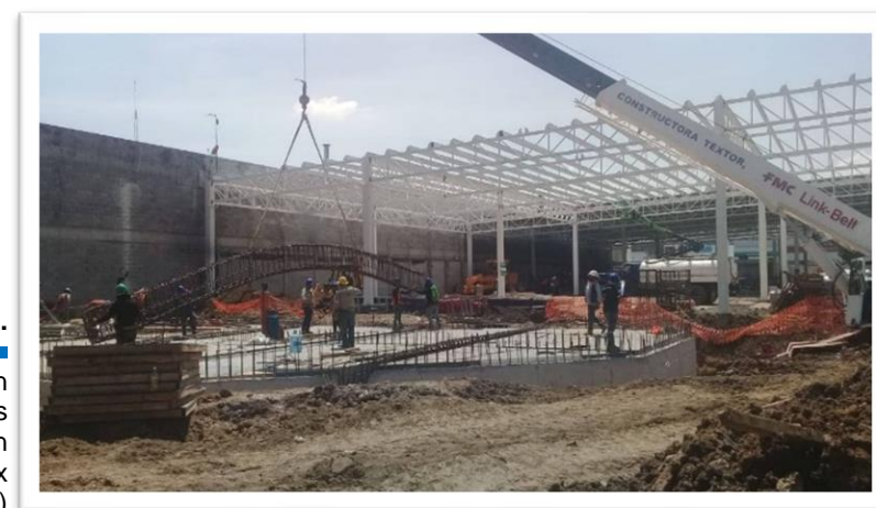
Imagen 49. Vista de trabajos de colocación de armado de traves superiores en cisterna de Sodimac, San Mateo Naucalpan Edo de Mex Autoría propia (2019)
