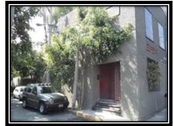
Imagen 250. Vista del edificio desde la esquina de Galeana y Periférico acceso peatonal. Autoría propia (2012)
