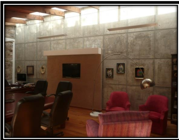
Imagen 299. Oficina Dirección General, en ella se propuso un muro de concreto aparente y el cambio de piso, de alfombra por madera, además de un lambrin de tablaroca que pudiera contener la pantalla de proyección. Autoría propia (2012)
