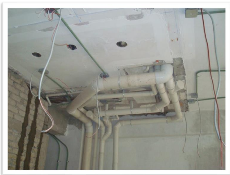
Imagen 122. Modificación de tuberías sanitarias del edificio para su reubicación, y poder incorporarlas en su ubicación original en el nivel posterior, para este trabajo se tuvo que pedir permiso a la administración y realizar el cálculo de las tuberías modificadas y que fueran avaladas por los constructores del edificio Autoría propia (2011)
