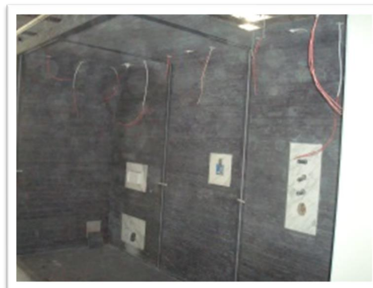
Imagen 139. Se deben dejar las preparaciones de las salidas eléctricas en su lugar indicado, esto para no tener problemas de encontrar los cables para su instalación posterior. Autoría propia (2011)
