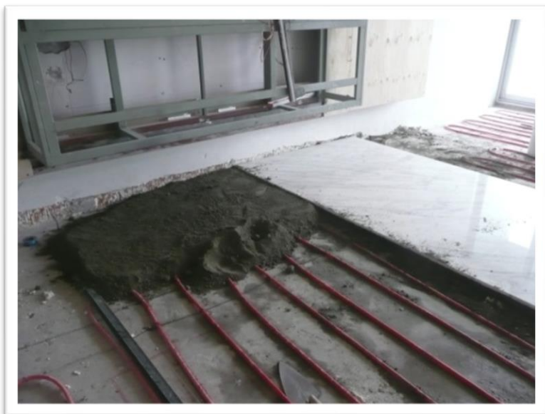
Imagen 162. La mezcla que se usa por lo general es a base de cemento-arena para dar el nivel requerido y en otras ocasiones solo es necesario usar un adhesivo para mármol. Autoría propia (2011)
