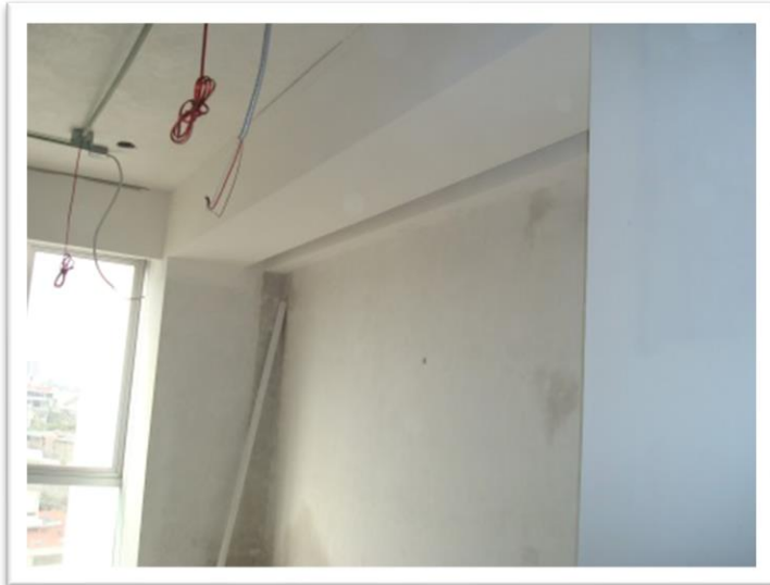
Imagen 108. Recamara-Estudio. Cajillo de tablaroca a cinco caras para formar cajillo, cajillo de tablaroca a dos caras para formar trabe al lado de cajillo – nicho, cajillo de tablaroca a cuatro caras para formar cortinero en estudio incluye can de madera para colocar lámpara, lambrín de tablaroca para formar columna en estudio. Autoría propia (2011)
