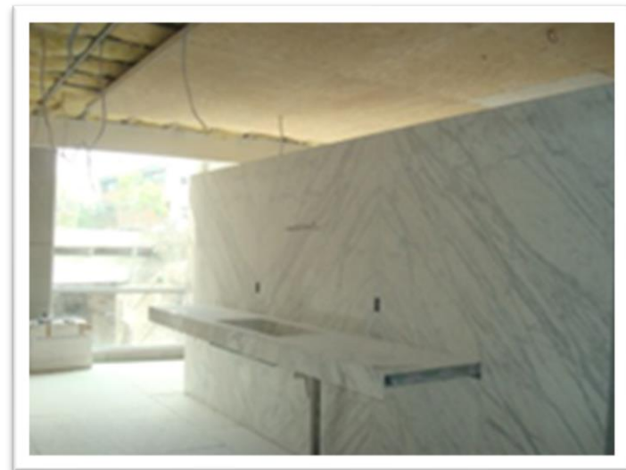
Imagen 177. Realizaci6n de lavabo de recamara principal en muro divisorio que sirve de cabecera por el otro lado, como se puede observar en esta imagen siempre se trata de que las placas coincidan en sus vetas. Autoría propia (2011)
