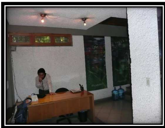
Imagen 346 y 347. Ampliación de espacios por medio de la demolición de muros que formaban una bodega y cuarto de bombeo, se cambió el piso por porcelanato. Autoría propia (2012)
