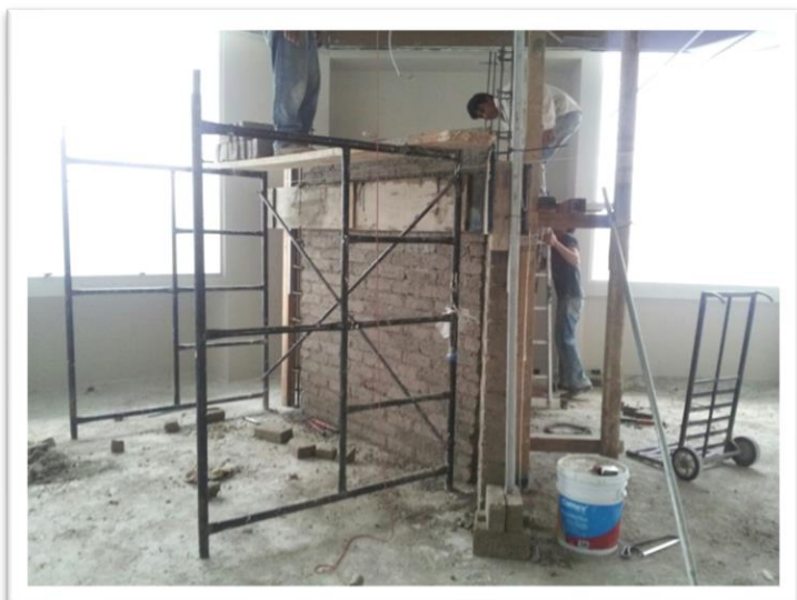
Imagen 81 y 82. Muro de tabicón ligero 6-12-28, reforzado con castillos laterales y cadenas intermedia y cerramiento. Autoría propia (2011)
