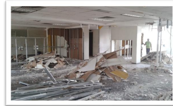
Imagen 36. Vista de los trabajos de desmantelamiento de oficinas. Autoría propia (2015)
