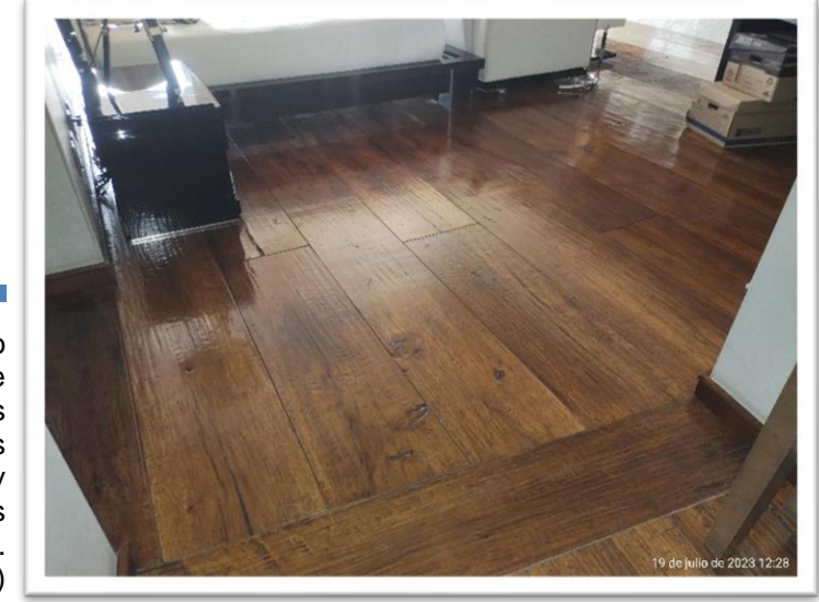
Imagen 181. Instalación de piso de ingeniería, este piso se suministró en variadas medidas que van desde los 20 hasta los 50 centímetros de ancho y largos desde los 1.50 hasta los 2.50 metros. Autoría propia (2011)
