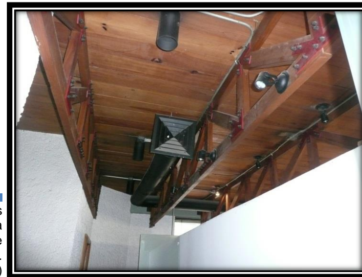
Imagen 261. La ventilación de los espacios en esta zona la realizaban por medio de extractores mecánicos. Autoría propia (2012)
