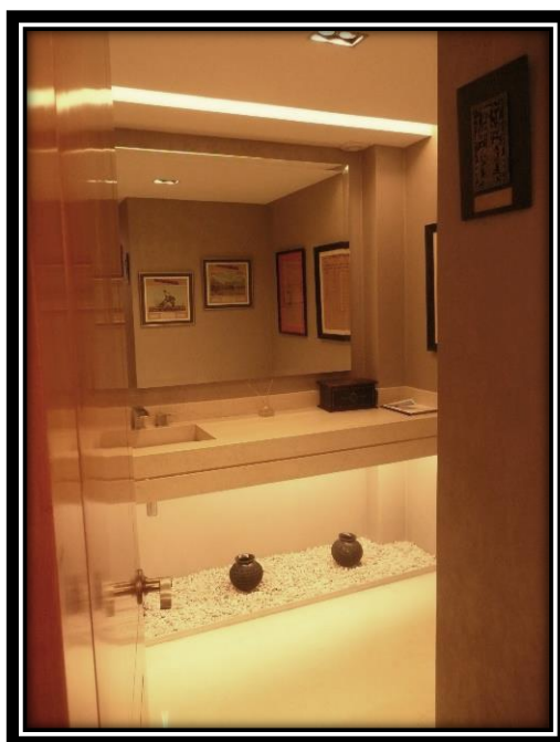
Imagen 301. Acceso a baño de oficina de Dirección General, se forjó un lavabo y barra de mármol sobre estructura de herrería, y en los muros se colocó papel tapiz color gris, así como iluminación por medio de cajillos y lámparas dirigibles hacia muros, la ventilación se hizo artificialmente por medio de un extractor. Autoría propia (2012)
