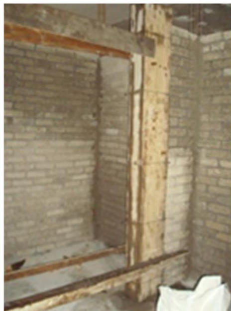
Imagen 87. Colocación de cimbrado para colado de castillo en murete de baño en recámara-estudio, durante el cimbrado de todos los elementos de concreto se debe aplicar desmoldante o en su caso aceite quemado a la cimbrado para que no se adhiera al concreto. Autoría propia (2011)
