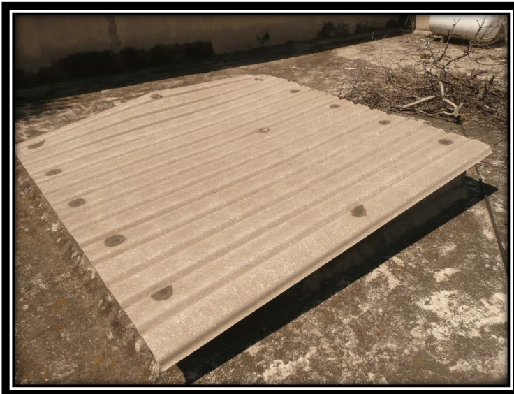
Imagen 273. En el domo de la planta alta se tenía una lámina de fibra de vidrio lo que no permitía el paso de la luz solar. Autoría propia (2012)
