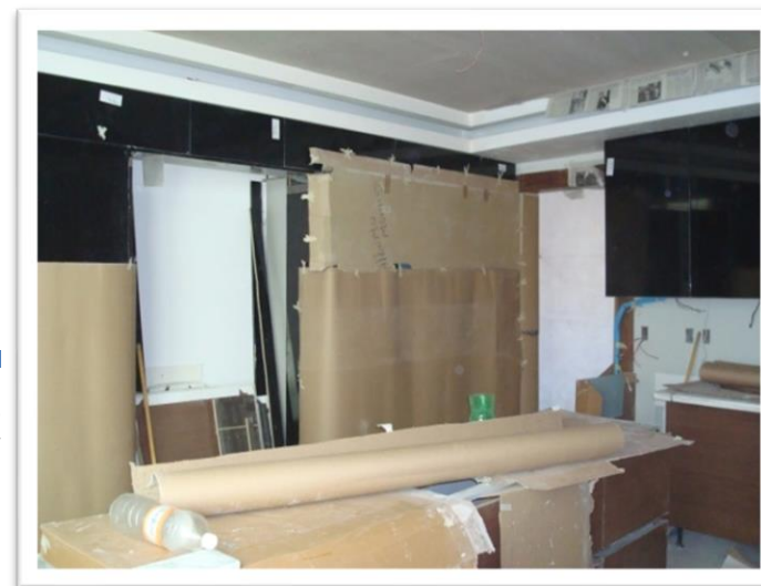
Imagen 198. Las instalaciones de los muebles deben de ser como se estipula en la guía mecánica, lo que nos permite tener mínimos errores. Autoría propia (2011)
