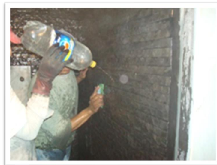
Imagen 170. Limpieza de juntas de Slate Negro a base de cepillo de ixtle y agua para su posterior sellado con productos especiales que le darán mayor durabilidad. Autoría propia (2011)
