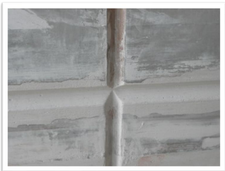
Imagen 185. Detalle de buñas, debido al material, se tuvieron que hacer después de haber enyesado el muro completo, se realizaron en forma de “V” de un centímetro por lado y profundidad. Autoría propia (2011)
