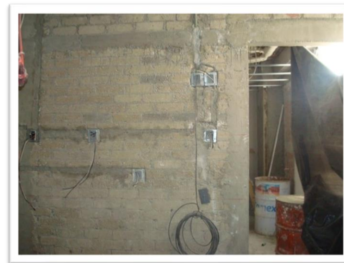
Imagen 196. Instalación de contactos eléctricos de acuerdo con especificaciones de guía mecánica proporcionada por el vendedor. Autoría propia (2011)
