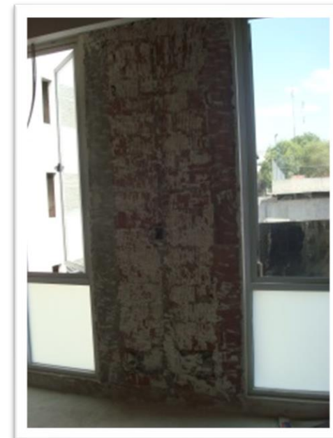
Imagen 84. Retiro de yeso en todos los muros de la recamara principal para recibir piedra caliza, es necesario retirar el acabado para que su adherencia al muro sea mejor. Autoría propia (2011)
