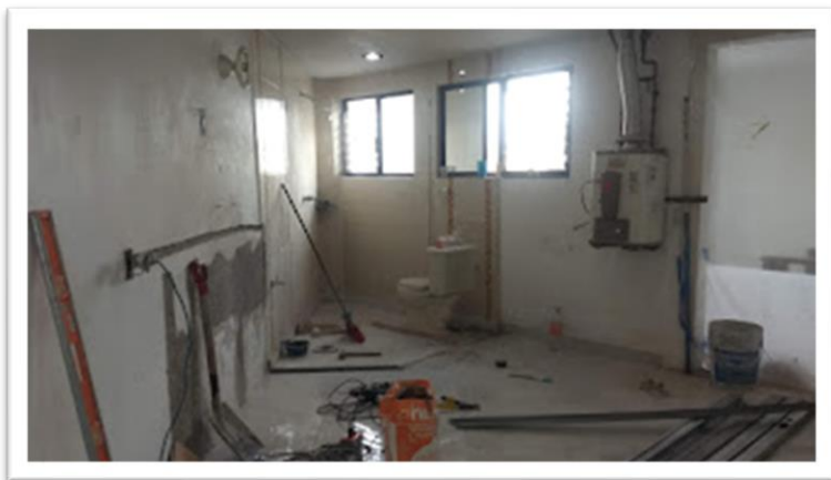
Imagen 55. Desmantelamiento de cancelas en baño y retiro de calentador de gas para su reubicación Autoría propia (2020)
