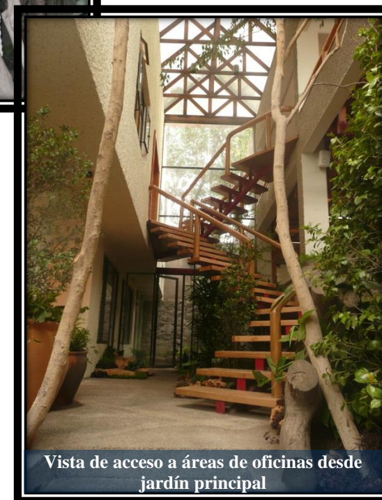
Imagen 314 y 315. Se demolió el muro que no permitía la visión total de la interconexión a doble altura que es enmarcada con el domo de cristal y las armaduras de madera, se logró ampliar la vista cambiando el arranque de la escalera de manera frontal. Autoría propia (2012)
