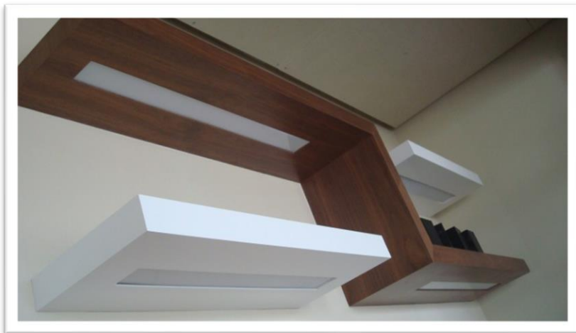
Imagen 211. Repisas flotantes de mdf con acabado en chapa en nogal y laca blanca respectivamente, se instalaron sobre herrería de ptr fijado con taquetes de expansión y tornillos cabeza hexagonal. Autoría propia (2011)
