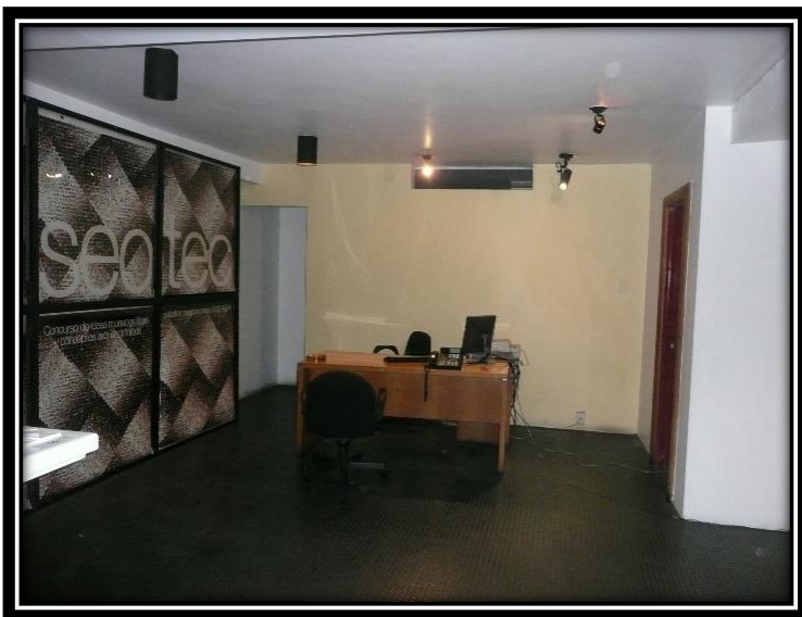
Imagen 256. En esta zona se retiró el material plástico que se tenía en el piso el cual fue sustituido por porcelanato y se construyó un muro divisorio para confinar el site y el departamento de sistemas. Autoría propia (2012)
