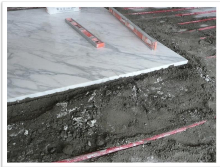
Imagen 160. Nivelación de placas y retiro de mezcla sobrante, se debe de tener cuidado especial al contar con las mangueras de la calefacción en piso ya que una perforación causaría problemas posteriormente. Autoría propia (2011)
