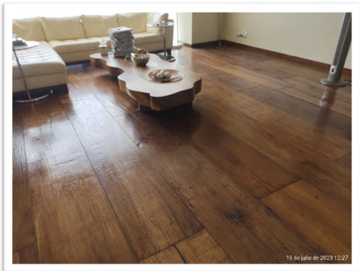
Imagen 182. Vista del piso ya instalado en la recámara-estudio posteriormente se le aplica una capa de barniz especial a base de resinas que lo proteja contra escurrimientos y maltrato. Autoría propia (2011)
