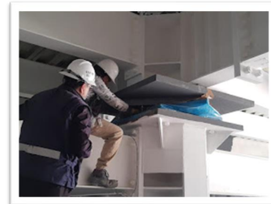
Imagen 63. Revisión de los aisladores sísmicos que se colocaron en todas las columnas. Autoría propia (2021)
