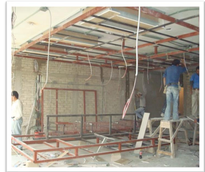
Imagen 92. Habilitado e instalación de bastidor en reamara a base de perfil tubular de 2" x 2" revestido de triplay de 13mm para recibir posteriormente el montaje de plafón de madera de 5.70 x 5.30 m fijación a losa con taquete de 1/2"Ø. Autoría propia (2011)
