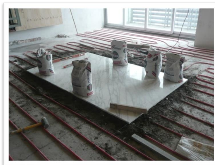
Imagen 161. Una vez nivelada se le colocan pesos como bultos de cemento, para que se adhiera lo mejor posible la placa a la mezcla. Autoría propia (2011)
