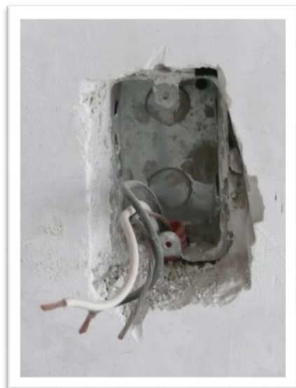
Imagen 72. En ocasiones solo vienen las puntas de los cables eléctricos divisorio. Autoría propia (2011)
