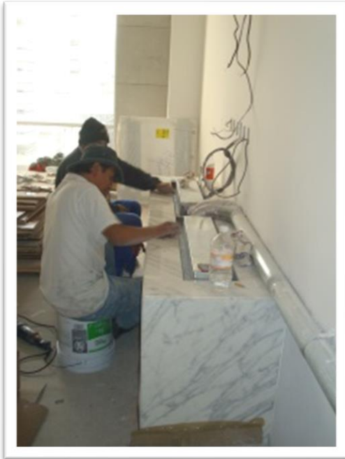
Imagen 204. Ambas chimeneas se realizaron forrando con mármol del mismo tipo del que se colocó en el piso de la estancia, una vez colocado el mármol se procedió a pulir los frentes y la parte superior del mismo. Autoría propia (2011)
