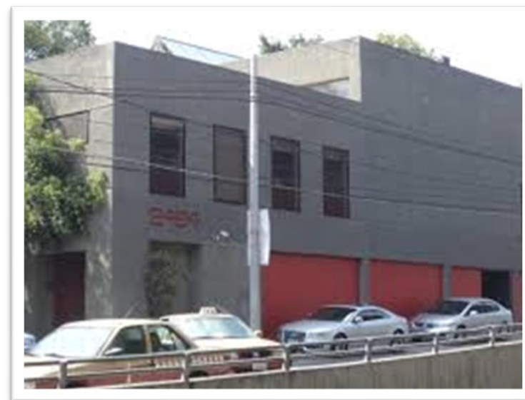
Imagen 246. Vista de la fachada principal Edificio de Oficinas CIF desde anillo periférico. Autoría propia (2012)
