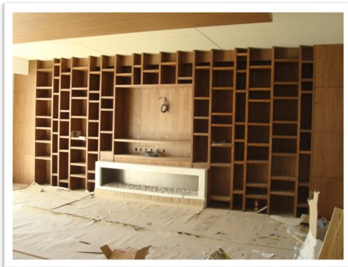
Imagen 208. Librero en recamara principal fabricado en mdf forrado con chapa de nogal, para este trabajo se diseñó por donde pasarían las tuberías de gas quemado y donde quedarían las conexiones de audio voz y datos y las eléctricas. Autoría propia (2011)
