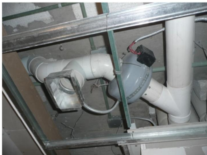
Imagen 145. Todo el proyecto se debe de realizar antes de colocar los plafones de tablaroca, para realizar adecuaciones en plafones de ser necesarias. Autoría propia (2011)
