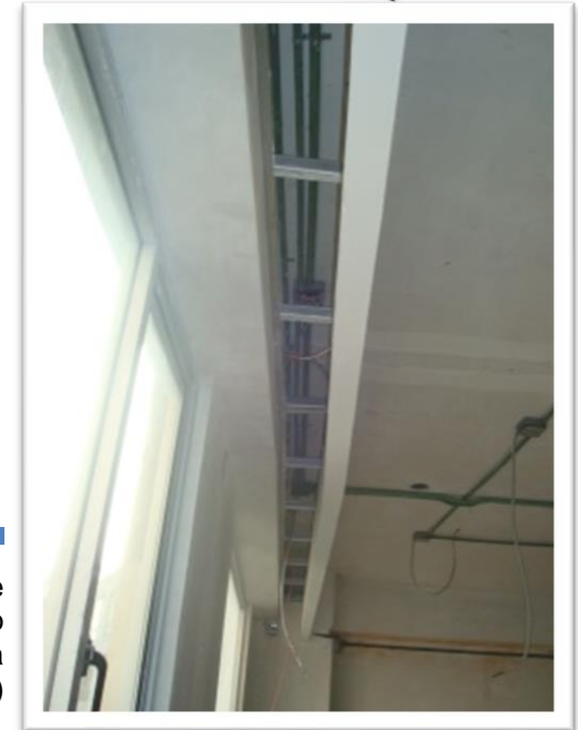
Imagen 109. Recamara principal. Cajillo de tablaroca a cuatro caras para formar cortinero en recamara principal incluye can de madera para colocar lámpara. Autoría propia (2011)
