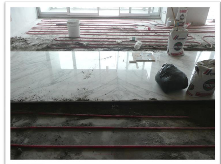
Imagen 164. En estas placas se puede apreciar que la colocación debe regirse por las vetas de las placas, se deberá iniciar su colocación por el centro del espacio para llevarnos los ajustes de ser necesarios hasta el perímetro de esta. Autoría propia (2011)
