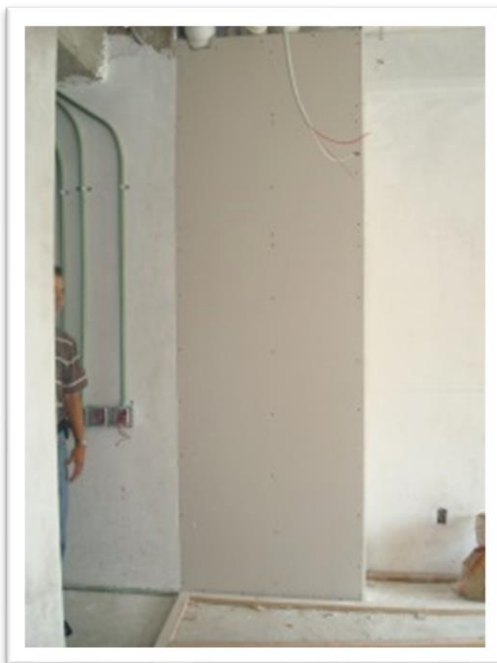
Imagen 110. Lambrin de tablaroca para ocultar instalaciones por modificación de ductos de desagüe del nivel superior. Autoría propia (2011)
