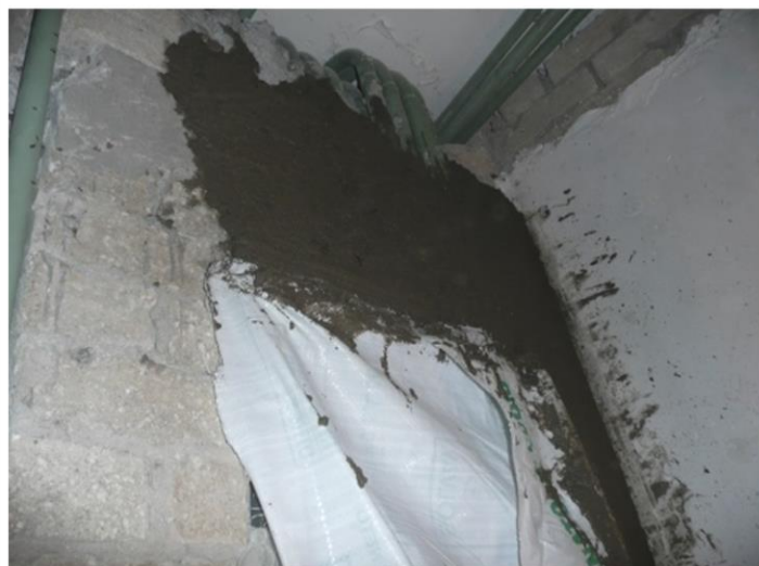
Imagen 89. Colado de tablero eléctrico en muro del site, debido a que no solo se puede resanar, esto evitara grietas en un futuro. Autoría propia (2011)
