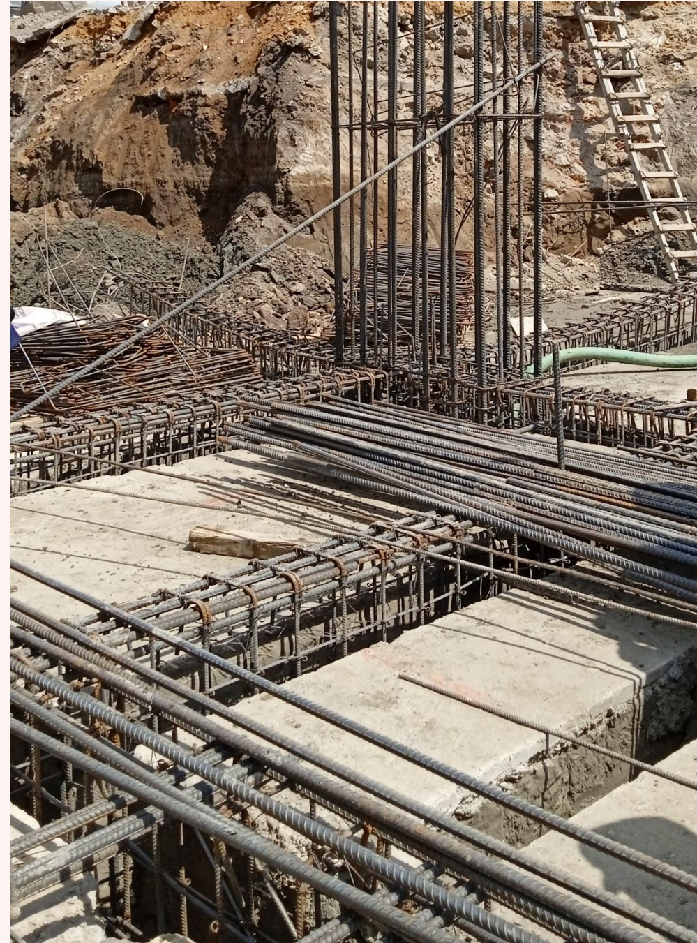
Zeno Ramos, B. (2023). Cimentación profunda para edificio de departamentos. [Fotografía].
