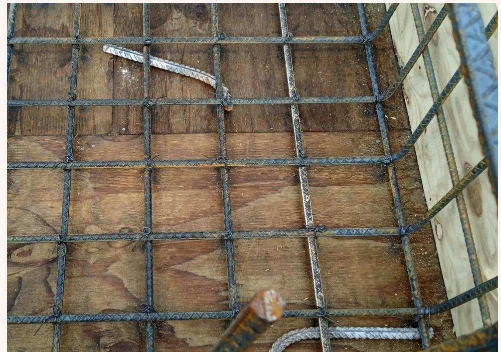
Zeno Ramos, B. (2023). Cimbra armada lista para colar. [Fotografía].
