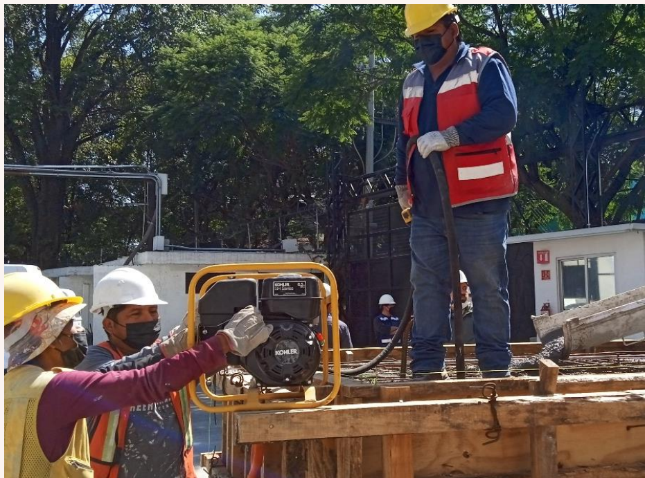
Zeno Ramos, B. (2023). Vibración del concreto. [Fotografía].
