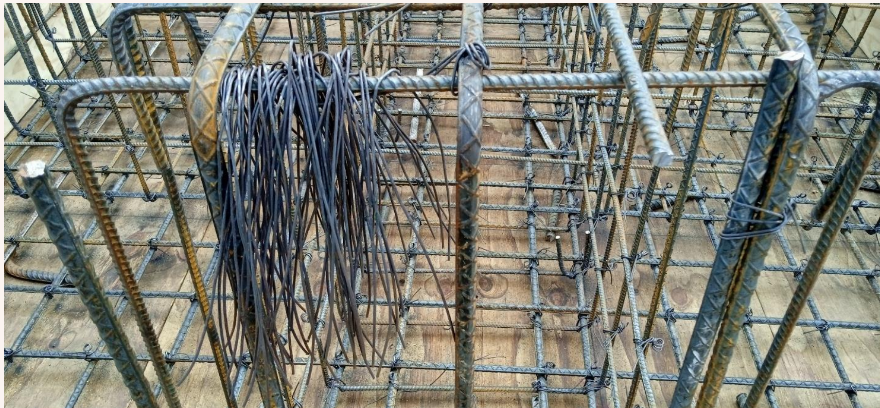
Zeno Ramos, B. (2023). Alambraón cortado y varillas. [Fotografía].
