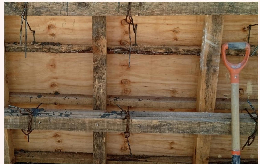
Zeno Ramos, B. (2023). Cimbra con concreto. [Fotografía].
