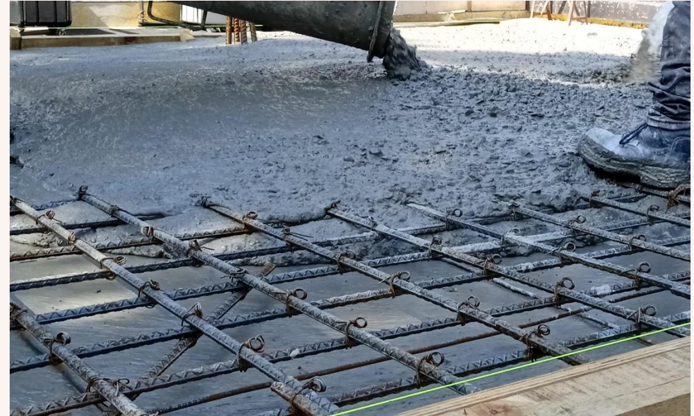
Zeno Ramos, B. (2023). Distribución del concreto . [Fotografía].
