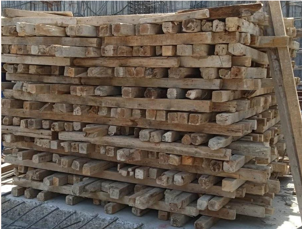
Zeno Ramos, B. (2023). Armado de cimbra. [Fotografía].
