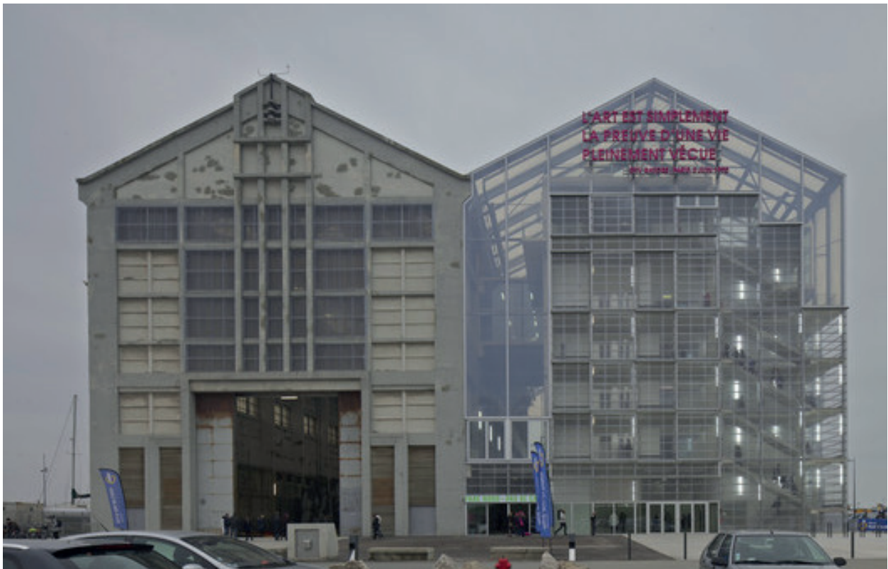
Ilustración 31. (2015). Fachada del proyecto FRAC Dunkerque, Lacaton & Vassal.
