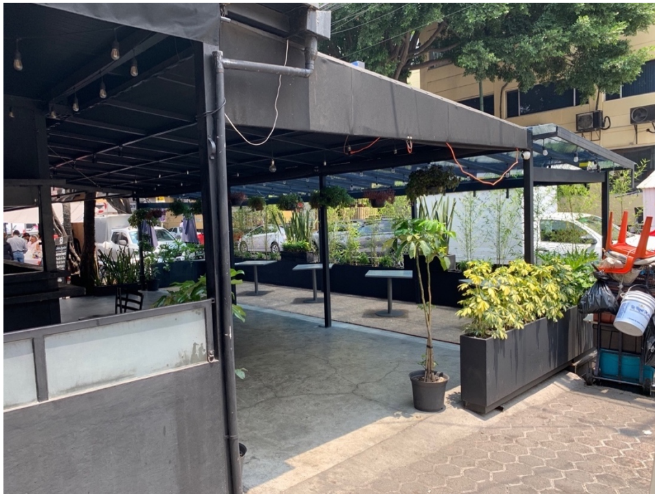
FIGURA 4.26. Toldo metálico fijado al suelo.
