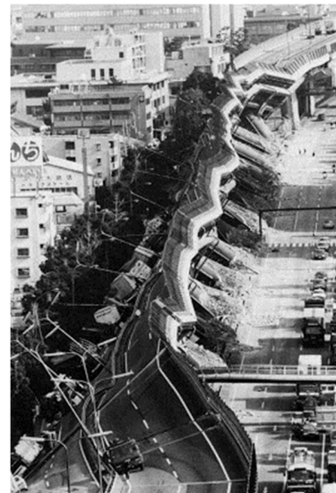
Figura 2.7 Pérdida de resistencia al corte, en Kobe, Japón (1995). (Google, s.f.)
