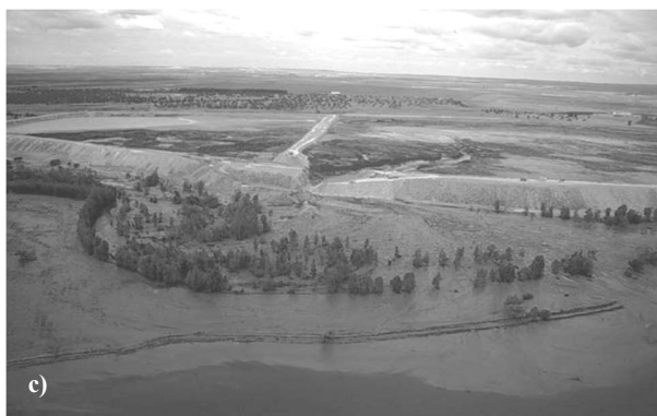
Figura 2.15 Falla de Presas de Residuos Mineros
