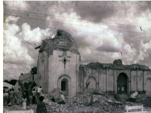
Figura 2.18 Daños en la antigua iglesia de Sta. Rosa de Lima, Jáltipan, Ver.
