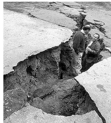
Figura 2.6 Agrietamiento y desplazamiento lateral, presente en el sismo de Loma Prieta, California, EE.UU. (Google, s.f.)
