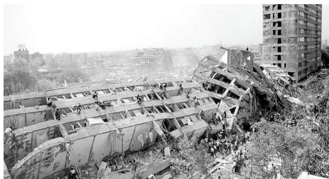
Figura 2.25 Derrumbe del edificio Nuevo León, en la Unidad Habitacional Nonoalco Tlatelolco, Ciudad de México, 1985. (Google, s.f.)
