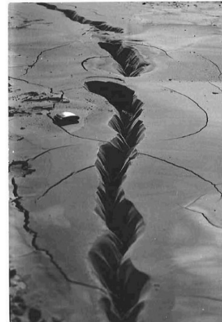
Figura 2.21 Efecto de licuación posterior al sismo en Mexicali, Baja California, en 1979 (Google, s.f.)
