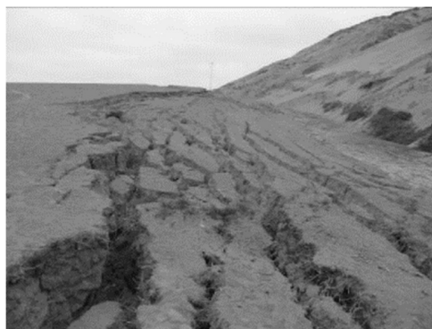
Figura 2.8 Desplazamiento lateral en Pisco, Perú (2007) (Zavala et al., 2008)
