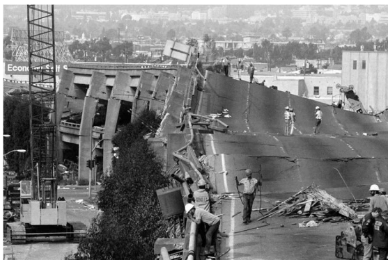
Figura 2.5 Efectos de licuación posteriores al sismo en Loma Prieta en California, EE.UU. (1989). (Google, s.f.)
