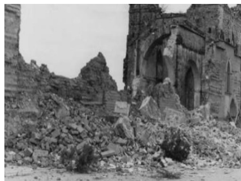
Figura 2.19 Daños reportados después del sismo del 5 de octubre de 1975, Chiapa de Corzo, México (Google, s.f.)
