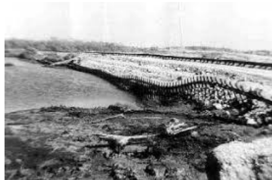
Figura 2.24 Daños provocados por el tsunami después del sismo en Lázaro Cárdenas, Michoacán (1985) (Google, s.f.)
