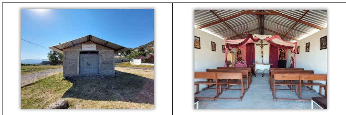
Figura 24. Fachada de la capilla (izq.) y vista al interior de la capilla (der.).
