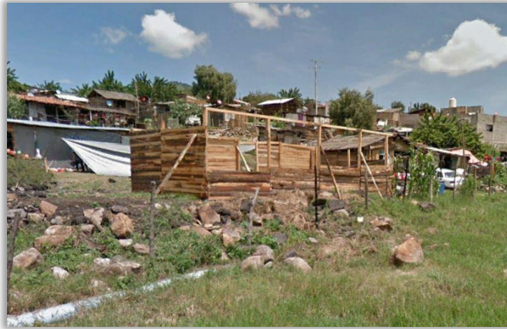
Figura 9. Construcción de la escuela primaria 2017.
