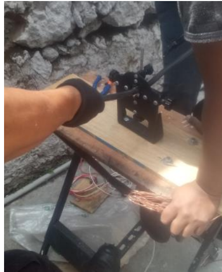
Figura 42. Pelado de cable con máquina desforadora
