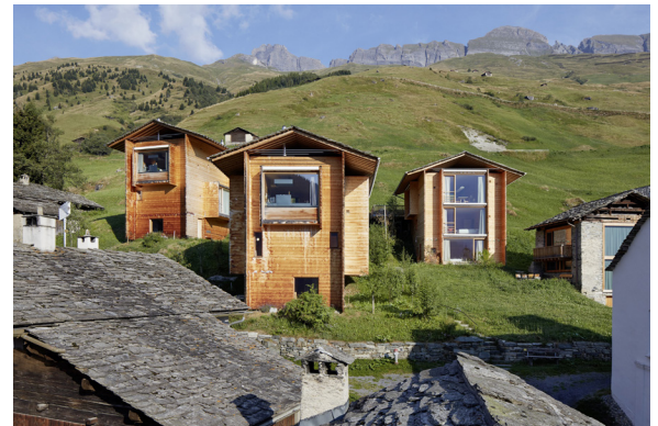
Fig 47. Leis Houses, Peter Zumthor, Fotografía: Ralph Feiner.
