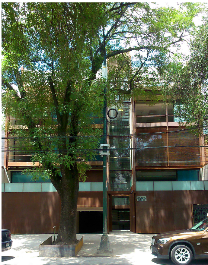
Fig.10. Edificio Eugenio Sue 56 Colonia Polanco Año 2016 Sánchez Arquitectos y Asociados. Fotografía Giovanni Puebla.
