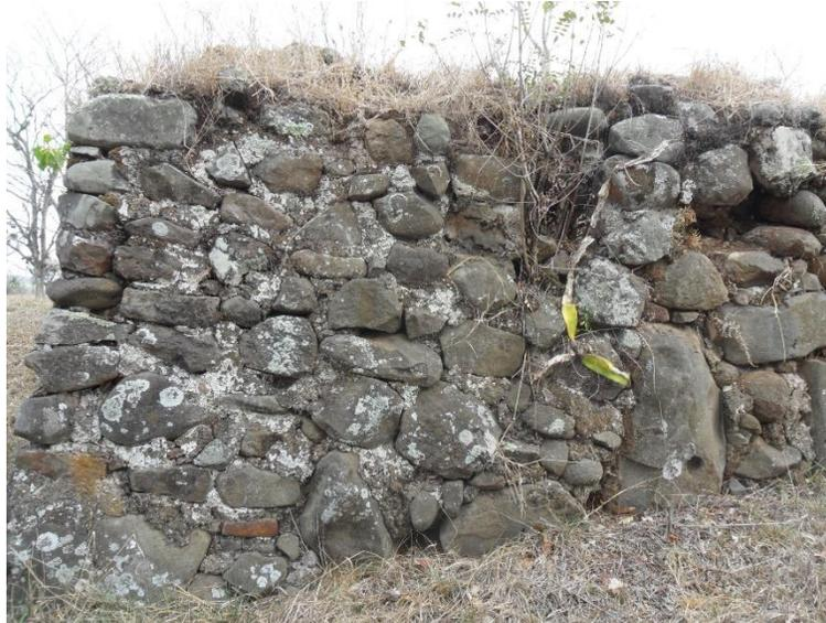
Figura 4.21. Estructura arquitectónica en El Castillo; nótese los sillares, cementante y estuco, técnica constructiva ausente en la mayoría de los elementos arquitectónicos estudiados en Zentla (registro fotográfico de la autora 2011).
