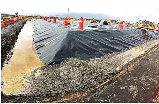
Membrana sobre las primeras dos capas antes de activar el vacío
