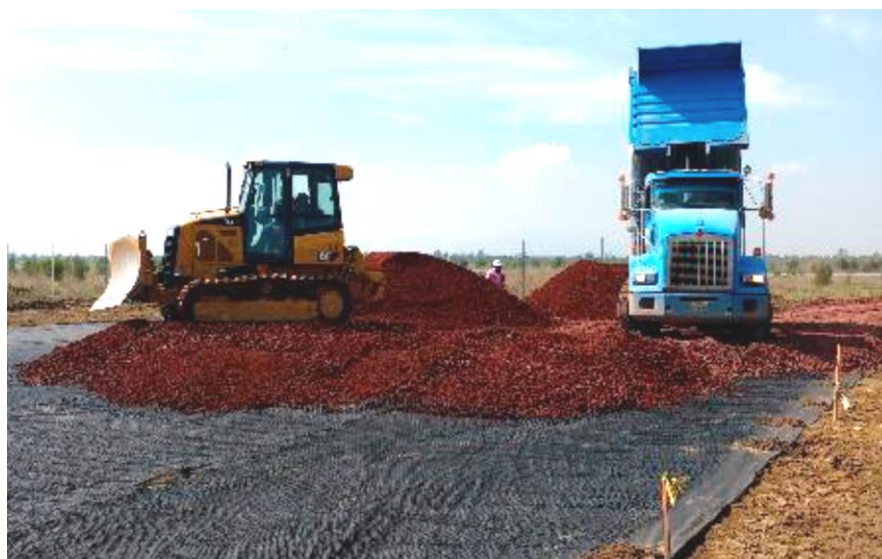
Figura 2.2 Colocación de material de precarga (PIMOSA, 2016).
