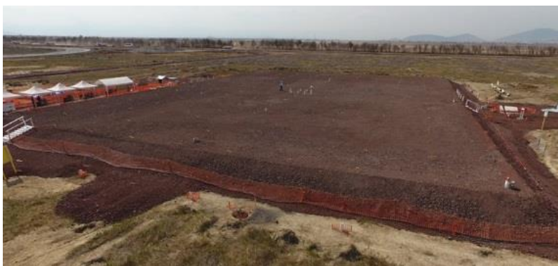
(c) Tramo de prueba terminado
