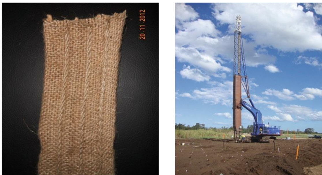
Figura 2.15 Fotografía de un NPVD (izquierda) e instalación de NPVDs en el proyecto de Ballina Australia (derecha) (Sanyal, 2017).
