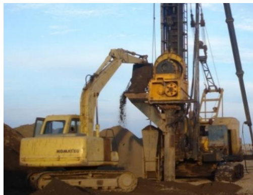
Figura 2.4 Construcción de drenes verticales de arena (ISM, 2019).
