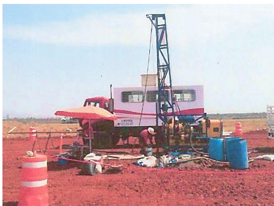
Sondeo de Penetración Estándar (SPT)*
