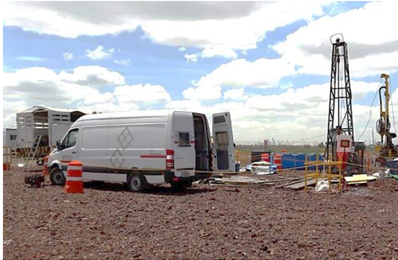
Ensayo de Sonda Suspendida (ESS) (II-UNAM, 2018)
