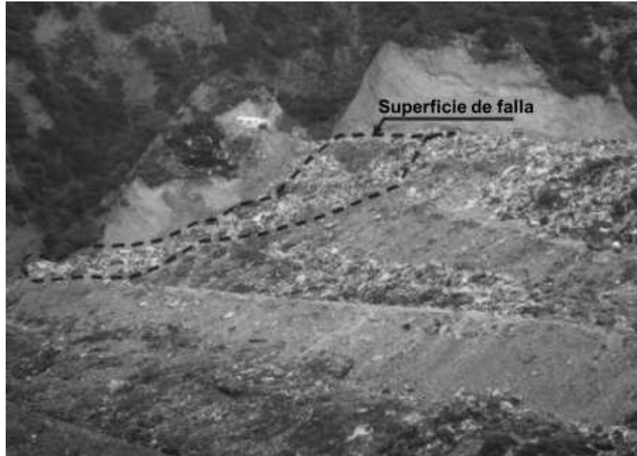
Figura 2.10. Falla del talud del relleno sanitario Xerolakka. (Zekkos, et al. , 2010).
