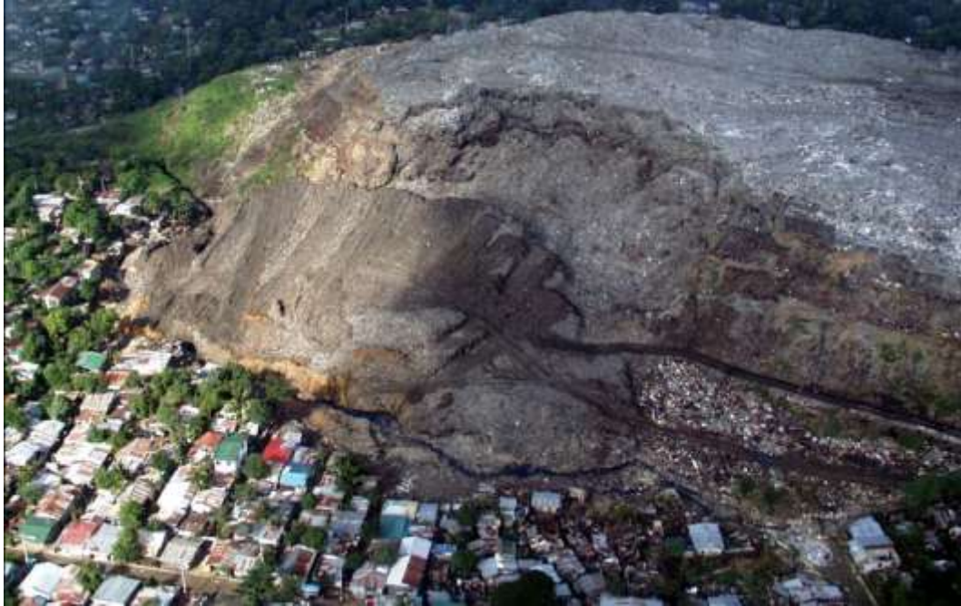
Figura 2.9. Falla del talud del relleno sanitario Payatas. (S.M. Merry, 2000).
