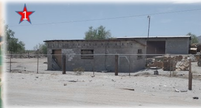
Foto 1. Mexicali, Baja California. 32°20'13.9"N 115°19'46.5"W Rentería, 21730 Co. La Puerta, B.C.
