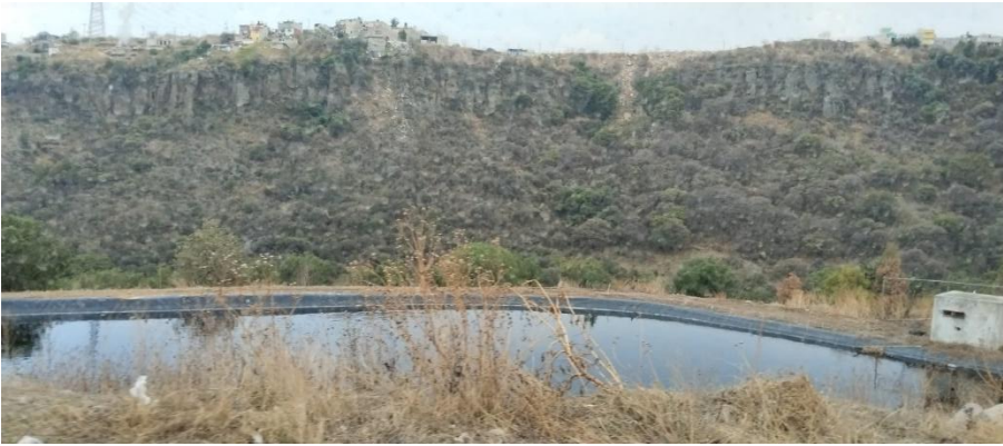
Laguna de Lixiviados
