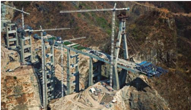
Figura 2.29. Apoyos del Puente Baluarte (SICT, 2015)
