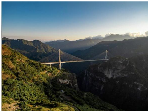
Figura 2.28. Puente Baluarte ( www.mexicodesconocido.com.mx )
