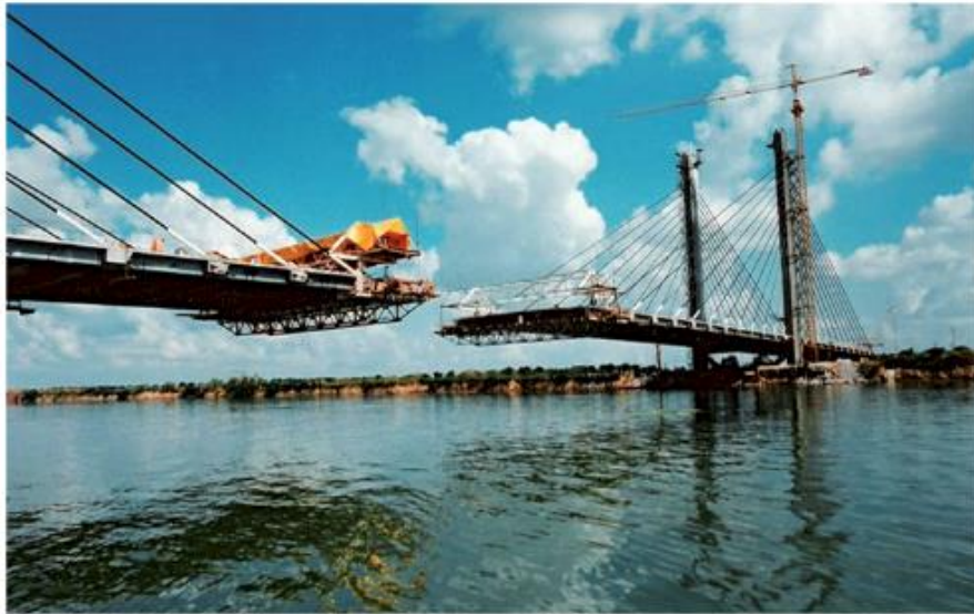
Figura 2.25. Tirantes del Puente Papaloapan (SICT, 2015)
