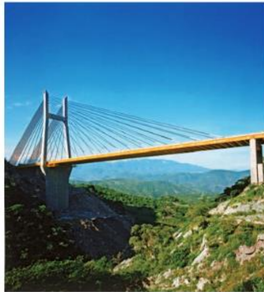
Figura 2.21. Atirantamiento del puente Barranca El Zapote (SICT, 2015)
