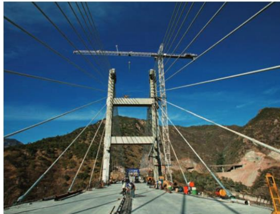
Figura 2.31. Superestructura del Puente El Carrizo (SICT, 2015)
