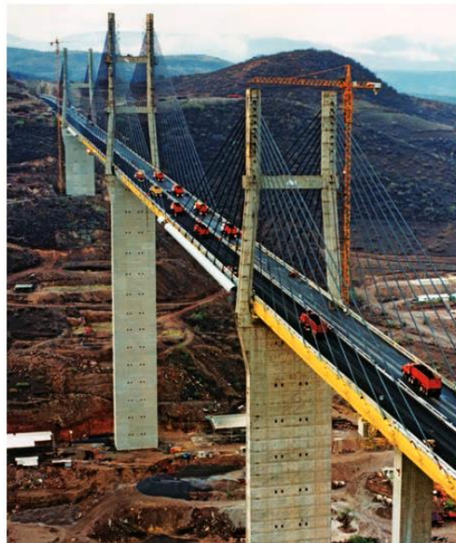
Figura 2.16. Vista general del puente Mezcala (SICT, 2015)
