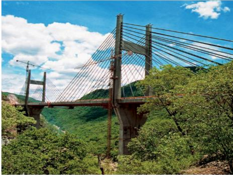
Figura 2.19. Atirantamiento del puente Quetzalapa (SICT, 2015)
