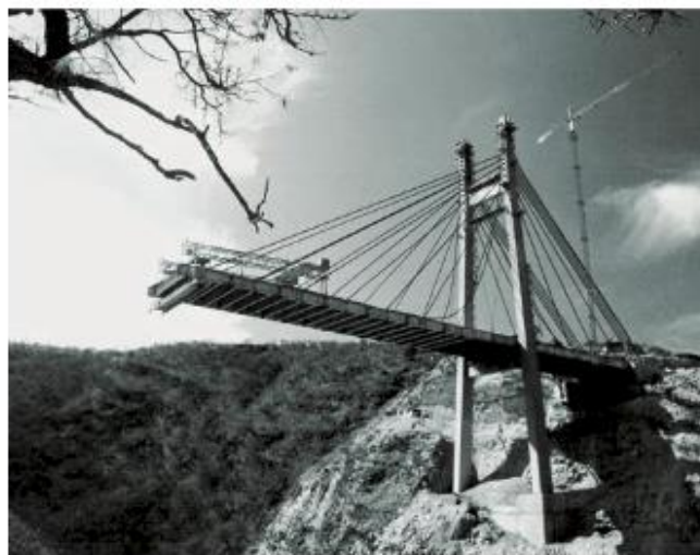
Figura 2.23. Tirantes del Puente Barranca El Cañón (SICT, 2015)
