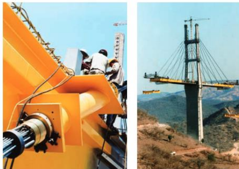
Figura 2.17. Anclaje y tirantes del puente Mezcala (SICT, 2015)
