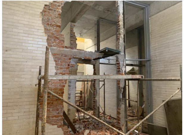
Trabajos de demolición. Foto: Fernando Nájera Fragoso
