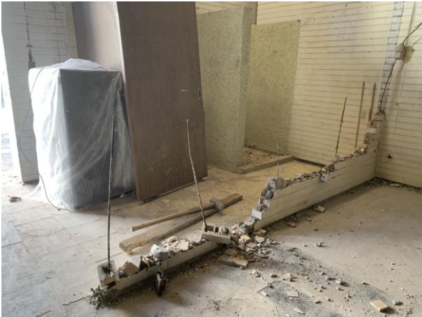
Trabajos de demolición. Foto: Fernando Nájera Fragoso
