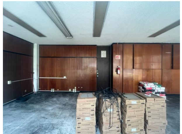
Adecuación de oficina a aula en edificio 2. Foto: Fernando Nájera Fragoso
