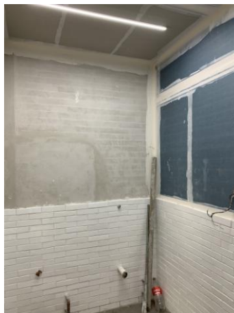
Trabajos de acabados en muros de tablaroca. Fotos: Fernando Nájera Fragoso
