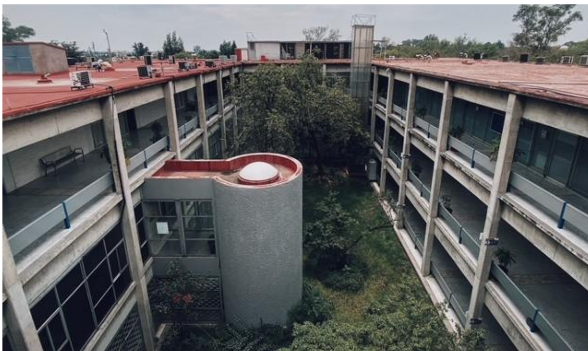
Patio del edificio 2. Foto: Fernando Nájera Fragoso
