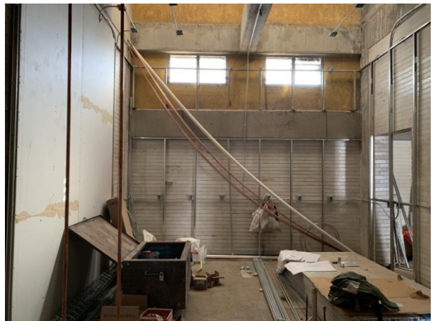
Trabajos de colocación de muros de tablaroca. Foto: Fernando Nájera Frago
