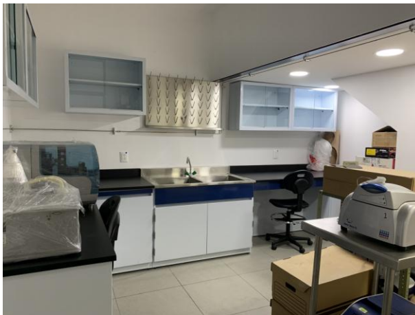
Colocación de mobiliario no fijo. Fotos: Fernando Nájera Fragoso
