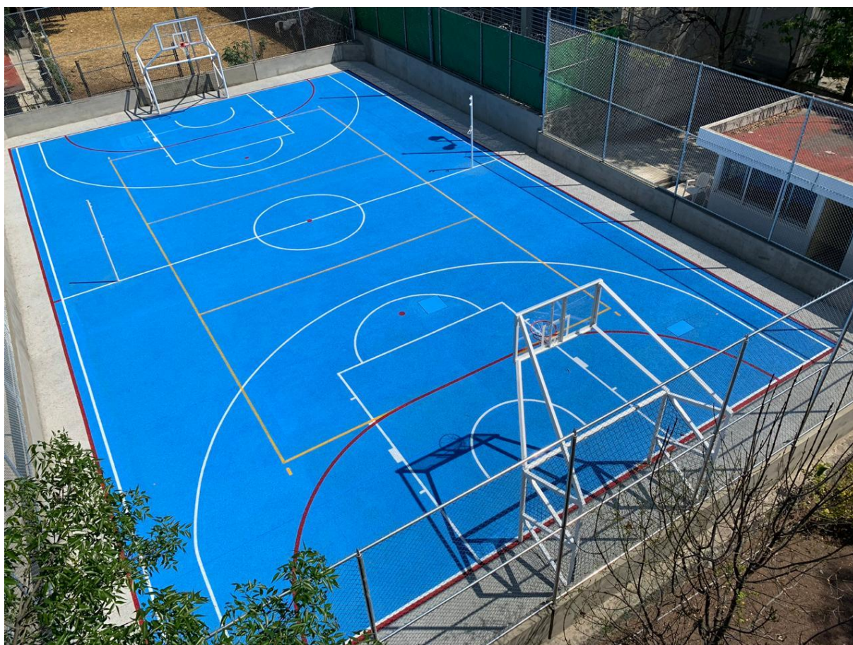
La cancha después de la intervención
