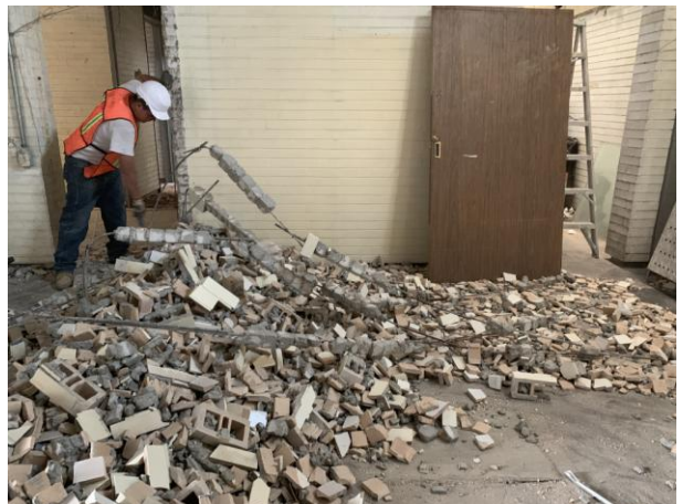
Trabajos de demolición. Foto: Fernando Nájera Fragoso
