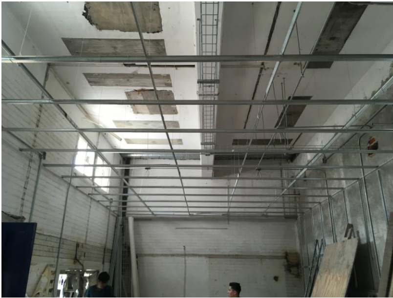
Proceso de Obra
