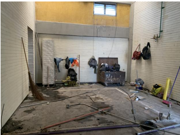
Trabajos de demolición. Foto: Fernando Nájera Fragoso
