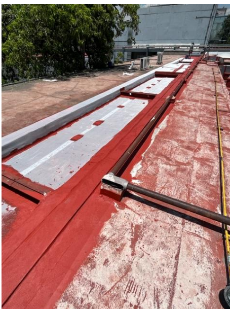
Impermeabilización de azotea en Hospital de Pequeñas Especies. Foto: Fernando Nájera Fragoso
