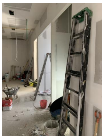
Trabajos de acabados en muros de tablaroca. Fotos: Fernando Nájera Fragoso
