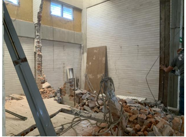
Trabajos de demolición en interior. Foto: Fernando Nájera Frago
