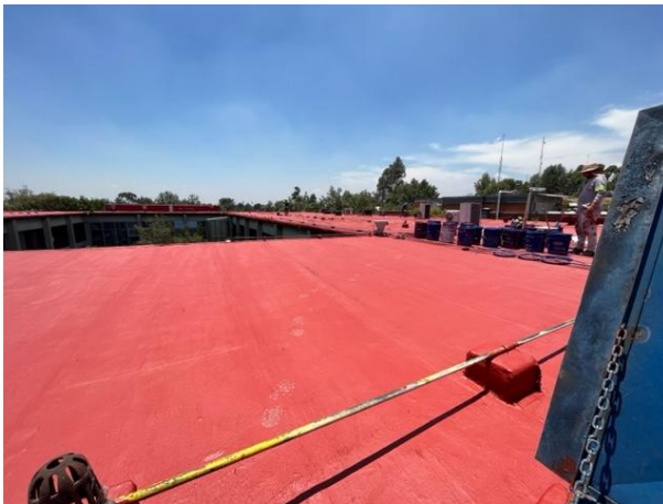
Impermeabilización de azotea en edificio 2. Foto: Fernando Nájera Fragoso
