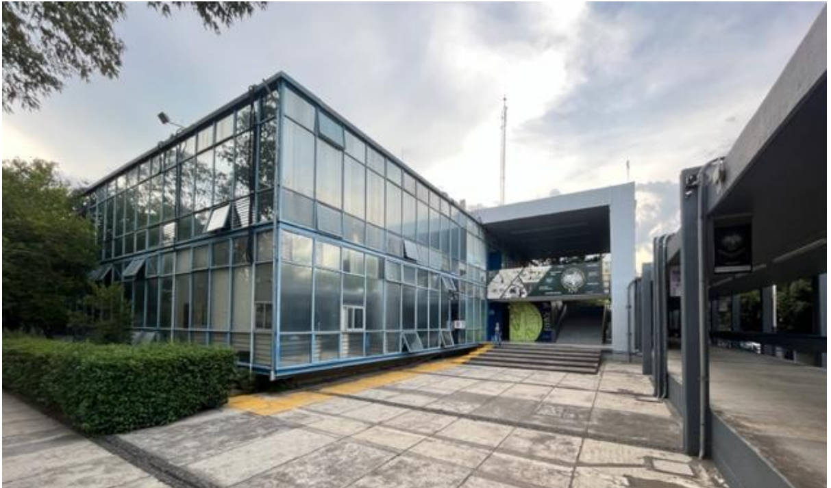
Edificio 1, sede de las oficinas administrativas de la Facultad. Foto: Fernando Nájera Fragoso
