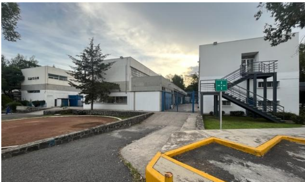
Fachadas oriente de los edificios 6, 7 y 8. Foto: Fernando Nájera Fragoso
