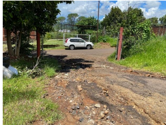
(Imagen 10.2) Acceso secundario.
