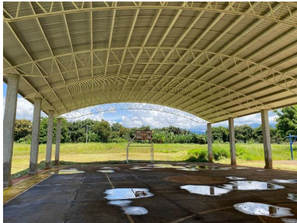
(Imagen 10.11) interior y cubierta de cancha de basquetbol.
