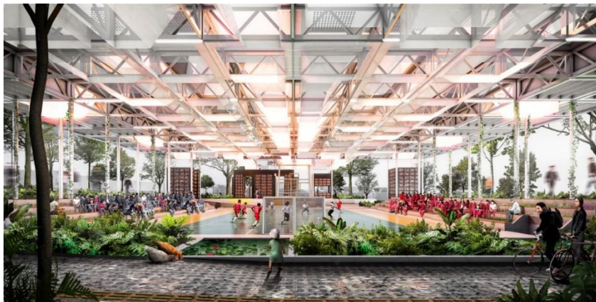
(Imagen 11.6) Estructura metálica que brinda grandes claros.
