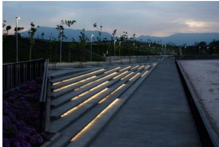
(Imagen 11.10) Iluminación en bancas o gradería.
