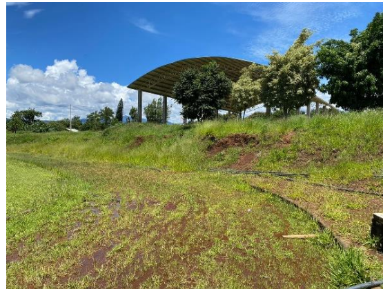
(Imagen 10.9) Talud de desnivel en la parte central del predio.
