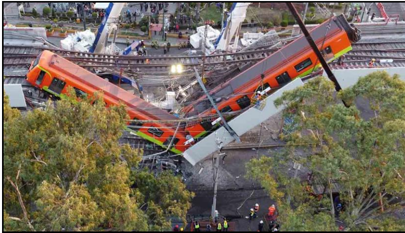
Imagen 2: Fotografía aérea del colapso de la línea 12 del metro CDMX (Sáenz Guzmán, 2021)
