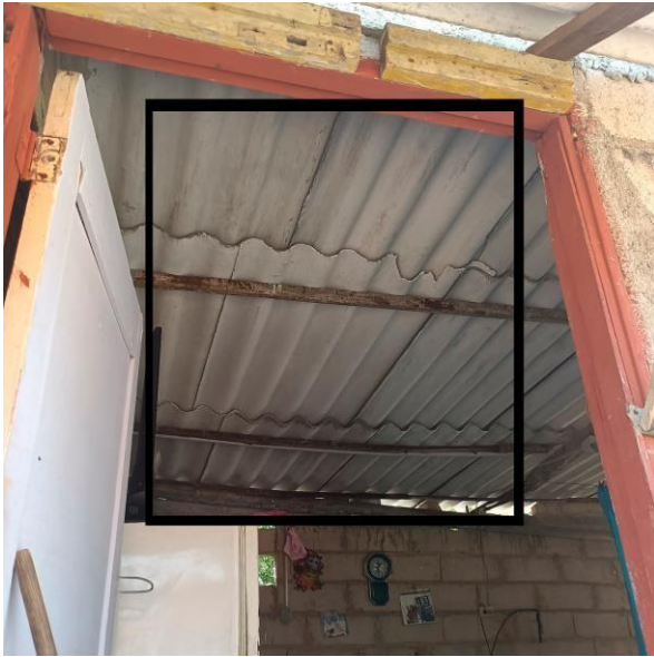
Figura 18. Fotografía de la cubierta de la vivienda. Fuente: Elaboración propia
