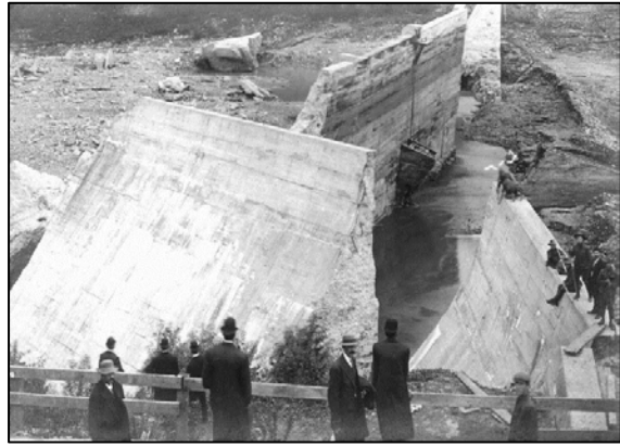
Imagen II.6. Bloques de la cortina después de la falla. (U.S.B.R., 1998)
