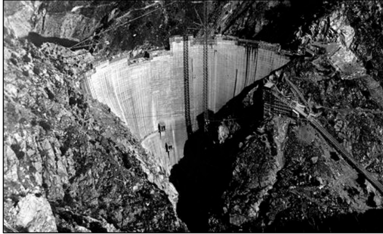
Imagen II.14. Presa Pacoima durante su construcción 1928 (USCOLD, 1992).
