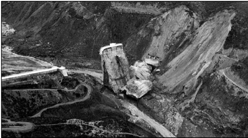
Imagen II.9. Presa San Francis después de la falla (Rogers, 2006)
