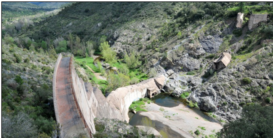
Imagen II.13. Restos de la presa Malpasset (Duffaut, 2013).
