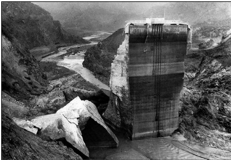
Imagen II.10. Presa San Francis después de la falla (Huber Collection, U of Calif Water Res Center Archives).
