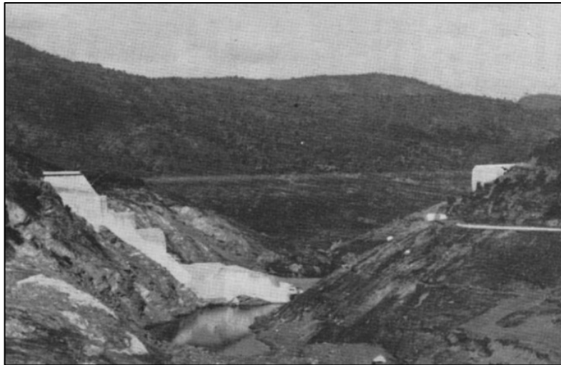
Imagen II.12. Presa Malpasset después de su falla 1959 (Duffaut, 2013).
