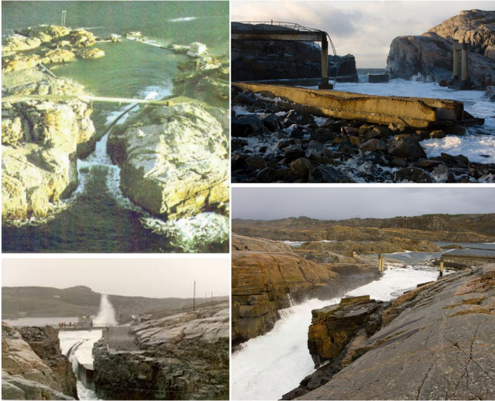
Fig. 12. Izq. Planta de energía de Olas, Tapchan, Noruega en 1985, Der. Planta Tapchan destruida. Adaptado de Toftestallen, Coastal and Oceanic photography in full storm- and in beautiful weather, 2015, http://www.tunliweb.no/SM/alb_havet.htm [34].
