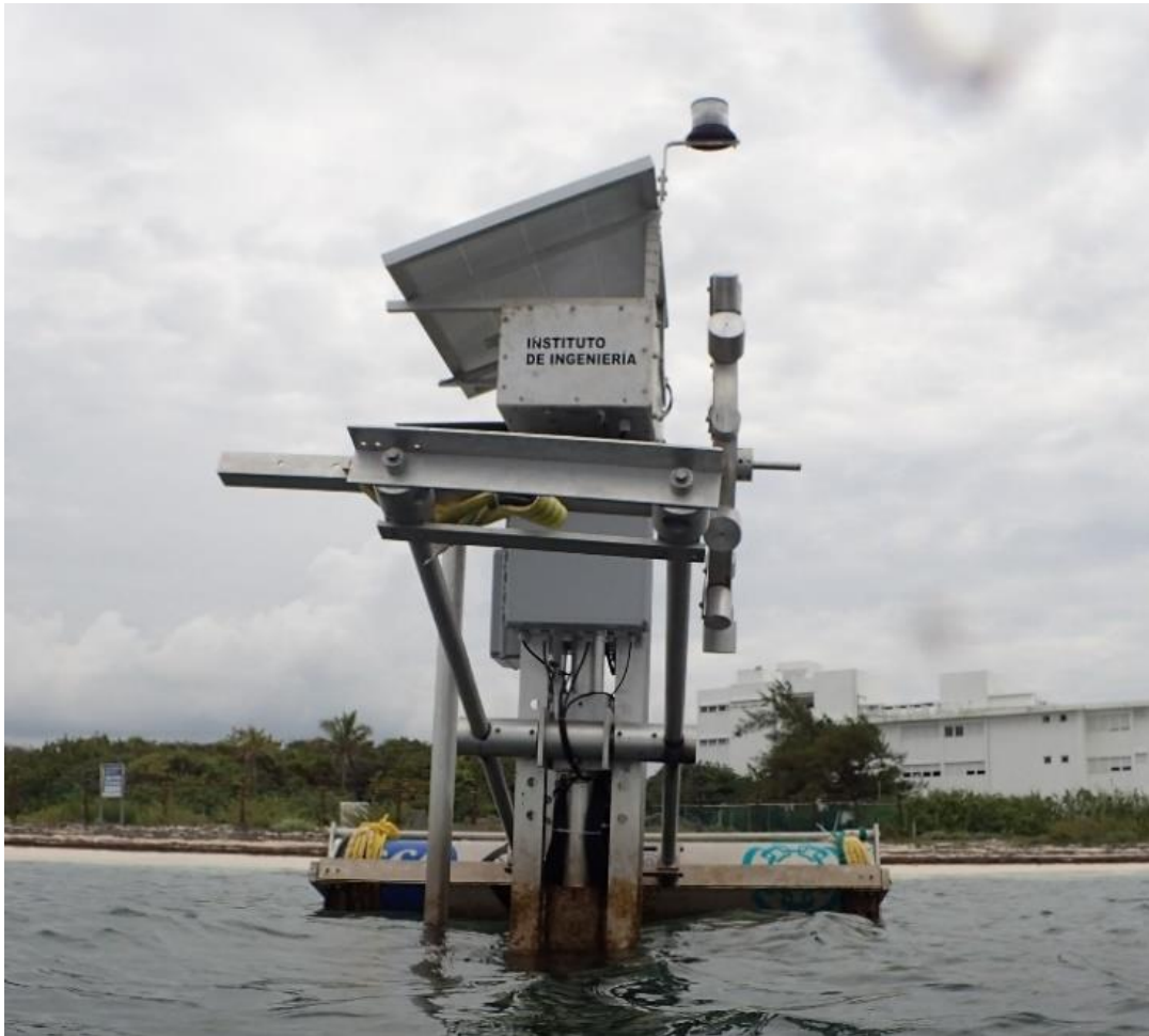
Fig. 29. Panel solar y luz de señalización instalados en el chasis de generación del MICO-1T.
