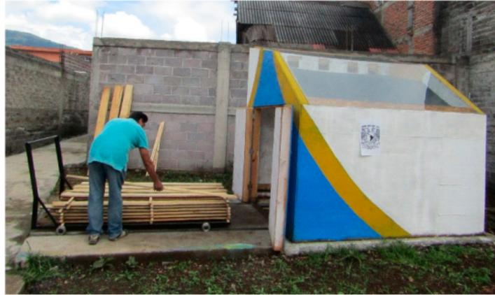
Figura 2.3. Secador solar construido en San Francisco Pichátaro. Obtenido de (López-Sosa *et al.*, 2019)
