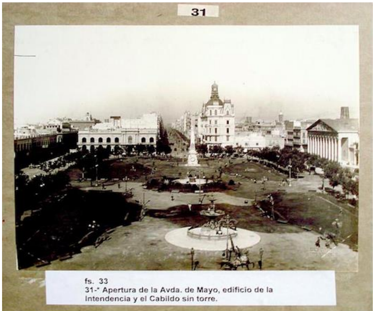
Imagen 4. Plaza de Mayo, 1890s, se puede ver la recién apertura de la Av. de Mayo. Primer Boulevard que promovió Torcuato de Alvear como signo de modernidad, orden y progreso. Tomada de http://www.arcondebuenosaires.com.ar/plaza_mayo.htm
